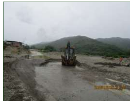
Limpeza de Badenes - Durante Sector 2: Buenos Aires - Loma Larga Progresiva: Km 51+100
