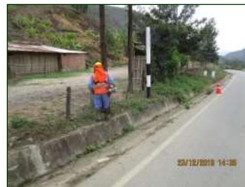
Desbroce de maleza con equipo - Durante Sector 3: Loma Larga - Canchaque Progresiva: 70+500
