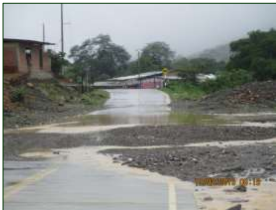
Limpeza de Badenes - Antes Sector 2: Buenos Aires - Loma Larga Progresiva: Km 51+100
