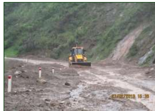
Limpeza de derrumbes menores - Durante Sector 3: Loma Larga - Canchaque Progresiva: Km 72+250
