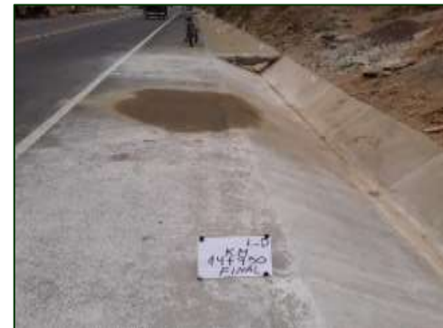
Limpeza de cunetas Manual No Colmatada - Después Sector 1: Empalme 1B - Buenos Aires Progresiva: 14+950
