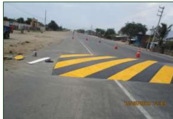
Pintado de resaltos – Después Sector 1: Empalme 1B - Buenos Aires Progresiva: 6+050
