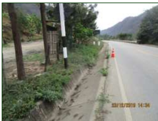
Desbroce de maleza con equipo - Antes Sector 3: Loma Larga - Canchaque Progresiva: 70+500
