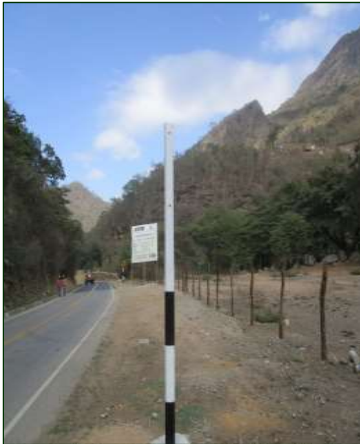
Reposición de Señales Preventivas y reglamentarias - Antes Sector 3: Loma Larga - Canchaque Progresiva: Km 70+900
