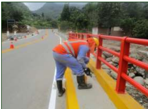
Pintado de sardineles - Durante Sector 3: Loma Larga - Canchaque Progresiva: Km 70+700
