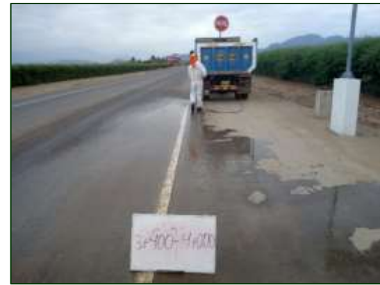
Hidrolimpieza - Durante Sector 1: Empalme 1B - Buenos Aires Progresiva: 3+400
