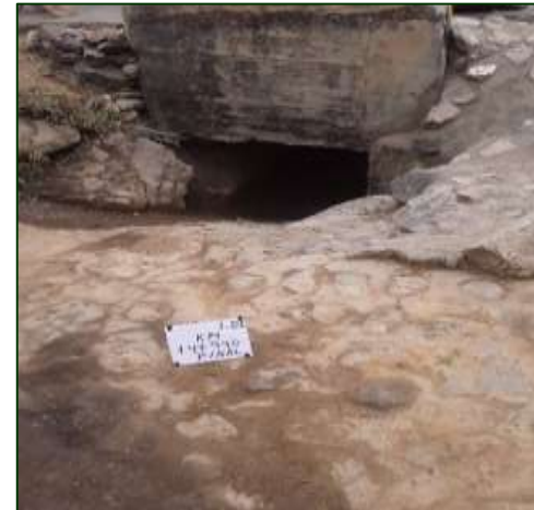
Limpeza de basurales en el derecho de vía - Después Sector 1: Empalme 1B - Buenos Aires Progresiva: 14+940
