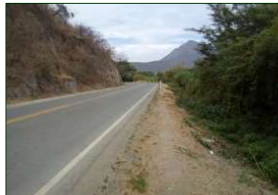
Poda de árboles manual - Después Sector 2: Buenos Aires - Loma Larga Progresiva: 33+100
