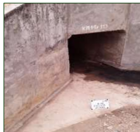
Limpieza de alcantarillas - Después Sector 1: Empalme 1B - Buenos Aires Progresiva: 14+113
