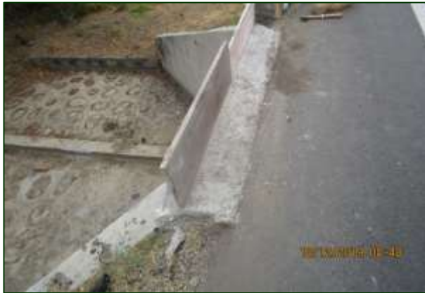
Reparación de parapetos de concreto en alcantarillas - Antes Sector 2: Buenos Aires - Loma Larga Progresiva: 24+600
