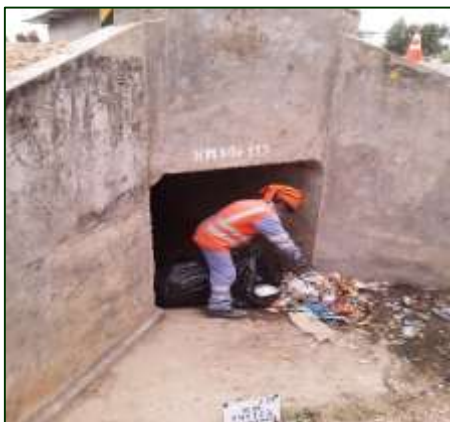
Limpieza de alcantarillas - Durante Sector 1: Empalme 1B - Buenos Aires Progresiva: 14+113
