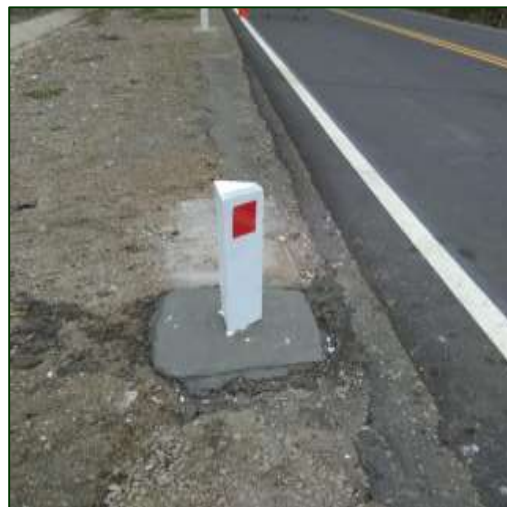
Pintado de delineadores - Después Sector 2: Buenos Aires - Loma Larga Progresiva: Km 30+100
