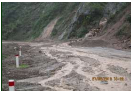
Limpeza de derrumbes menores - Antes Sector 3: Loma Larga - Canchaque Progresiva: Km 72+250
