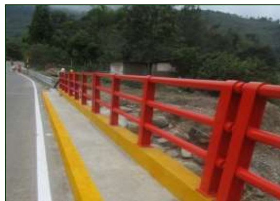
Pintado de sardineles - Después Sector 3: Loma Larga - Canchaque Progresiva: Km 70+700
