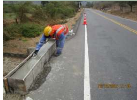
Reparación de parapetos de concreto en alcantarillas - Durante Sector 2: Buenos Aires - Loma Larga Progresiva: 24+600
