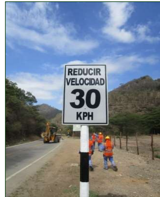
Reposición de Señales Preventivas y reglamentarias - Después Sector 3: Loma Larga - Canchaque Progresiva: Km 70+900
