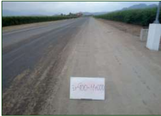
Hidrolimpieza - Antes Sector 1: Empalme 1B - Buenos Aires Progresiva: 3+400
