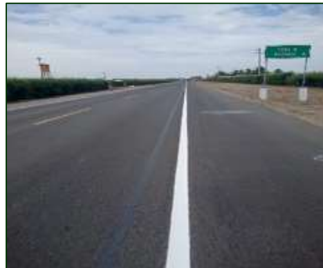
Demarcación de pavimento con pintura de tráfico - Después Sector 1: Empalme 1B - Buenos Aires Progresiva: 3+400
