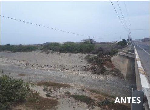
Puente Culebras - Km 312+558
