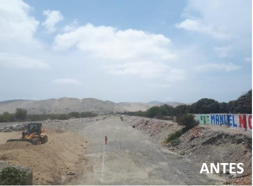
Puente Sechín - Km 376+400
