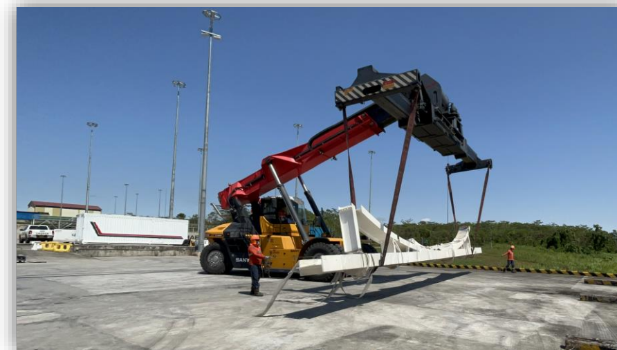
Operación: Recepción de Vigas para la Construcción del Mall de Iquitos. Agosto 2022
