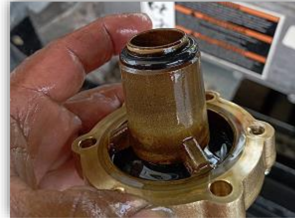
Mantenimiento Correctivo en dispensador de combustible
