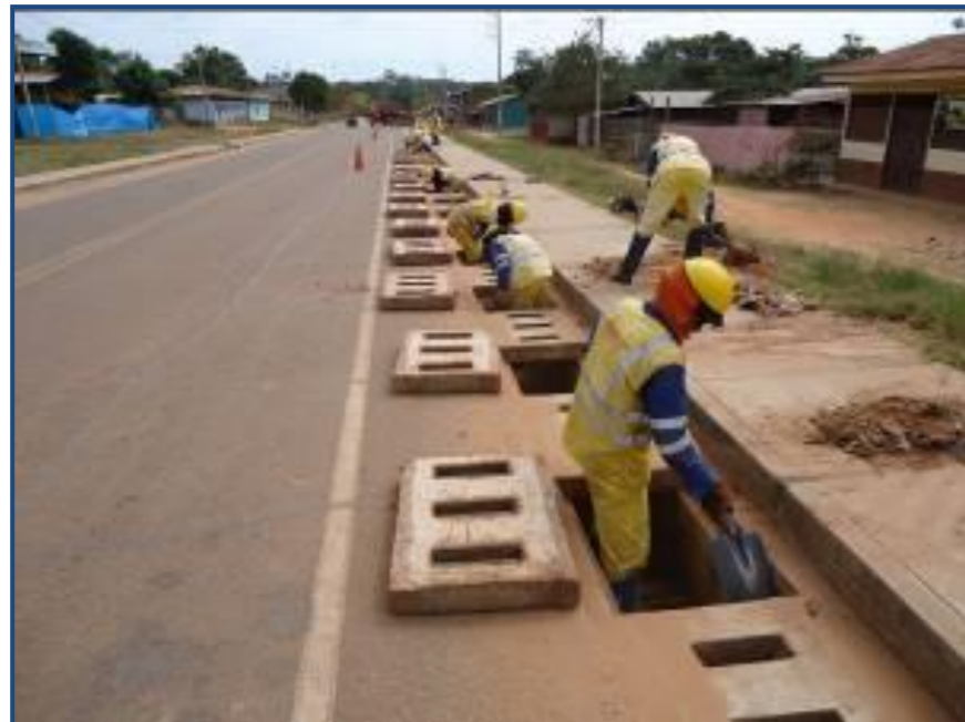
LIMPIEZA DE CUNETAS URBANAS
