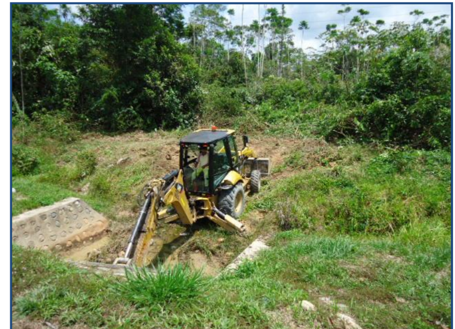
LIMPIEZA DE ALCANTARILLA
