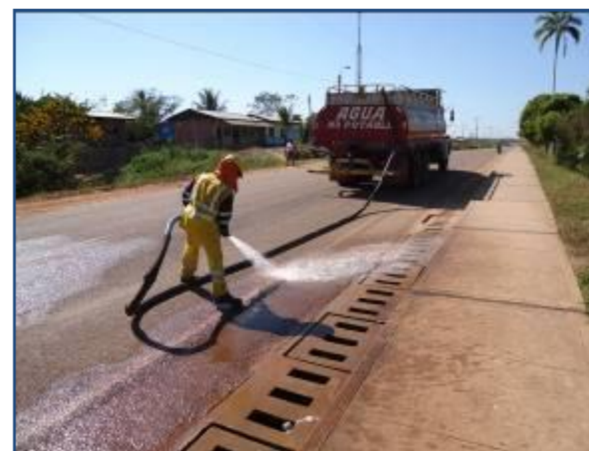
LIMPIEZA DE CALZADA Y BERMA
