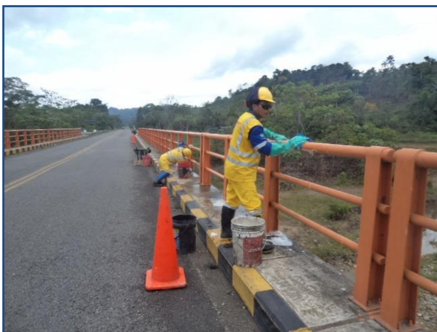
LIMPIEZA DE BARANDAS DE PUENTE
