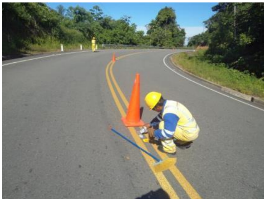
REPOSICIÓN DE TACHAS
