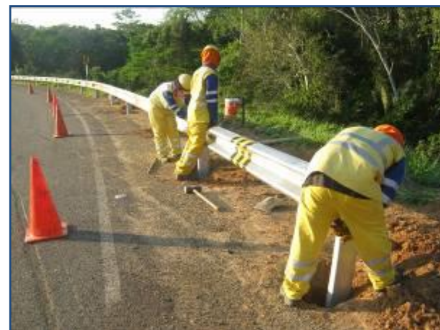
REPOSICIÓN DE GUARDAVÍA
