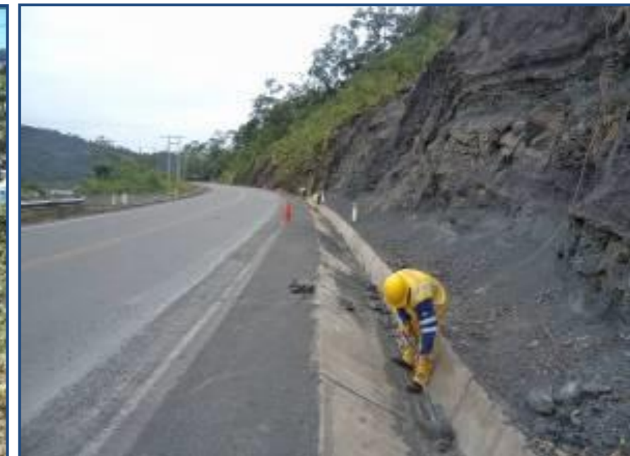
LIMPIEZA DE CUNETAS
