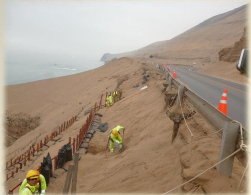
En el tramo Serpentin de Pasamayo existen zonas en las cuales los taludes inferiores se encuentran erosionados por la acción del viento, por ello, con el fin de evitar el deslizamiento del talud inferior se ha procedido a estabilizarlos. Asimismo, se colocaron guardavías en algunos tramos con el fin de evitar el descarrilamiento de vehículos.
