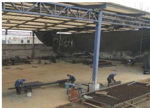
Desmontaje de las calaminas del techo del edificio de carga
