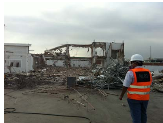
Demolición en la zona del EXTDC.
