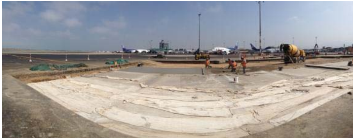
En plenos trabajos de ampliación de Plata forma con concreto.
