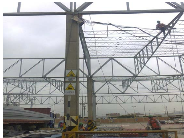
Montaje de la estructura metálica del techo del edificio de carga.
