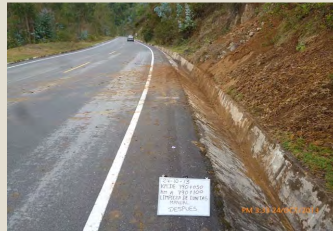
Limpieza de cunetas - Después Sector 7: Abancay – Pte. Cunyac
