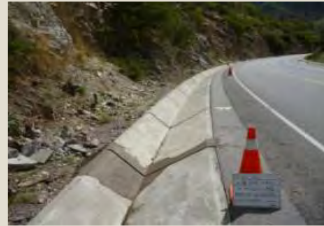
Reparación de cunetas - Después Sector 4: Dv. PampaChiri - Chalhuanca
