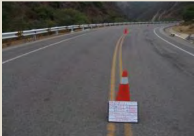
Demarcación de pavimento, Antes Sector 5: Chalhuanca – Emp. Ruta 03S
