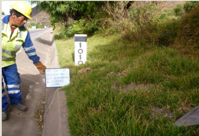
Deterioro de los postes kilométricos (vegetación) – Antes Sector 9: Cusco - Urcos
