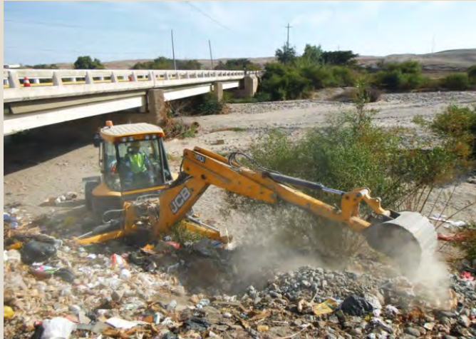
Limpieza de Pontones - Antes Sector 2: Emp. Panamericana - Nazca
