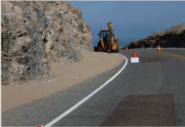
Limpieza de bermas laterales - Antes Sector 1: San Juan – Emp. Panamericana
