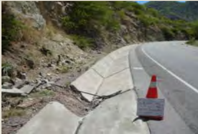
Reparación de cunetas - Antes Sector 4: Dv. PampaChiri - Chalhuanca
