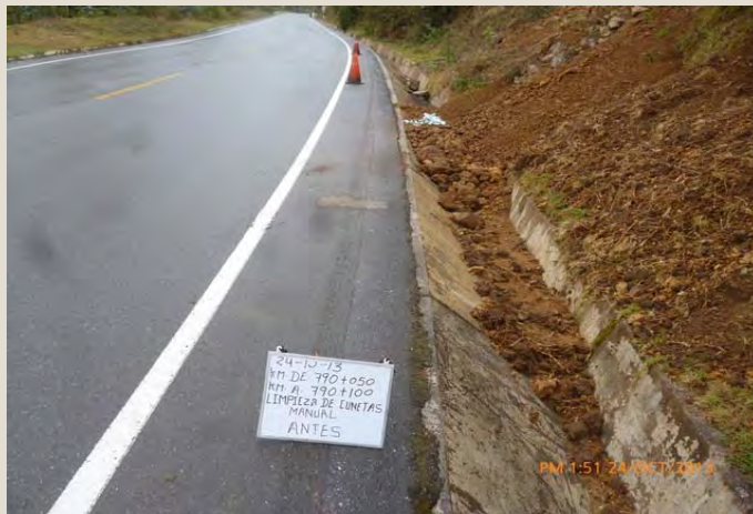
Limpieza de cunetas - Antes Sector 7: Abancay – Pte. Cunyac
