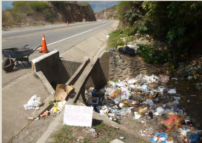
Limpieza de alcantarillas - Antes Sector 6: Emp. R03S - Abancay
