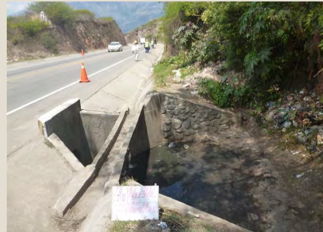
Limpieza de alcantarillas - Después Sector 6: Emp. R03S - Abancay
