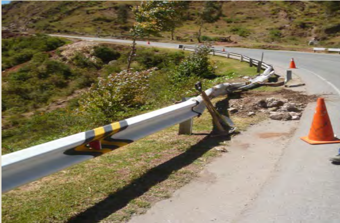
Reposición de Guardavías Metálico - Antes Sector 8: Pte Cunyac - Cusco
