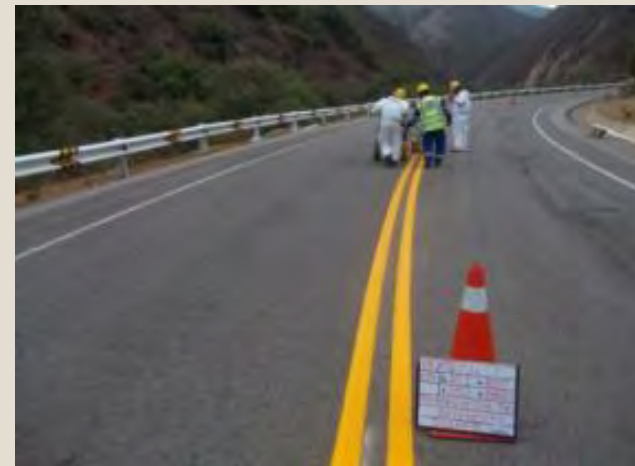
Demarcación de pavimento, Después Sector 5: Chalhuanca – Emp. Ruta 03S
