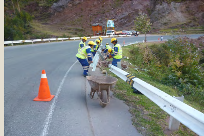
Reposición de Guardavías Metálico - Después Sector 8: Pte Cunyac - Cusco
