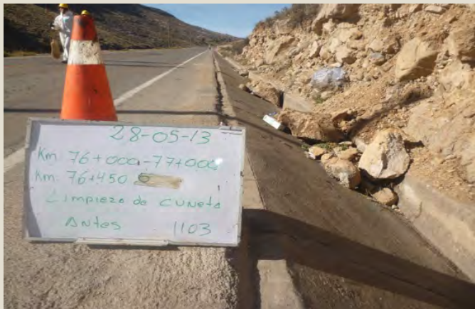
Limpieza de Cunetas - Antes Sector 3: Nazca - Dv. PampaChiri
