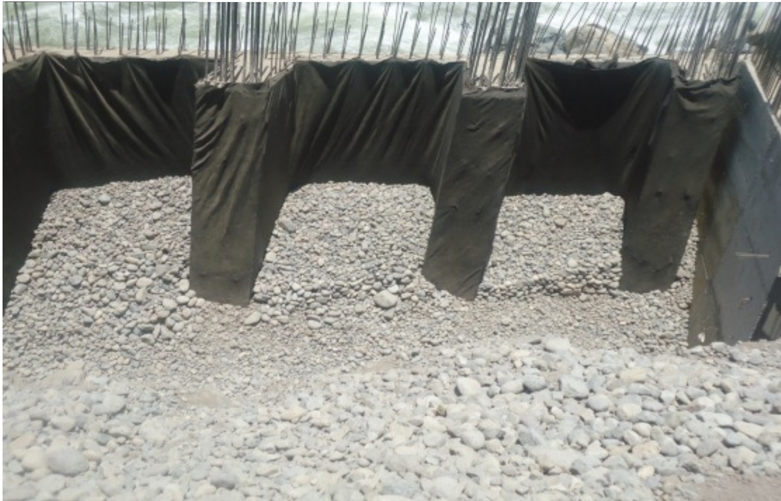
Construcción del Puente Mataka
