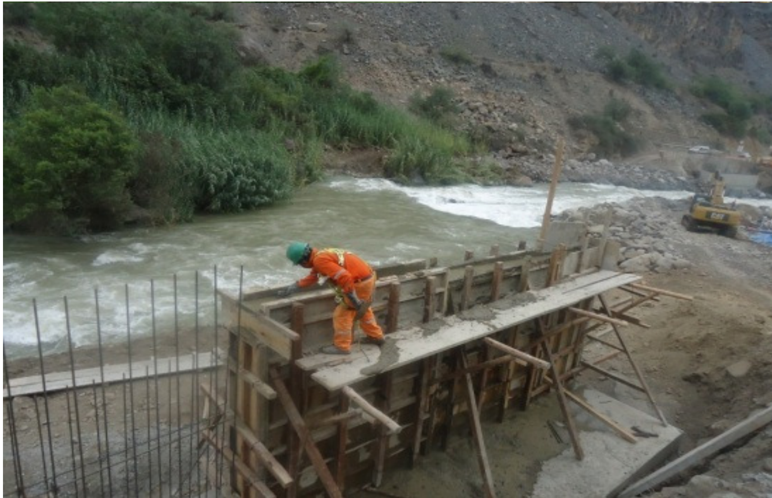
Construcción de muros de contención en los accesos
