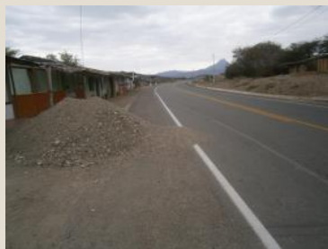
Limpieza de bermas - Antes Sector 1: Panamericana Norte Antigua – Buenos Aires
