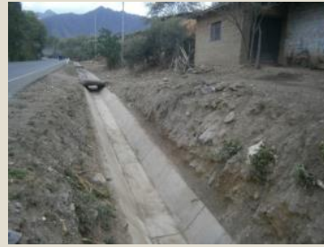
Limpieza de cunetas - Antes Sector 2: Buenos Aires – Piedra Azul
