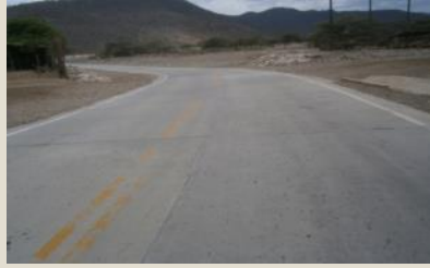
Pintado de señalización horizontal – Antes Sector 2: Buenos Aires – Piedra Azul
