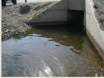
Limpieza de alcantarilla - Antes Sector 2: Buenos Aires – Piedra Azul
