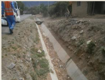
Limpieza de cunetas - Antes Sector 2: Buenos Aires – Piedra Azul
