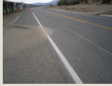
Limpieza de bermas - Antes Sector 1: Panamericana Norte Antigua – Buenos Aires
