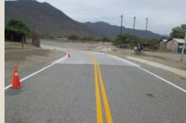
Pintado de señalización horizontal – Después Sector 2: Buenos Aires – Piedra Azul
