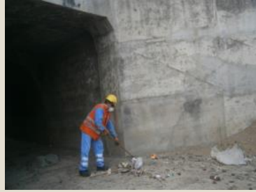
Limpieza de alcantarilla - Antes Sector 1: Panamericana Norte Antigua – Buenos Aires
