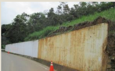
Pintado de muros sucios con propaganda – Antes Sector 3: Piedra Azul – Canchaque
