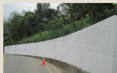
Pintado de muros sucios con propaganda – Después Sector 3: Piedra Azul – Canchaque
