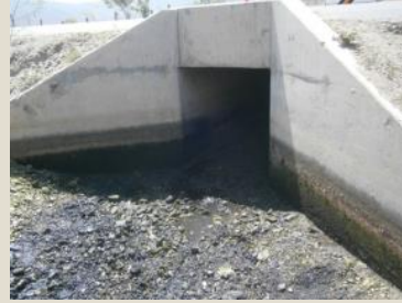
Limpieza de alcantarilla - Después Sector 2: Buenos Aires – Piedra Azul
