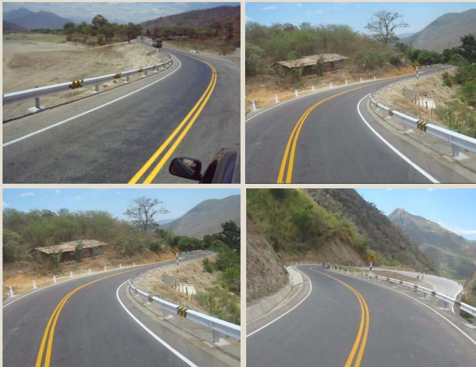
Obras de Rehabilitación del pavimento en el Tramo 2-3
