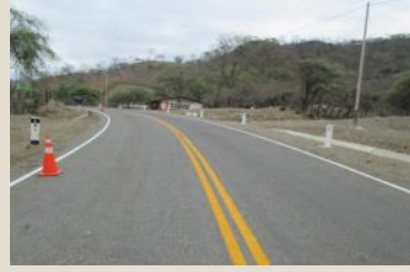
Pintado de señalización horizontal – Después Sector 3: Piedra Azul – Canchaque
