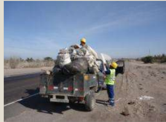
Limpieza del Derecho de Vía - Después Sector 2: Emp. Panamericana - Nazca
