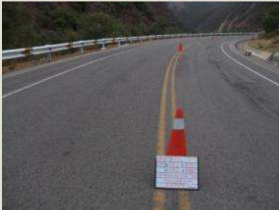
Demarcación de pavimento, Antes Sector 5: Chalhuanca – Emp. Ruta 03S
