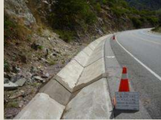
Reparación de cunetas - Después Sector 4: Dv. PampaChiri - Chalhuanca
