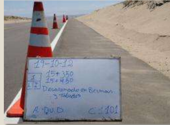
Limpieza de bermas laterales - Después Sector 1: San Juan – Emp. Panamericana
