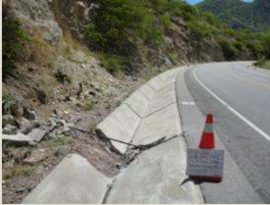
Reparación de cunetas - Antes Sector 4: Dv. PampaChiri - Chalhuanca
