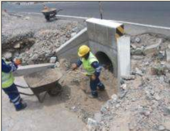
Limpeza de Alcantarillas - Antes Sector 3: Nazca - Dv. PampaChiri
