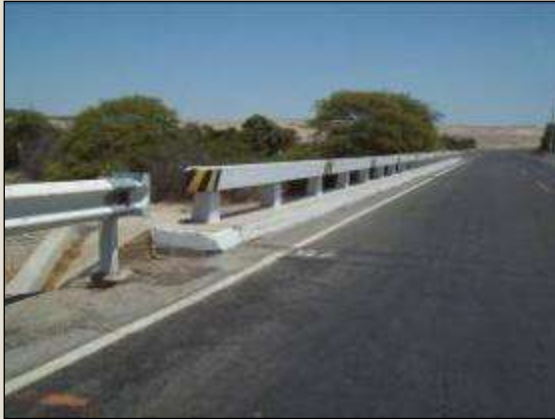
Limpeza de barandas de puentes - Antes Sector 2: Emp. Panamericana - Nazca
