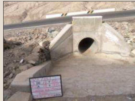
Limpeza de Alcantarillas - Después Sector 3: Nazca - Dv. PampaChiri
