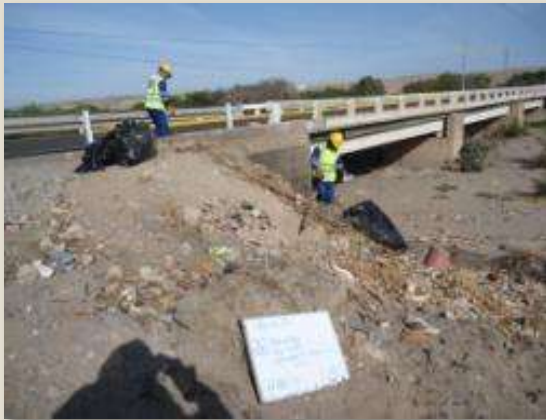
Limpieza del Derecho de Vía - Antes Sector 2: Emp. Panamericana - Nazca
