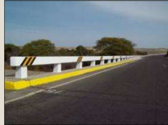
Limpeza de barandas de puentes - Después Sector 2: Emp. Panamericana - Nazca
