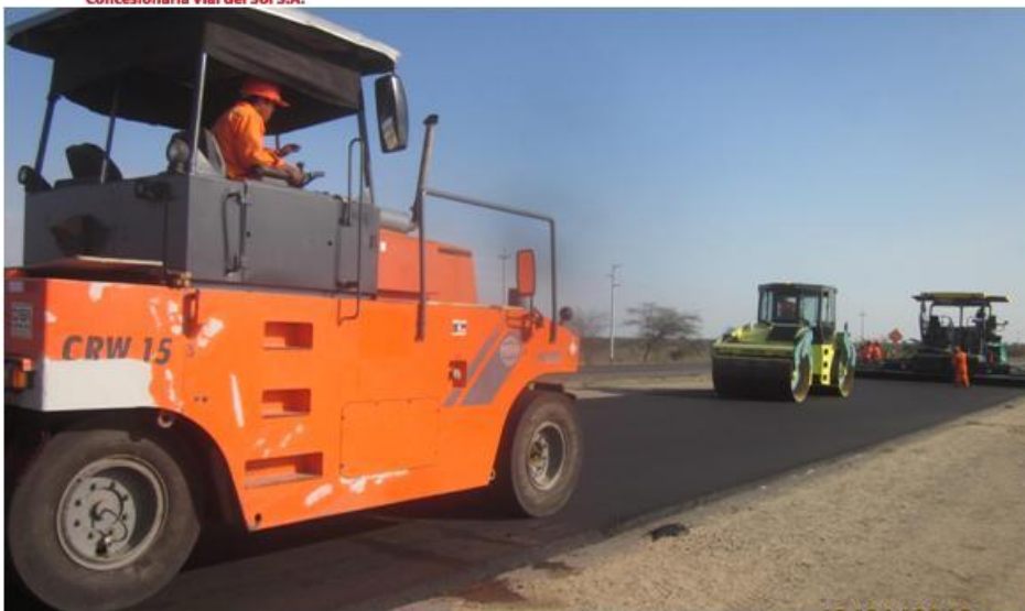
Colocación de 1ra capa de 5cm de la Carpeta Asfáltica km 1016
