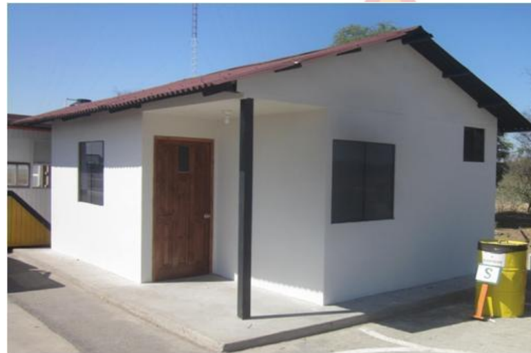
Oficinas para uso de la Policía Nacional del Perú en cada Estación de Peaje con su equipamiento básico
