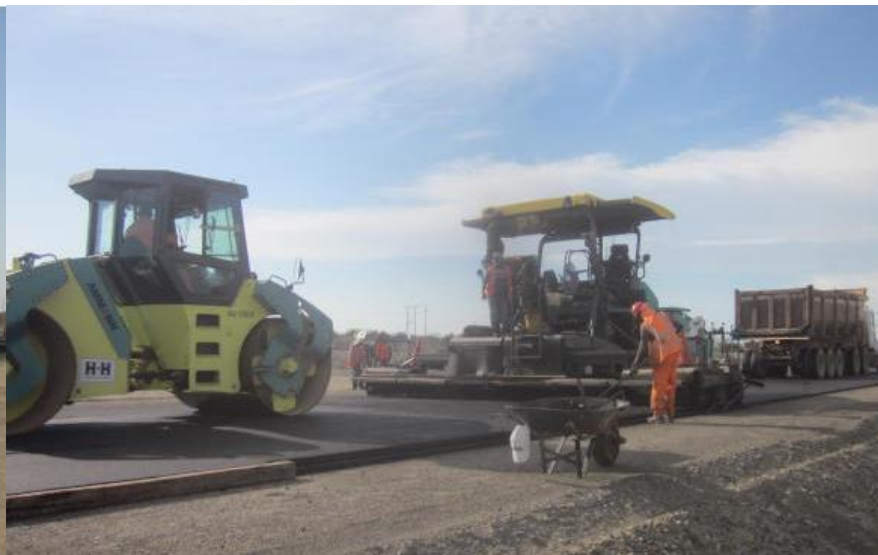
Colocación de 2da capa de 5cm de la Carpeta Asfáltica km 1007
