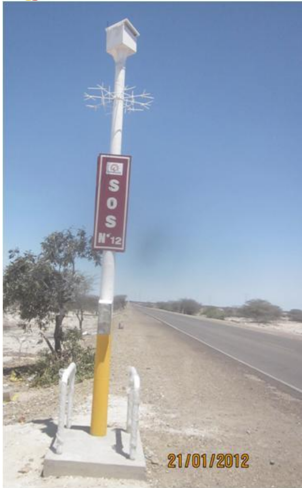
Instalación de los postes SOS desde Sullana hasta Trujillo.
