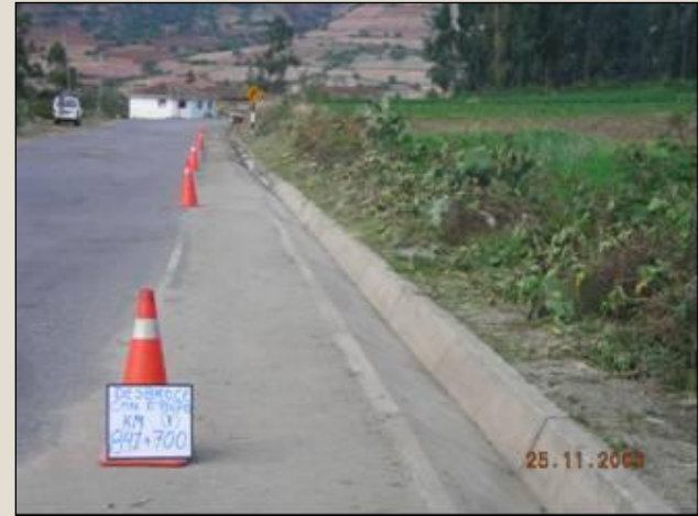
Limpieza de Cuneta
