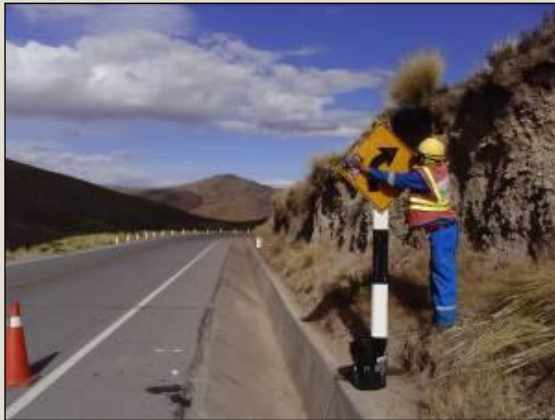
Limpieza de señales preventivas - Antes Sector 3: Nazca - Dv. PampaChiri
