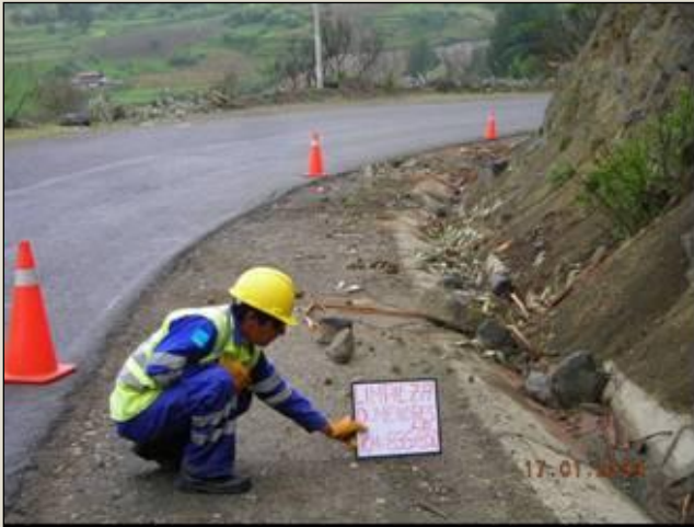
Limpieza de Cuneta
