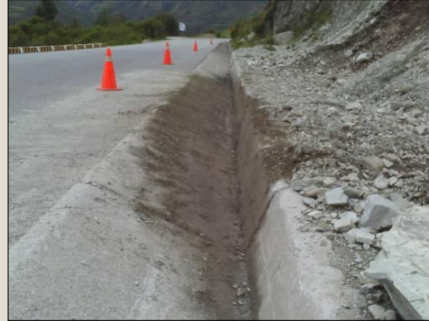
Limpieza de Cuneta
