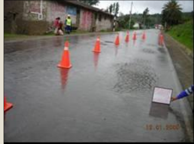
Parches en carpeta asfáltica
