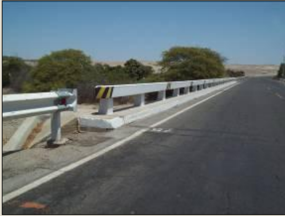
Limpieza de barandas de puentes - Antes Sector 2: Emp. Panamericana - Nazca
