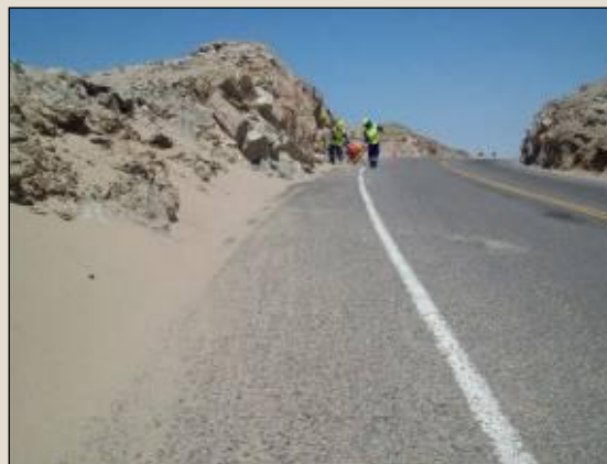
Limpieza de bermas laterales - Después Sector 1: San Juan – Emp. Panamericana
