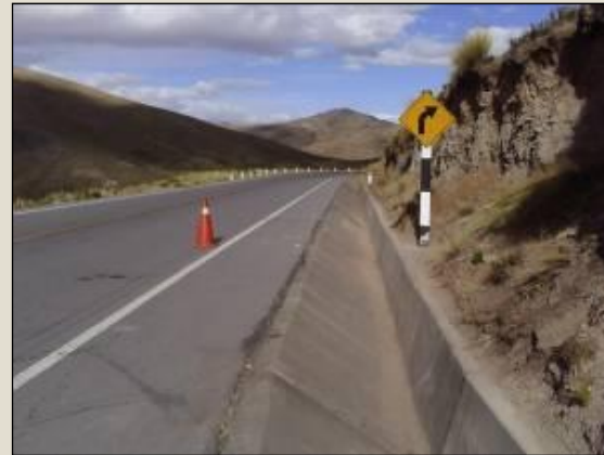
Limpieza de señales preventivas - Después Sector 3: Nazca - Dv. PampaChiri
