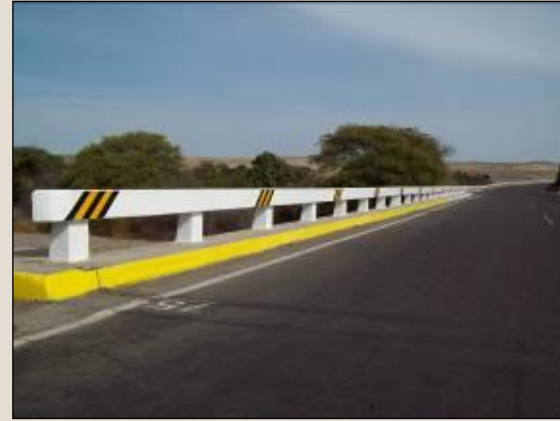
Limpieza de barandas de puentes - Después Sector 2: Emp. Panamericana - Nazca
