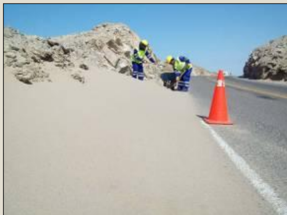
Limpieza de bermas laterales - Antes Sector 1: San Juan – Emp. Panamericana
