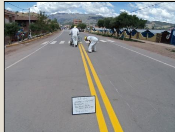
Demarcación de pavimento, Después Progresiva: 943+600 – 943+800 Sector 8
