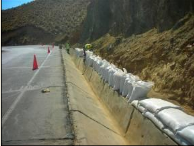
Construcción de Muro Seco
