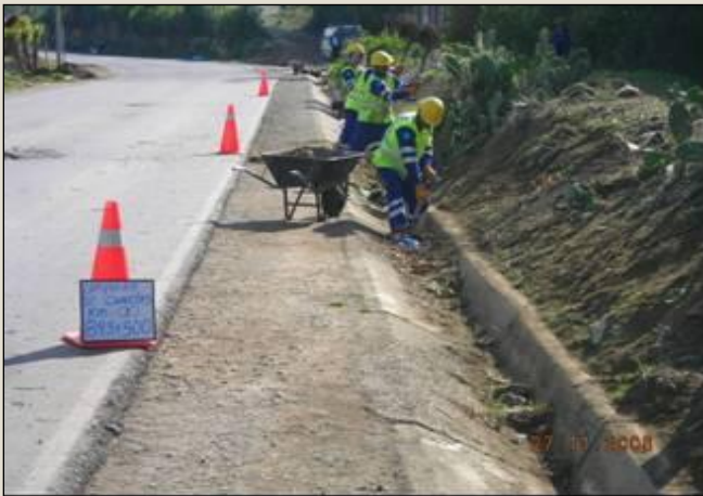
Limpieza de Cuneta
