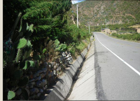
Limpieza de cunetas - Después Sector 4: Dv. PampaChiri - Chalhuanca
