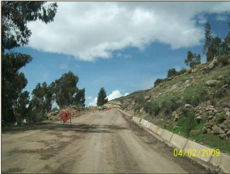
Trabajos en carpeta
