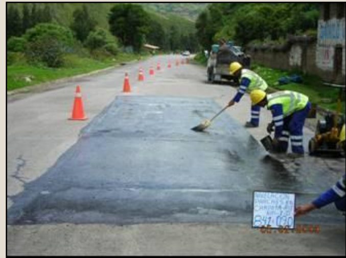
Parches en carpeta asfáltica
