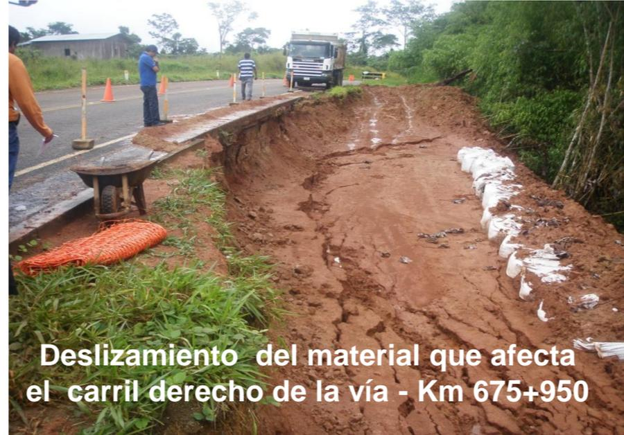
Deslizamiento del material que afecta el carril derecho de la vía - Km 675+950
