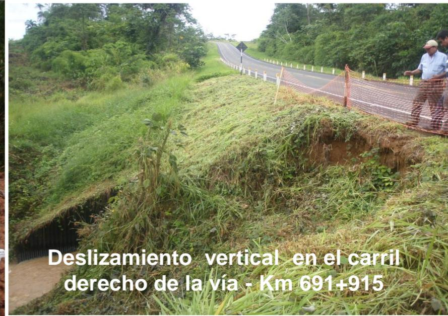
Deslizamiento vertical en el carril derecho de la vía - Km 691+915
