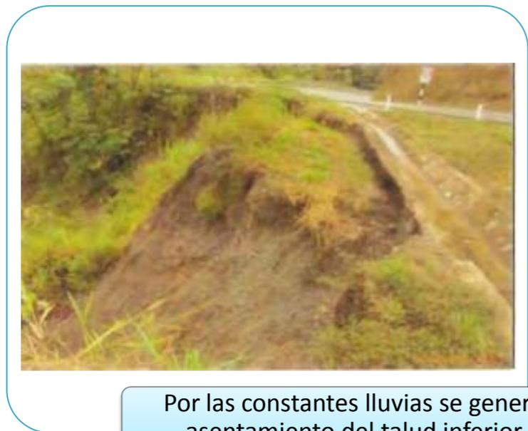
Por las constantes lluvias se generó asentamiento del talud inferior afectando 3 paños de cunetas.
