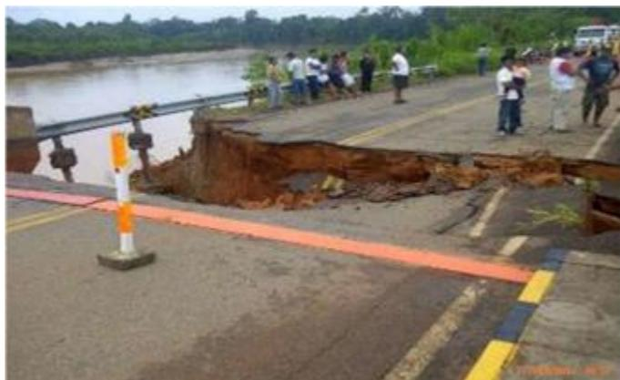
Pérdida de la plataforma por erosión de la estructura..
