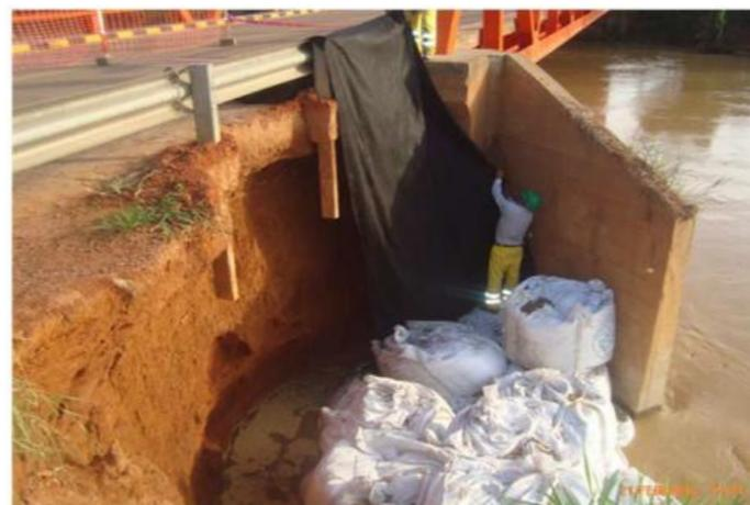
Colocación de geobolsas para protección de estribo izquierdo, aguas arriba.
