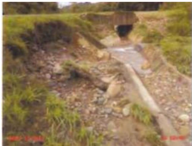
Por las constantes lluvias se generó el desplazamiento de talud inferior aledaño al cabezal de la alcantarilla.
