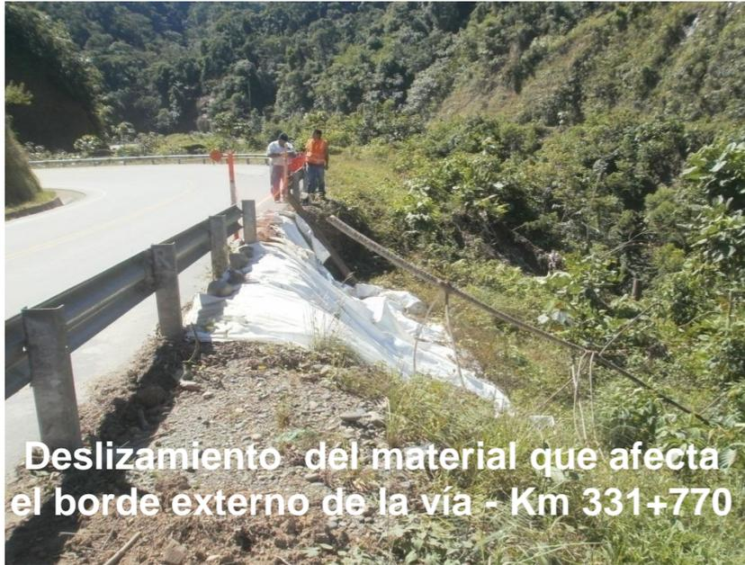
Deslizamiento del material que afecta el borde externo de la vía - Km 331+770
