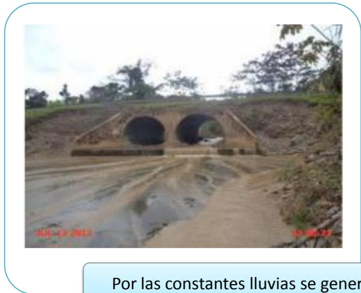
Por las constantes lluvias se generó deslizamiento del talud inferior.
