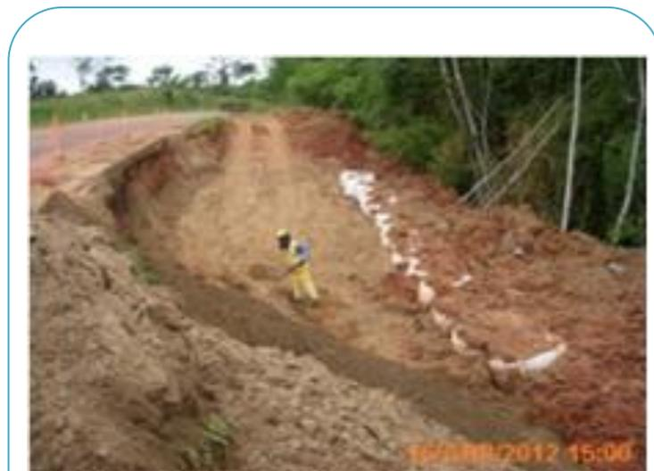
Por las constantes lluvias se generó asentamiento del talud inferior. Colapso de 6 paños de bordillos.
