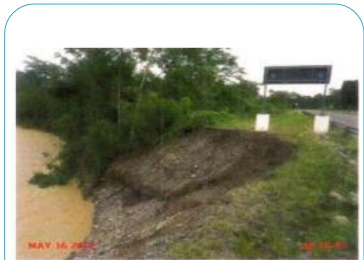
Por las constantes lluvias se generó deslizamiento del talud inferior.
