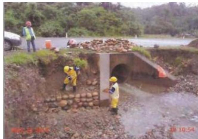
Excavación, acopio y traslado de bolonería. Colocación de mampostería de piedra.
