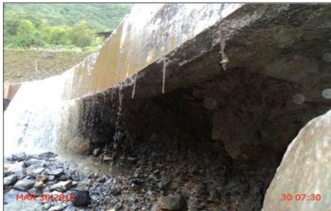
Debido a las constantes lluvias ocurrió un deslizamiento del talud superior que afectó el badén.
