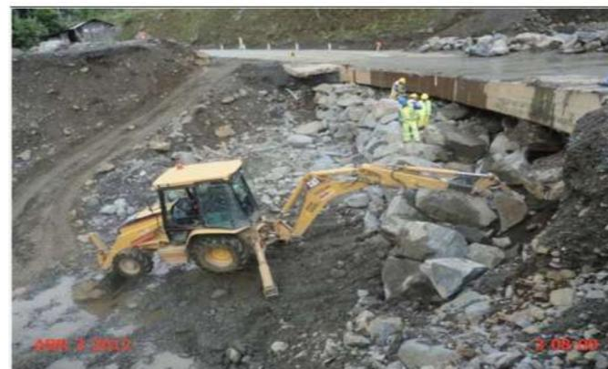
Colocación de bolonería para que sirva de traba y cimentación en la base del badén.
