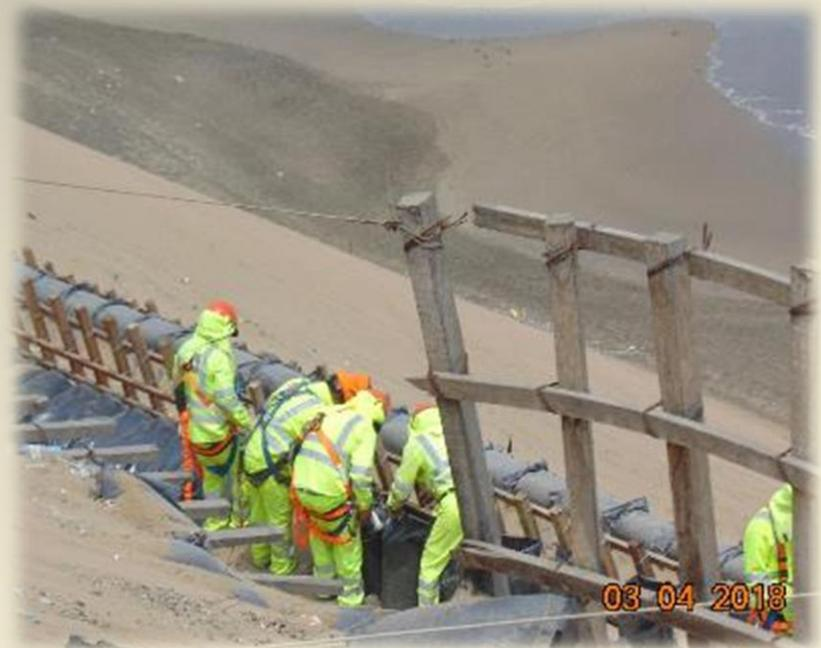
En el tramo Serpentín de Pasamayo existen zonas en las cuales los taludes inferiores se erosionan por la acción del viento, por ello, con el fin de evitar la erosión del talud inferior Norvial, utiliza un sistema andenerías para protegerlos.
