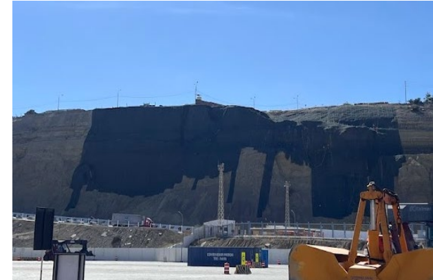
Sistema de contención de derrumbes en cerro colindante a TPE
