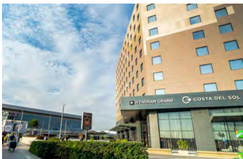
Inicio de operación del Hotel Costa del Sol Wyndham Grand (5 estrellas)
