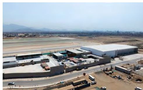
Inició la operación la Zona de Carga Sur
