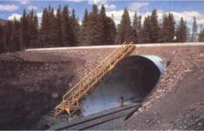
Sistema de Falso túnel con estructuras metálicas.
