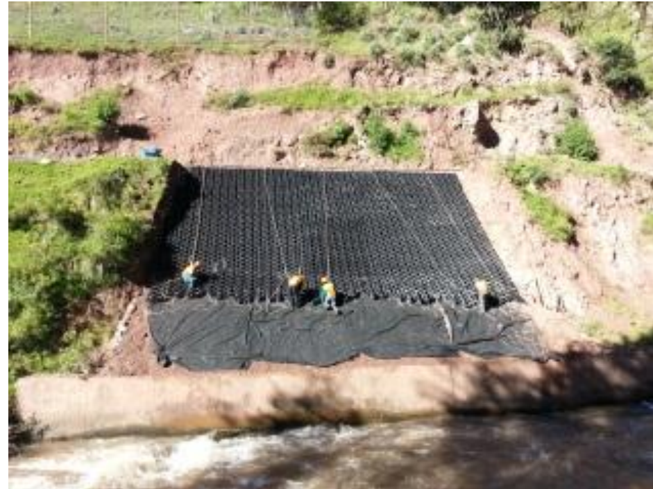
Sub División 7 Estabilización de talud con geoceldas Km. 44+230
