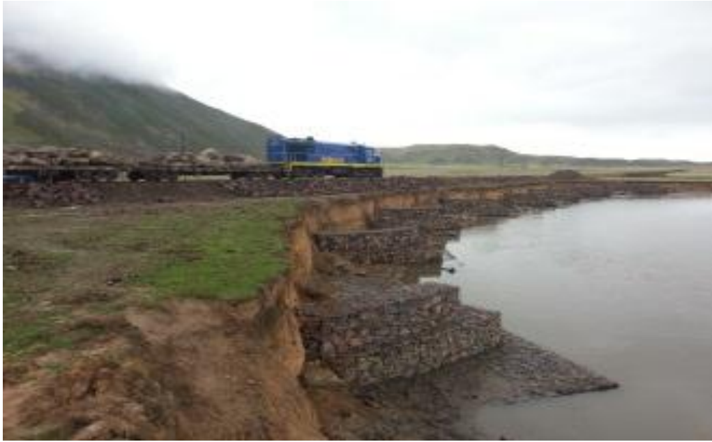
Sub División 6 Construcción de Espigones y enrocado Km. 123+800
