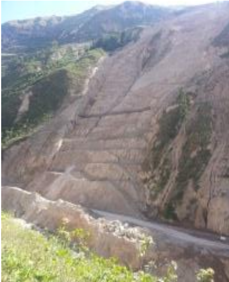
Habilitación de Vía, Banquetas y drenaje Km. 49+600
