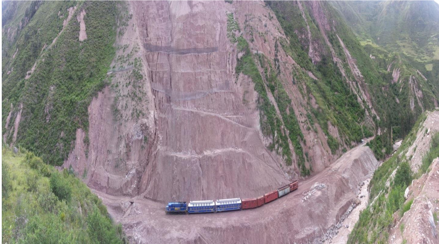
Imagen panorámica actual de Km. 49
