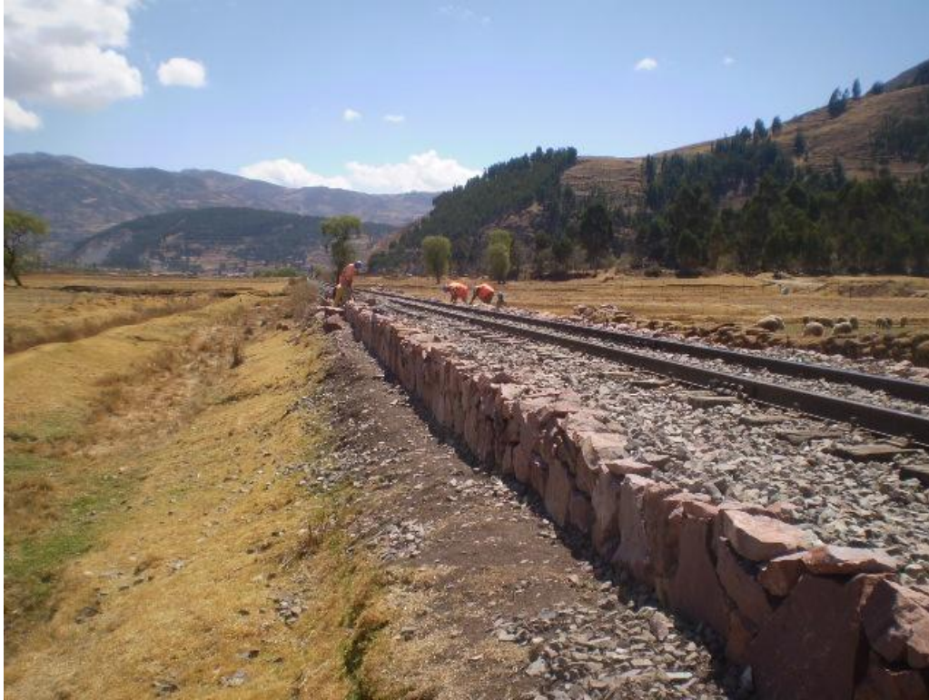
Muros de piedra – pretiles
