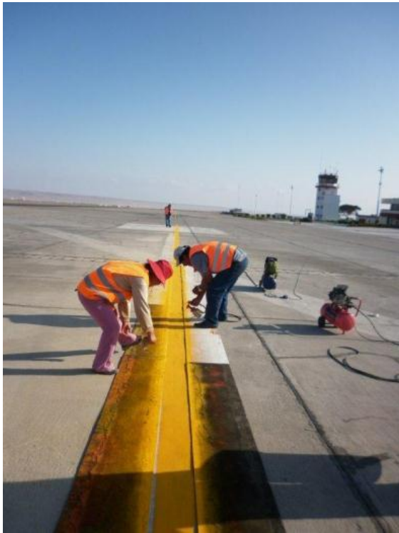
Señalización horizontal en área de movimiento.
