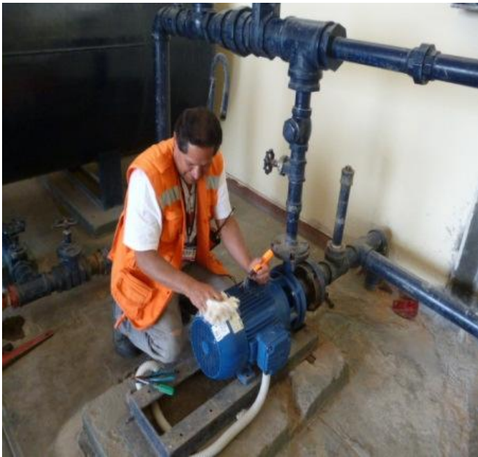
Mantenimiento de bomba de agua.
