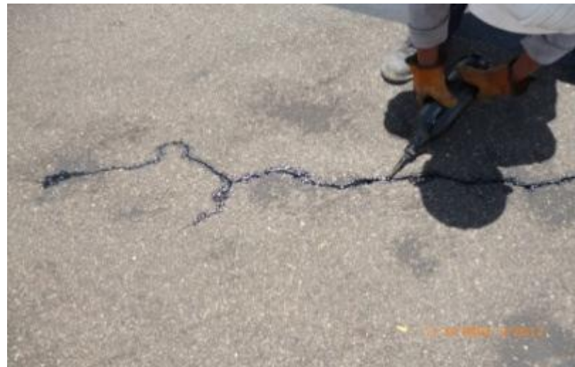
Tratamiento de grietas/fisuras.
