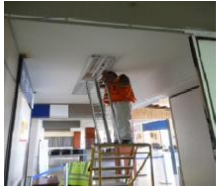
Mantenimiento de luminarias.
