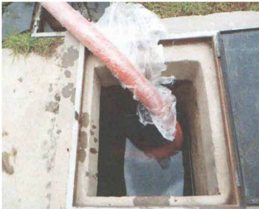
Limpieza de pozo séptico.
