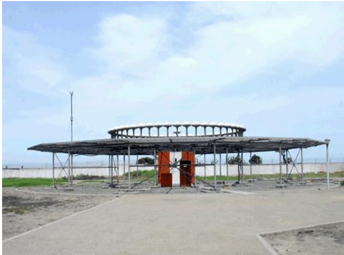
Ubicación del Nuevo JCL DVOR/DME en la FREQ. 116.9/CH 116X del Aeropuerto Internacional Jorge Chavez, la cual entró en vigencia el día 21.06.2018.
