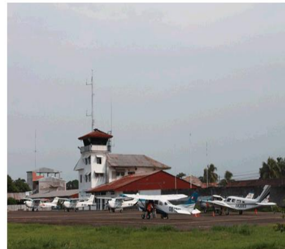
Aeropuerto de Yurimaguas, obra: "Parchado, tratamiento de grietas, fisuras, sellado asfáltico y señalización del área de movimiento de aeronaves del aeropuerto",
