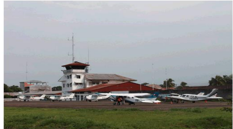
AEROPUERTO DE YURIMAGUAS Obras en área de movimiento de aeronaves
