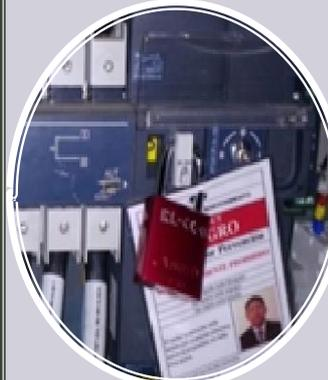
Implementación de **lock out y tag out** (candado y tarjeta de bloqueo) para el bloqueo de equipos al realizar trabajos de mantenimiento, lo que permite garantizar la seguridad del personal
