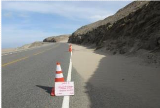
Limpeza de calzada y bermas - Antes Sector 1: San Juan – Emp. Panamericana
