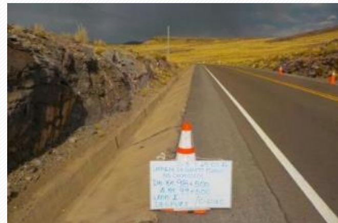
Limpieza de cunetas - Después Sector 3: Nazca - Dv. PampaChiri
