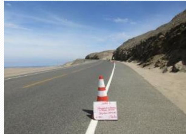
Limpeza de bermas laterales - Después Sector 1: San Juan – Emp. Panamericana
