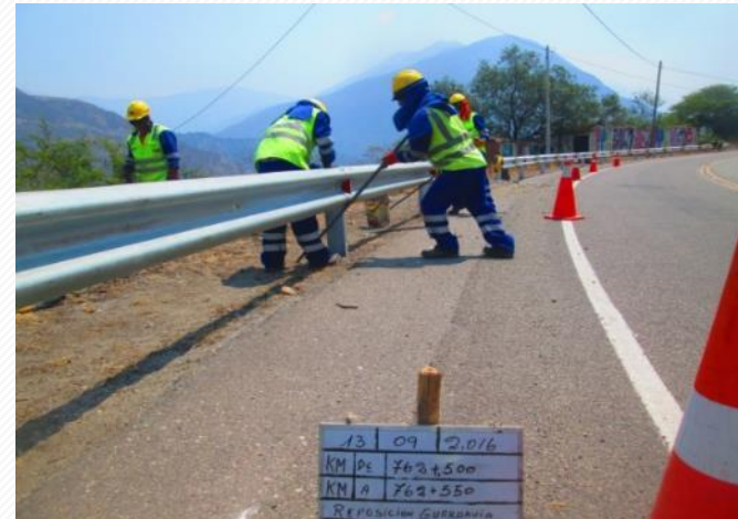
Reposición y reparación de guardavías - Después Sector 6: Emp. R03S - Abancay
