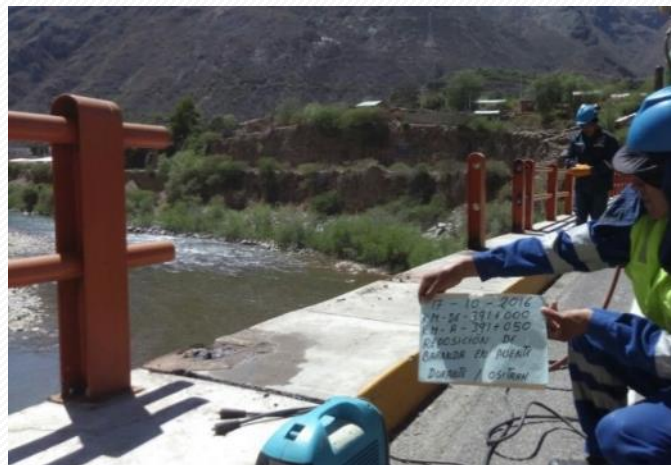
Reposición de barandas - Antes Sector 5: Chalhuanca – Emp. Ruta 03S
