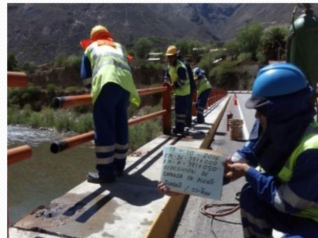
Reposición de barandas - Después Sector 5: Chalhuanca – Emp. Ruta 03S
