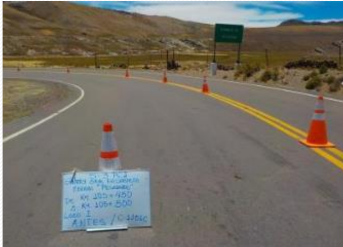
Peladuras - Antes Sector 3: Nazca - Dv. PampaChiri
