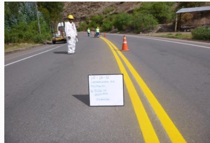
Deterioro Marcas en Pavimento - Después Sector 9: Cusco - Urcos
