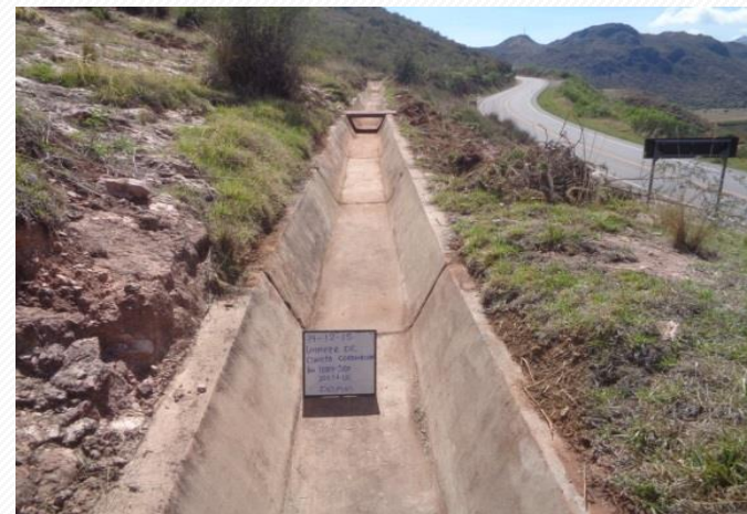
Limpieza de cunetas - Después Sector 9: Cusco - Urcos
