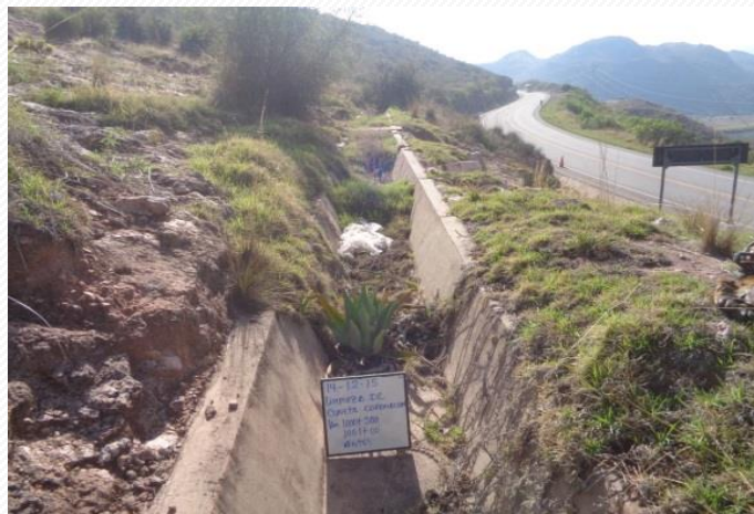
Limpieza de cunetas - Antes Sector 9: Cusco - Urcos
