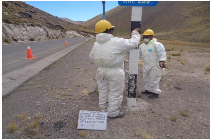
Deterioro y limpieza de los soportes de señal-Antes Sector 4: Dv. PampaChiri - Chalhuanca
