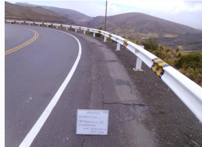
Deterioro y limpieza de defensas metálicas - Después Sector 3: Nazca - Dv. PampaChiri
