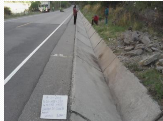
Limpieza de Cunetas - Después Sector 5: Chalhuanca – Emp. Ruta 03S
