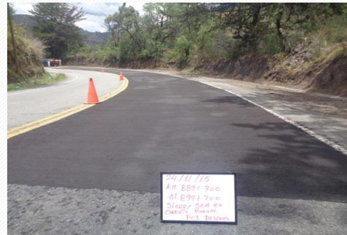
Tratamiento de peladuras - Después Sector 8: Pte Cunyac - Cusco
