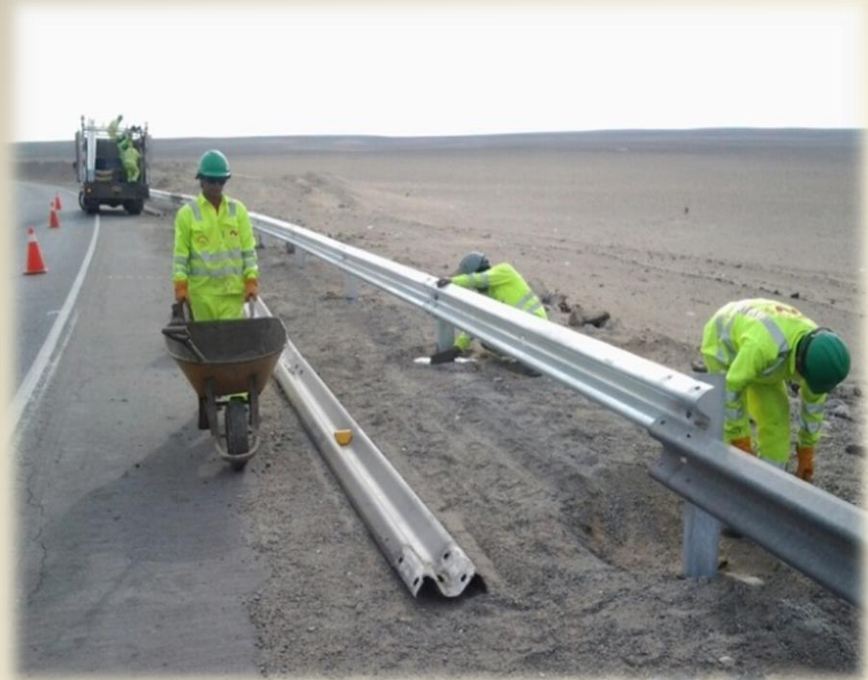
Cambio de guardavías en Km 152+000
