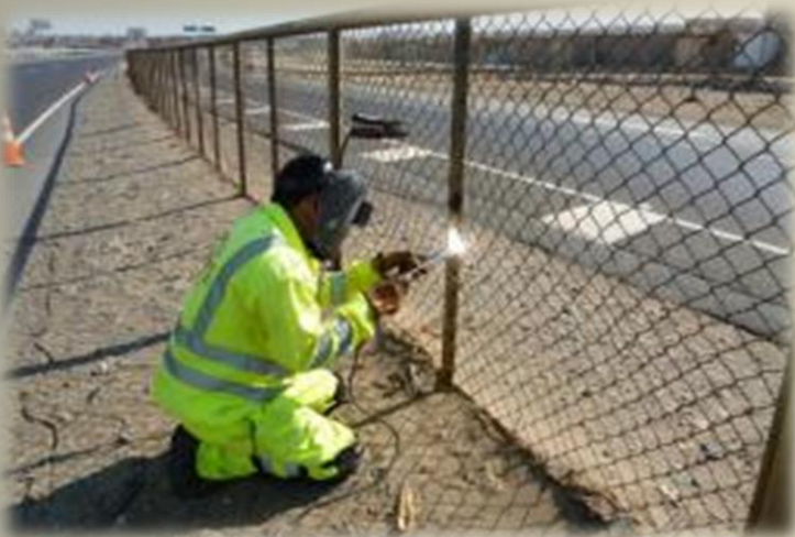
Reparación mallas metálicas. Tramo: Huacho - Pativilca
