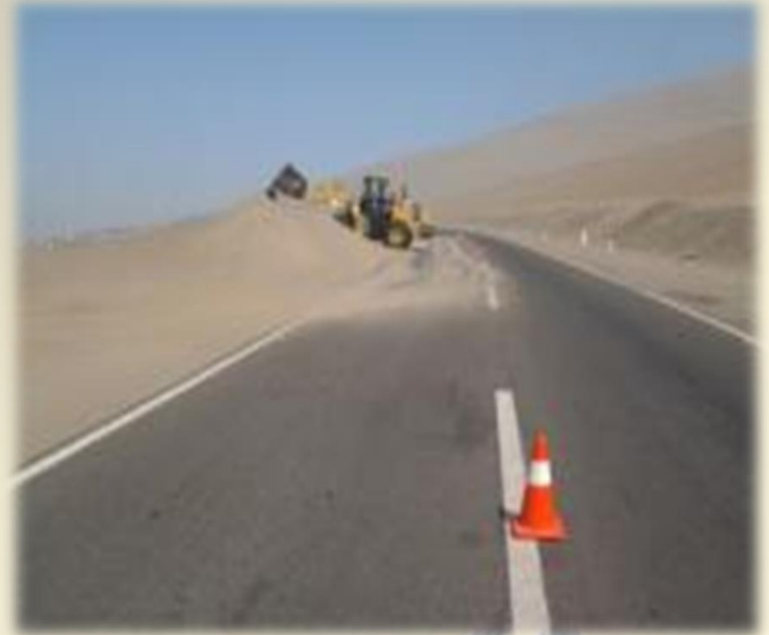
Trabajos de desarenado con máquina
