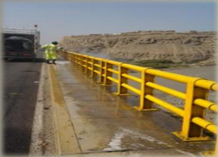
Reparación y limpieza de baranda de puentes. Tramo: Huacho - Pativilca
