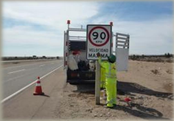
Trabajos de reparación de señales Tramo: Rio Seco – Huacho
