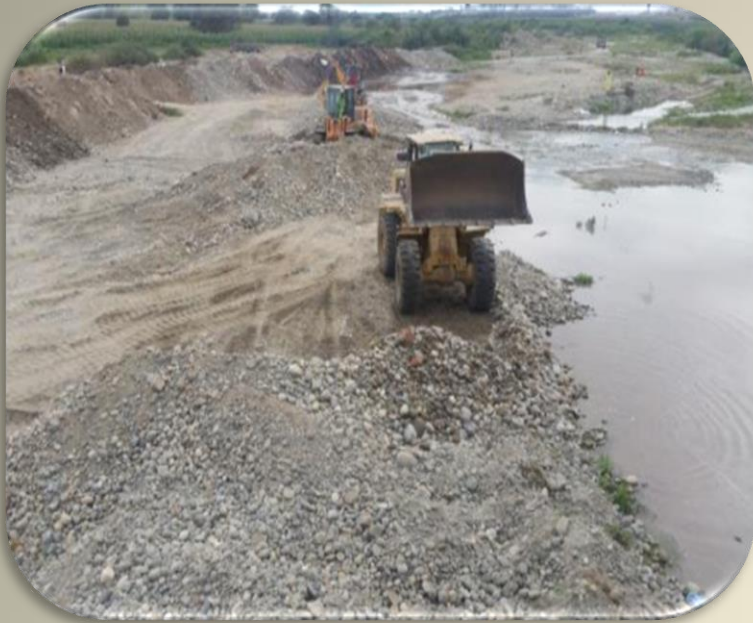
Limpieza del cauce del rio Chancay, aguas arriba y aguas abajo
