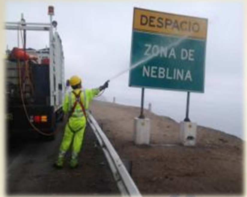
Trabajos de limpieza de señales Tramo: Serpentín
