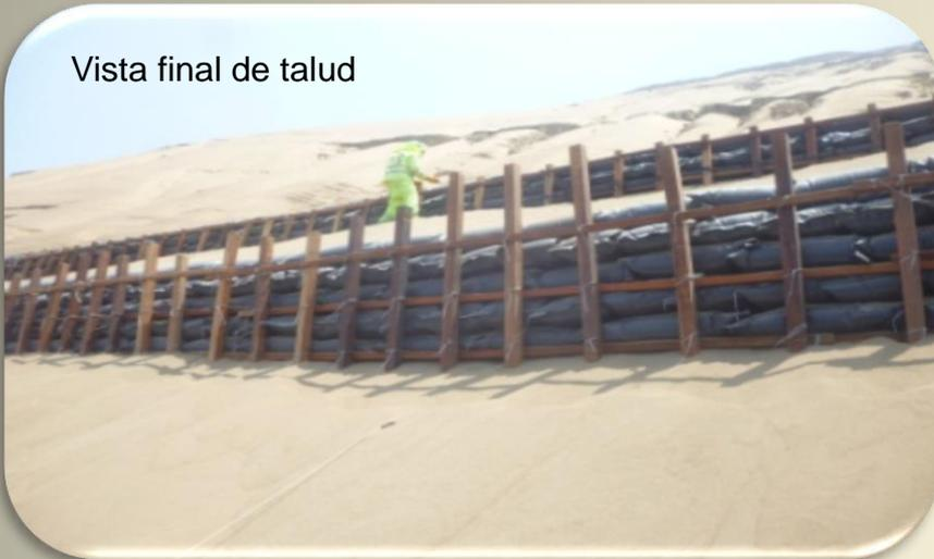
En el tramo Serpentín de Pasamayo existen zonas en las cuales los taludes inferiores se encuentran erosionados por la acción del viento, por ello, con el fin de evitar el deslizamiento del talud inferior se ha procedido a estabilizarlos.
