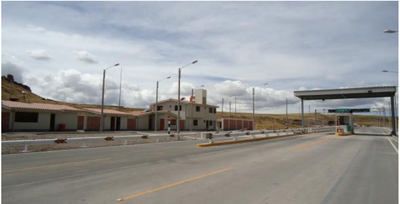
ESTACION DE PEAJE MACUSANI KM 187 +340
