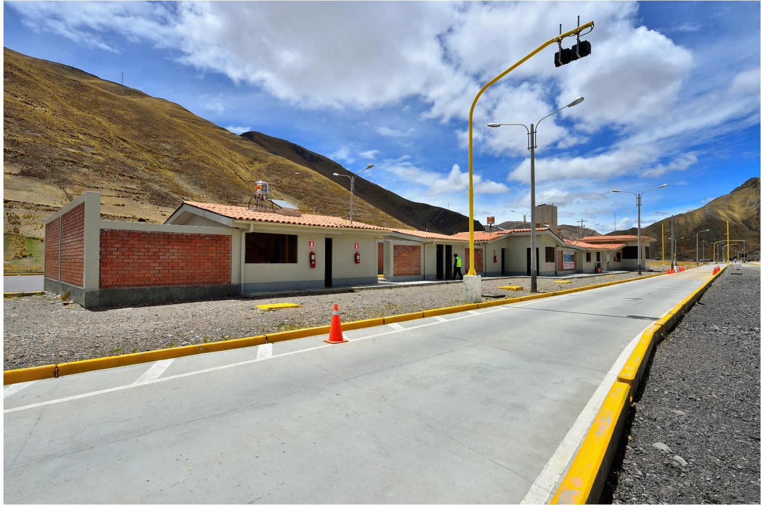
ESTACION DE PESAJE CCATUYO KM 125+500
