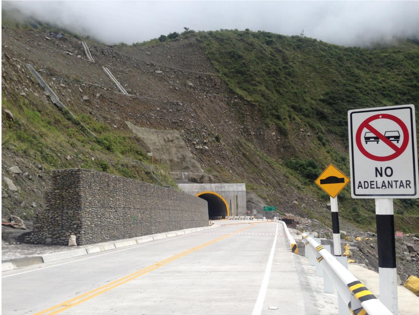
Portal de Entrada Túnel Wayrasencca- Km. 237
