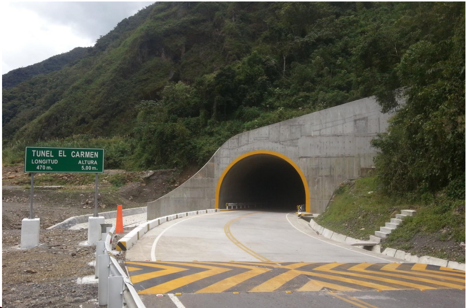
Portal de Entrada Túnel El Carmen - Km. 262
