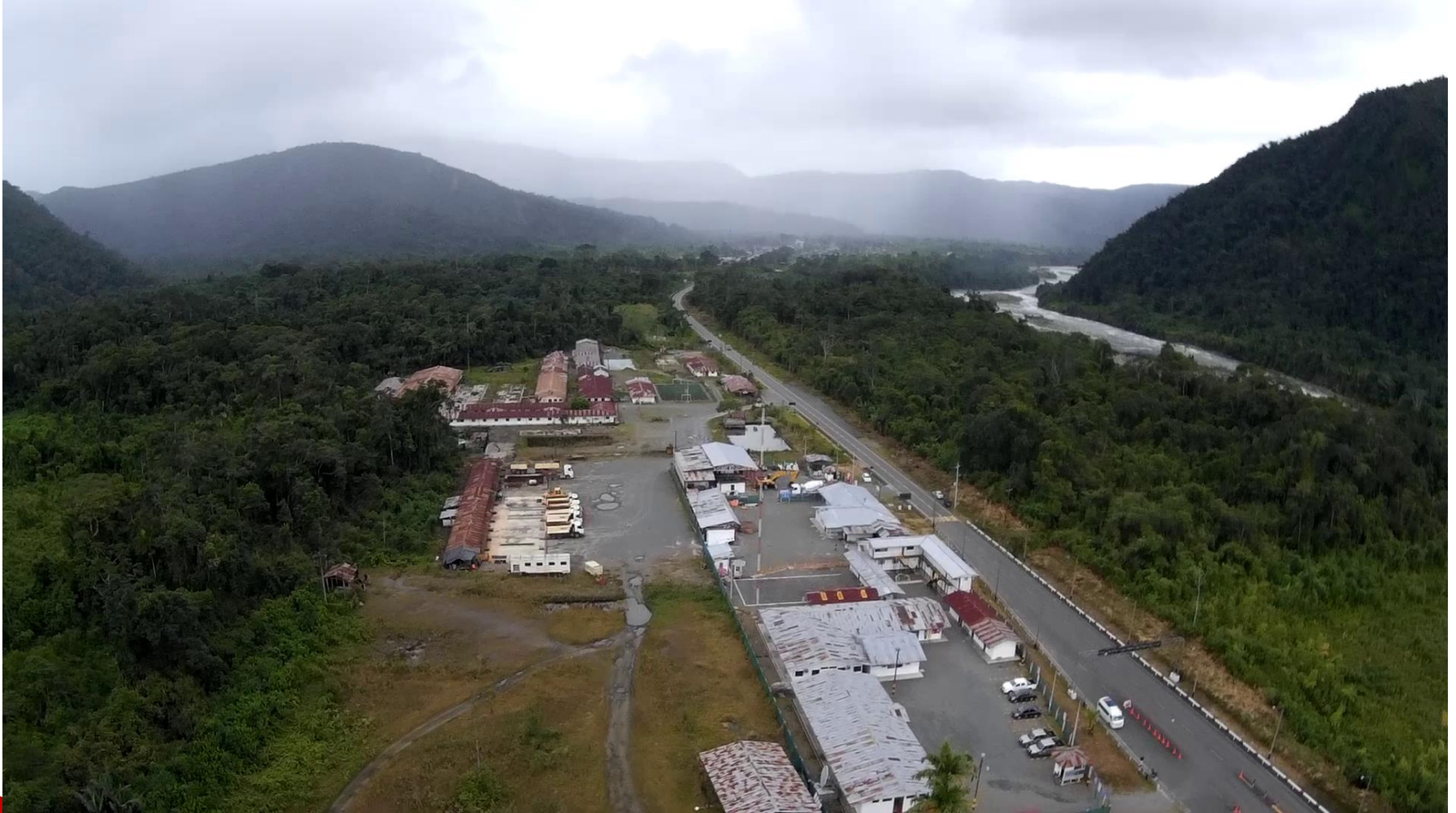
VISTA GENERAL DE CAMPAMENTO EN SAN GABÁN
