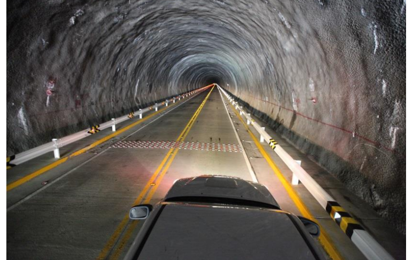
Túnel El Carmen
