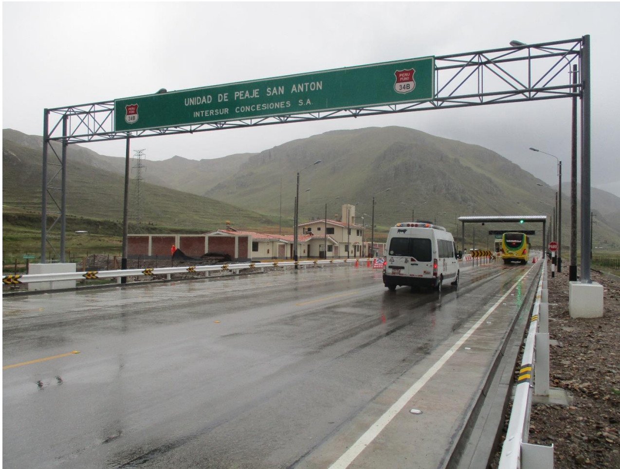
ESTACION DE PEAJE SAN ANTON KM 107 + 300
