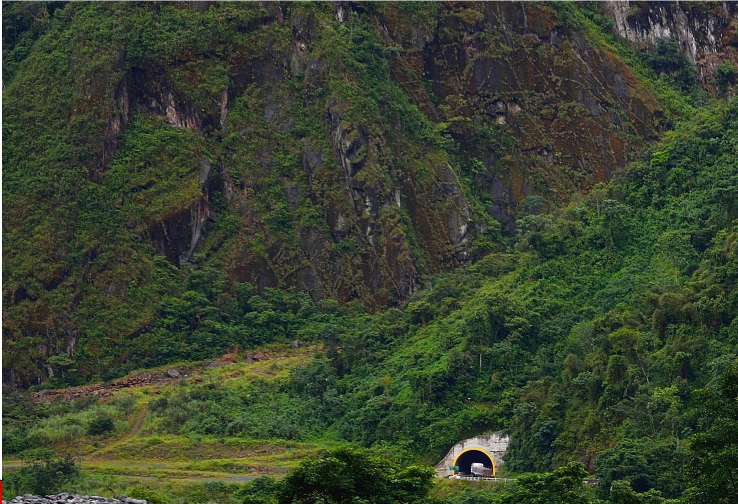
Túnel El Carmen
