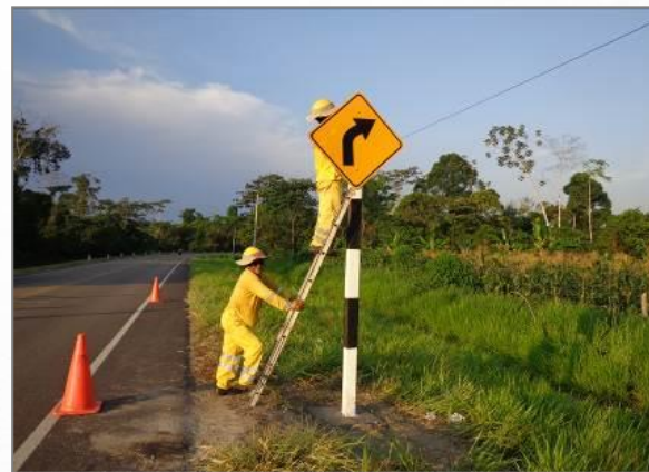
Limpieza de Placas de Señalización
