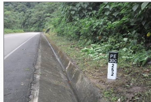
Limpieza de Cuneta
