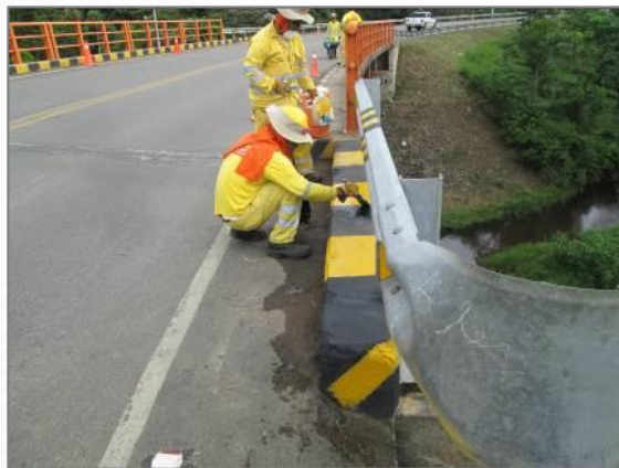
Repintado de Parapetos
