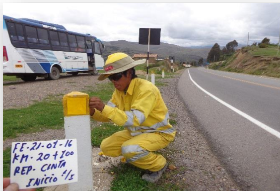
Deterioro delineador (cinta reflectiva)
