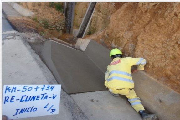
Reparación de cuneta de vía
