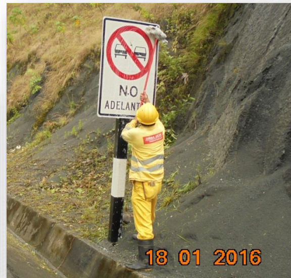
Limpieza de placas de señalización
