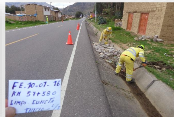
Limpieza de cuneta de vía
