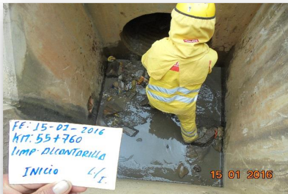
Limpieza de alcantarillas
