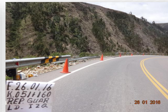
Reposición de guardavías
