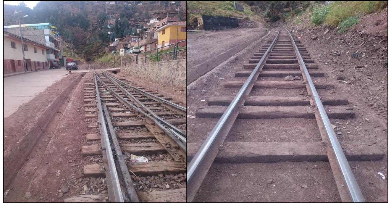
Estado Actual de la vía después de realizar los trabajos de descajonado y limpieza de cunetas - Cola de zigzag km 05+000
