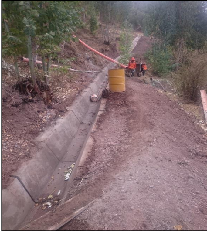
Elaboración y traslado de concreto f'c=175 \text{ kg/cm}^2
