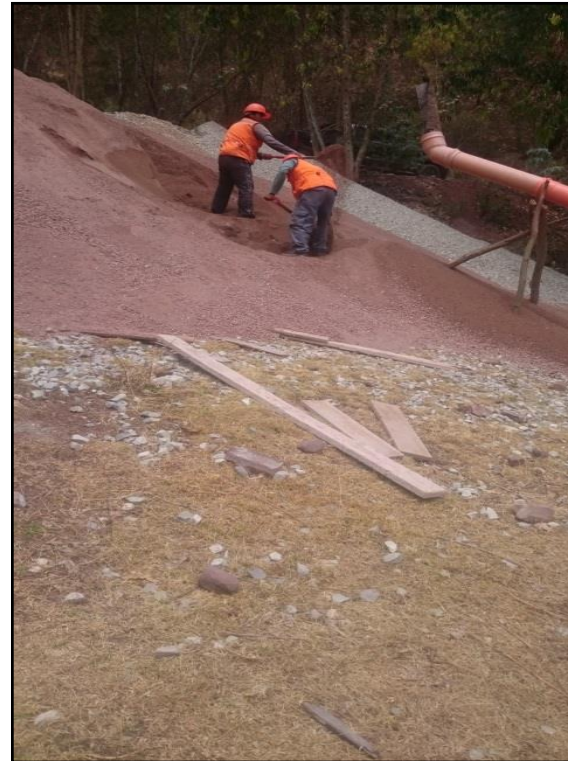
Acopio y traslado de materiales.
