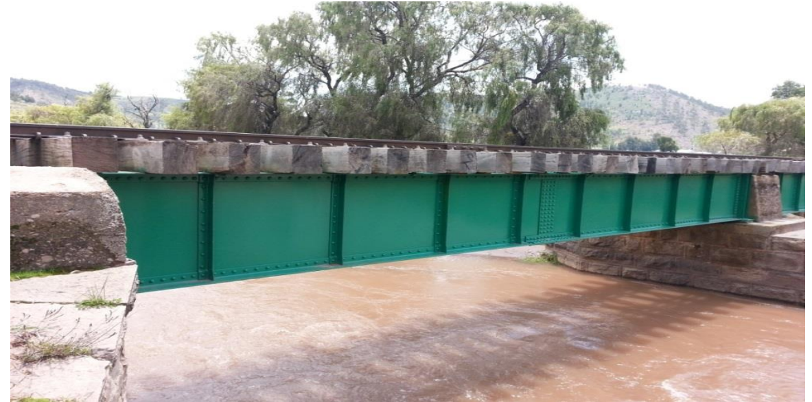
Puente Pichoc con la tercera capa de pintura.
