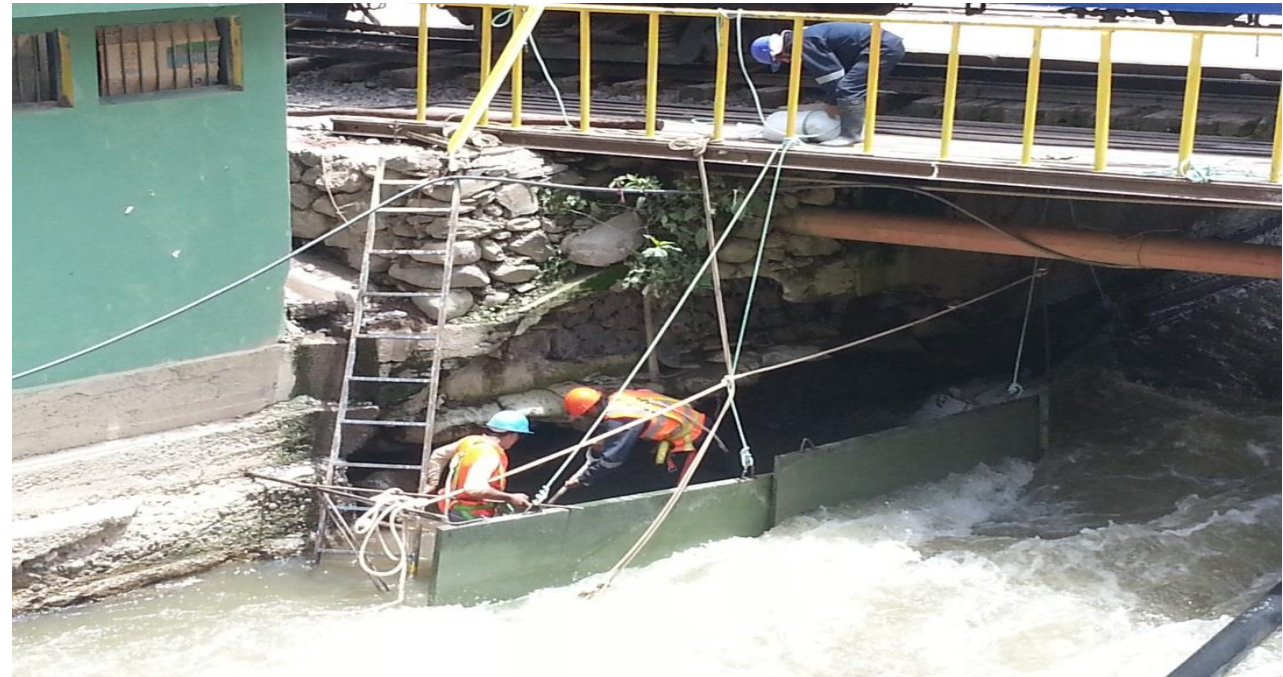
Trabajos de encausamiento del río.
