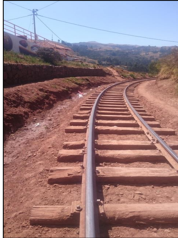
Trabajos de Descajonado, Limpieza de cunetas y corte de talud km 10+434 al km 10+498
