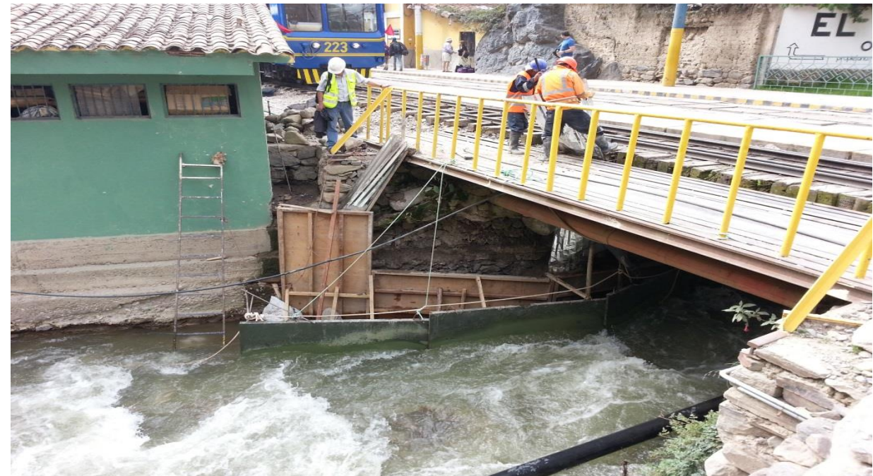
Estribo calzado, inicio de ejecución de pantalla de concreto frontal.
