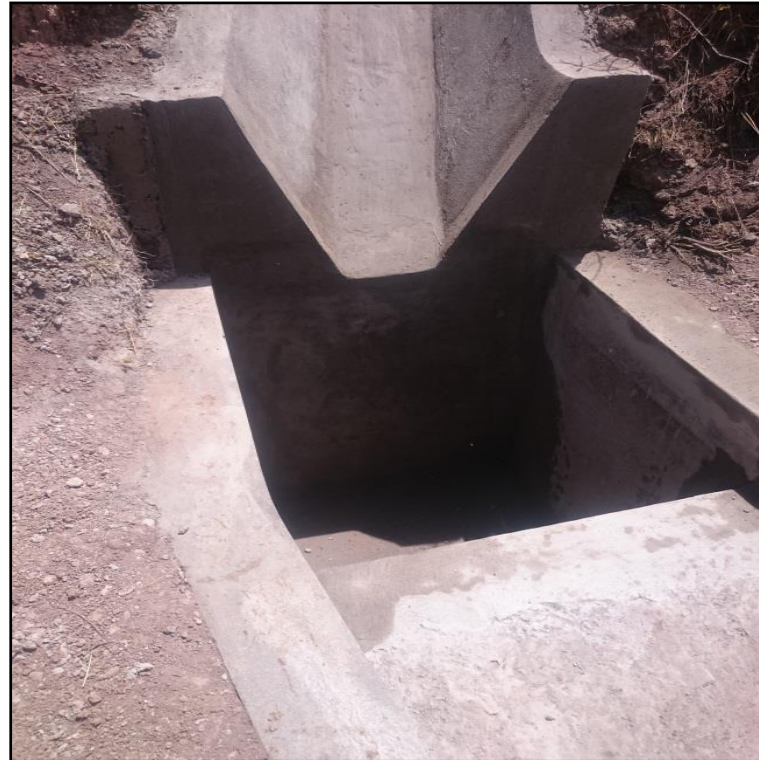
Construcción de Poza de disipación y rápida hacia la salida de la cuneta triangular existente
