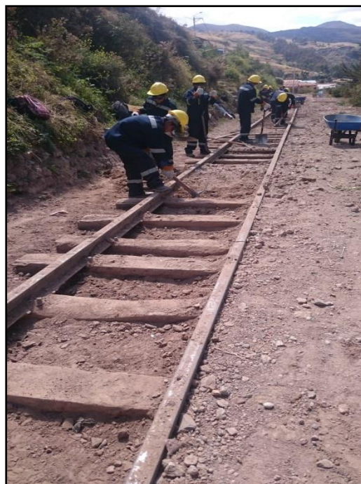
Trabajos de descajonado de la vía férrea y limpieza de cunetas.
