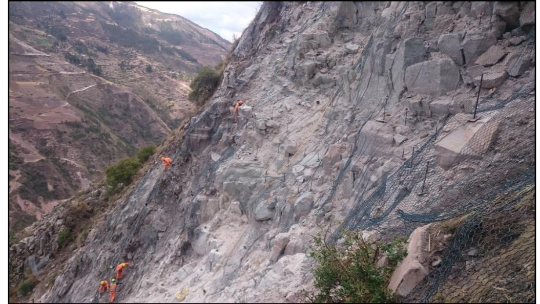
Suministro e instalación de Malla de Acero de Triple Torsión con recubrimiento de PVC.
