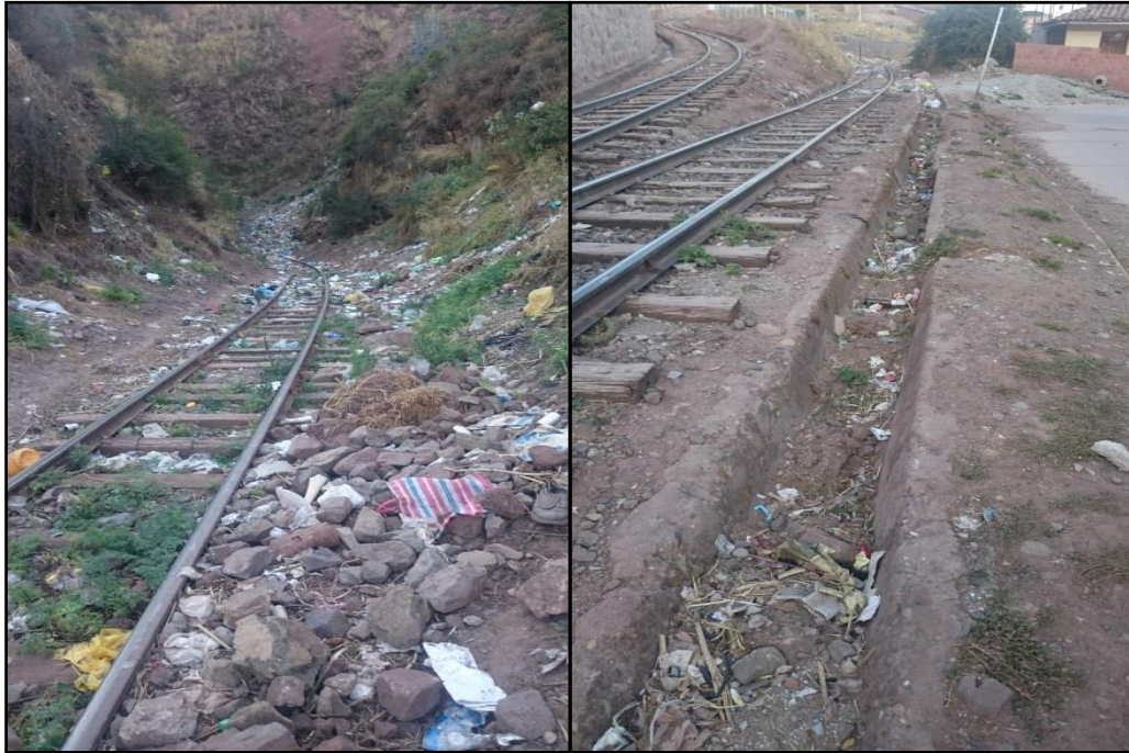
Estado antes de Iniciar los trabajos - Cola de zigzag km 05+000
