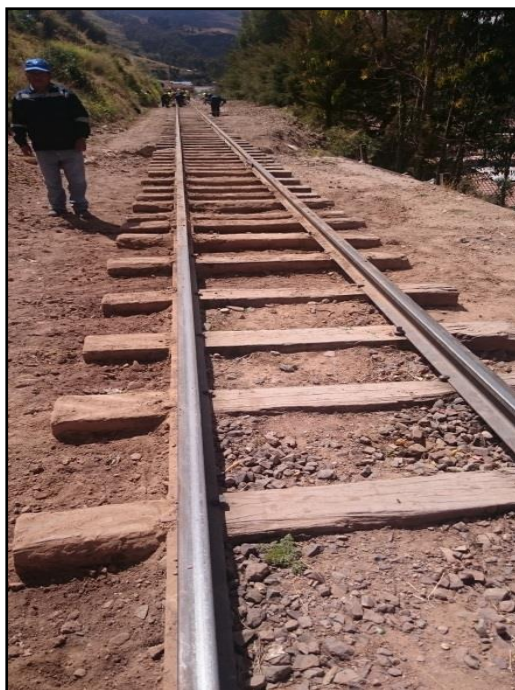
Estado inicial de la vía férrea.
