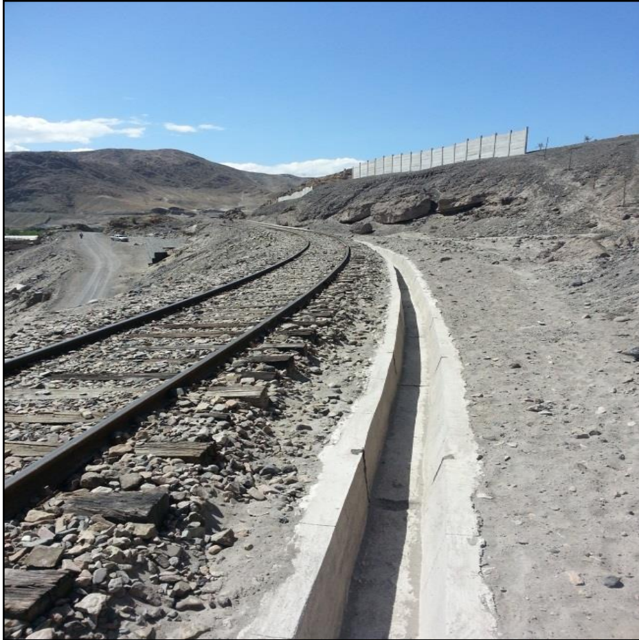
Cuneta de Concreto f'c \equiv 175 \text{ kg/cm}^2
