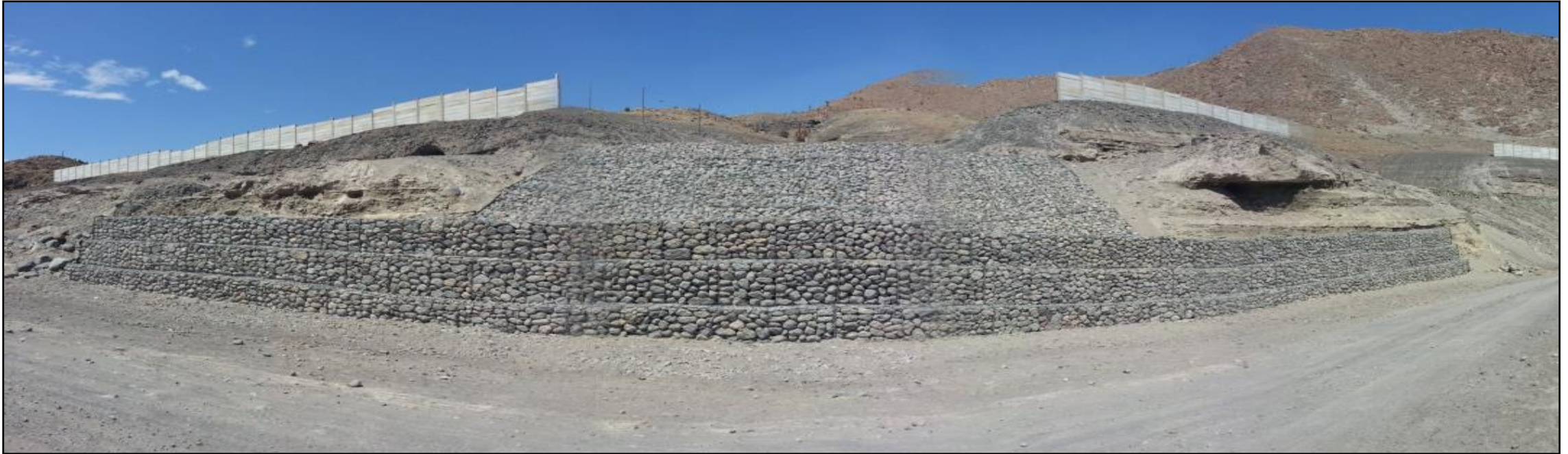
Muro de gaviones y recubrimiento con colchón de gavión.
