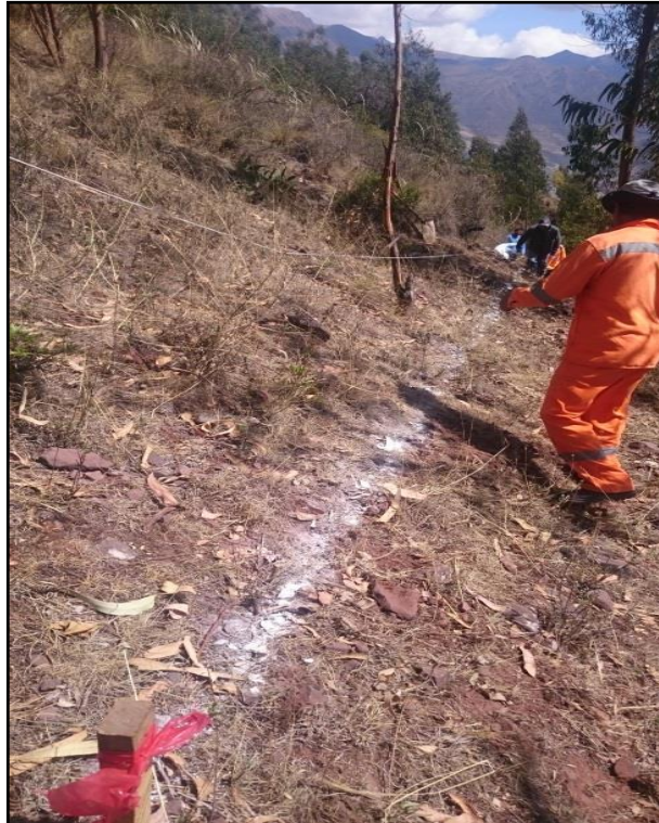
Trabajos de trazo y Replanteo.
