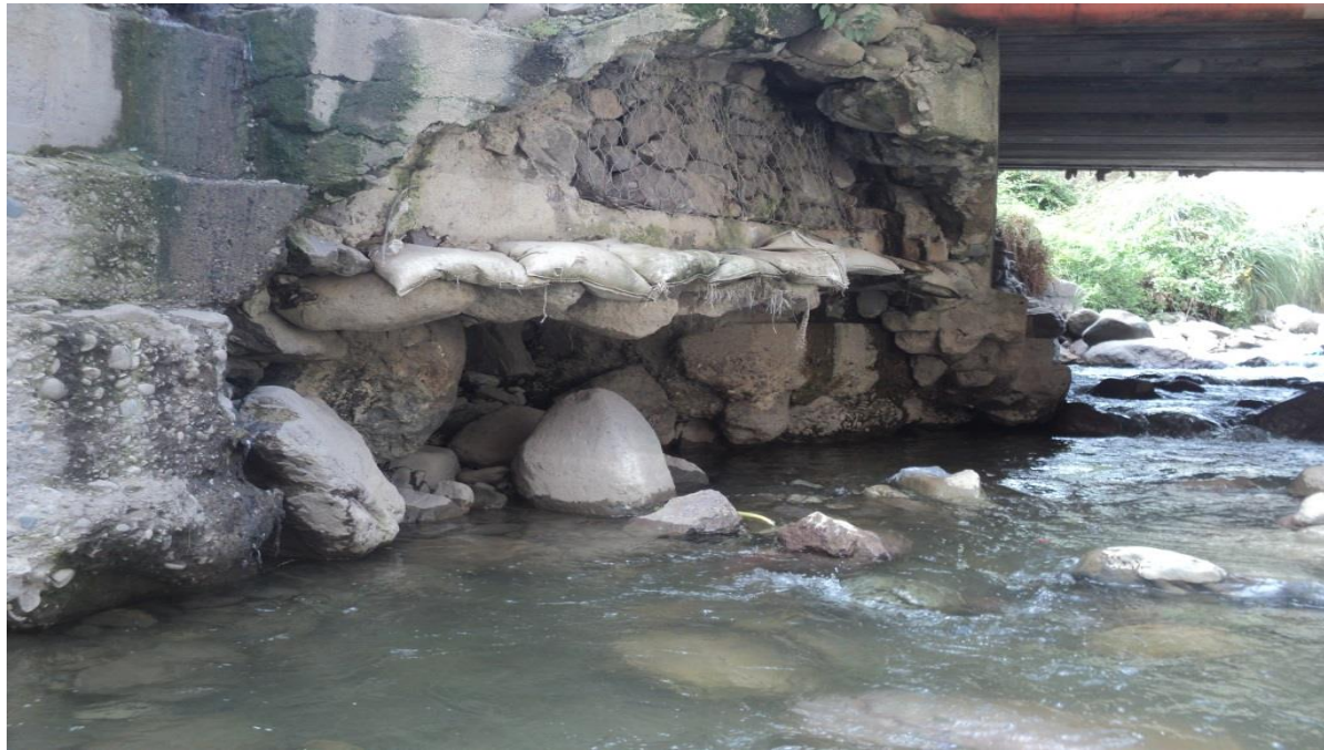
Situación Inicial del Estribo Norte
