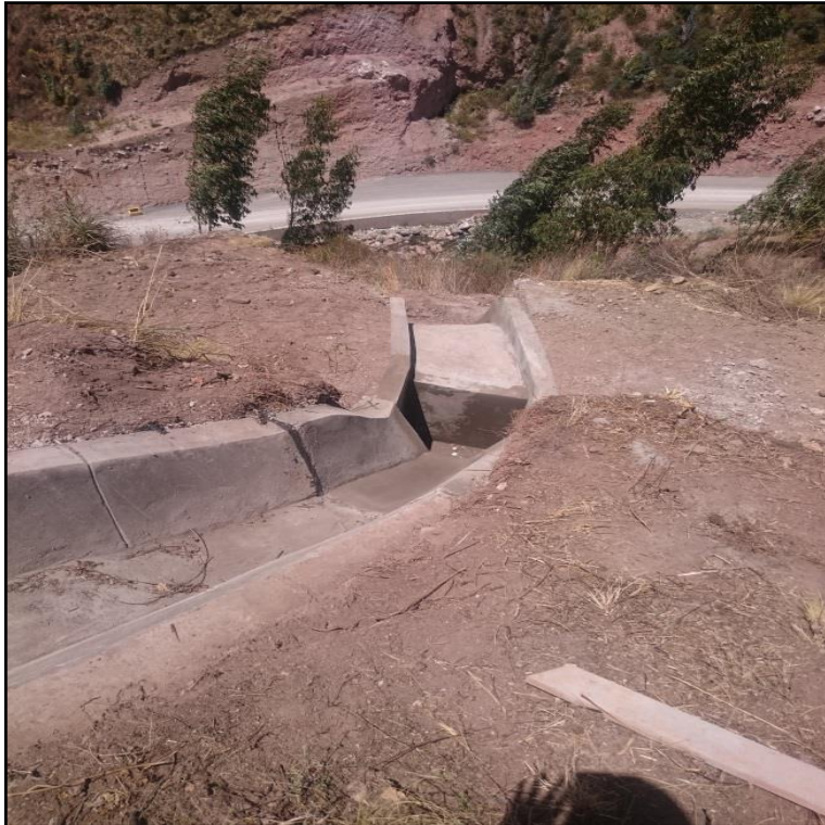
Construcción de Poza de disipación y rápida hacia la salida de la cuneta triangular existente
