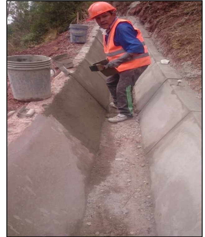
Tarrajeo de Exteriores
