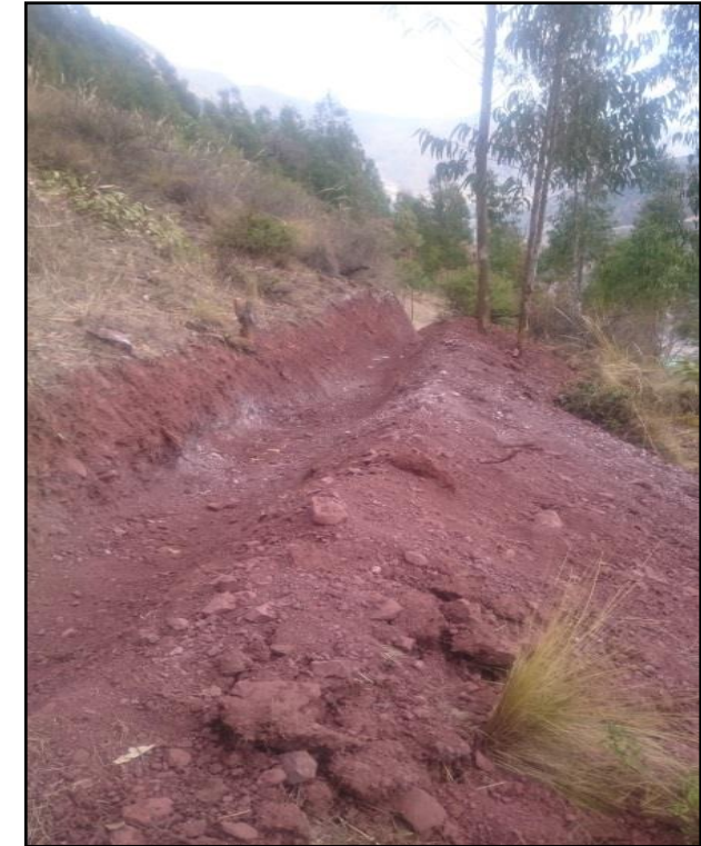
Excavación de Terreno Mixto.
