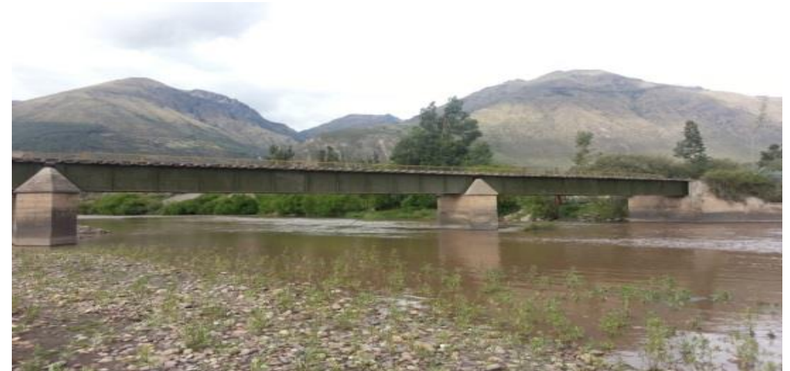
Puente Muyoc con la segunda capa de pintura.
