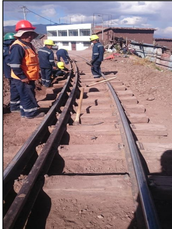
Trabajos de descajonado y limpieza del km 06+340 al km 06+990
