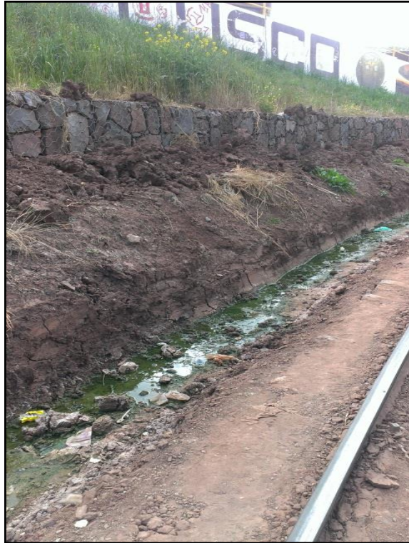
Estado Inicial antes de realizar los trabajos km 10+400
