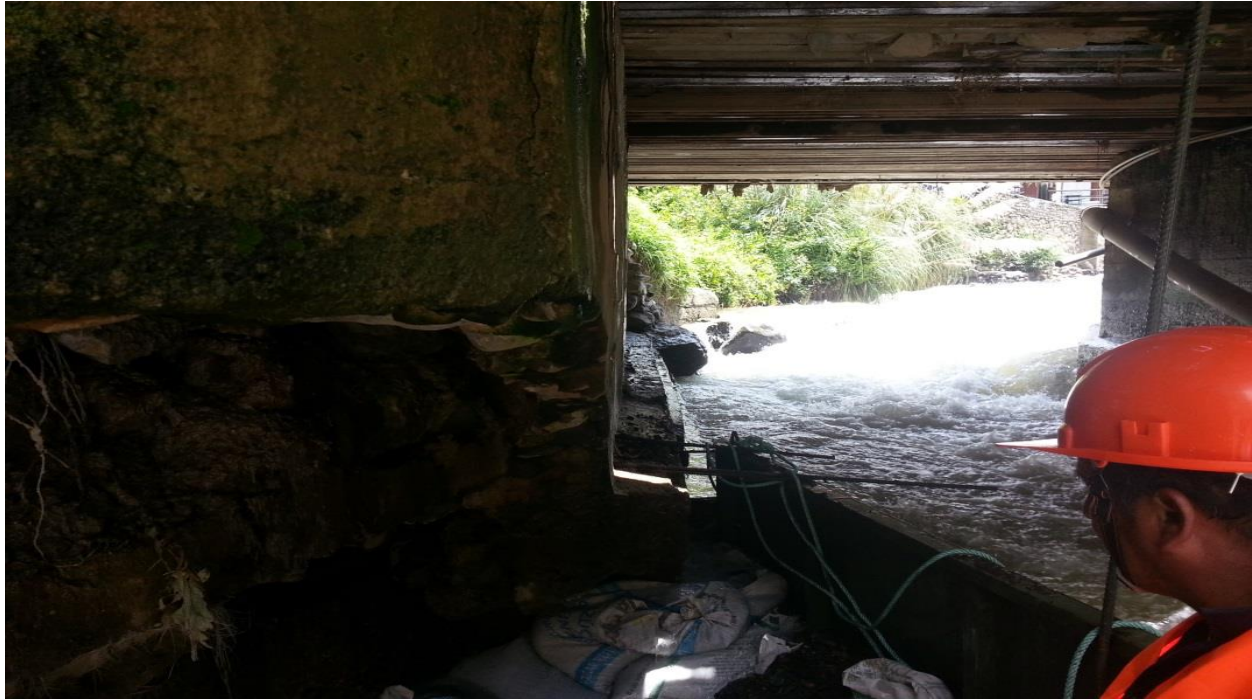
Rio encausado, inicios de trabajos de calzadura del estribo.
