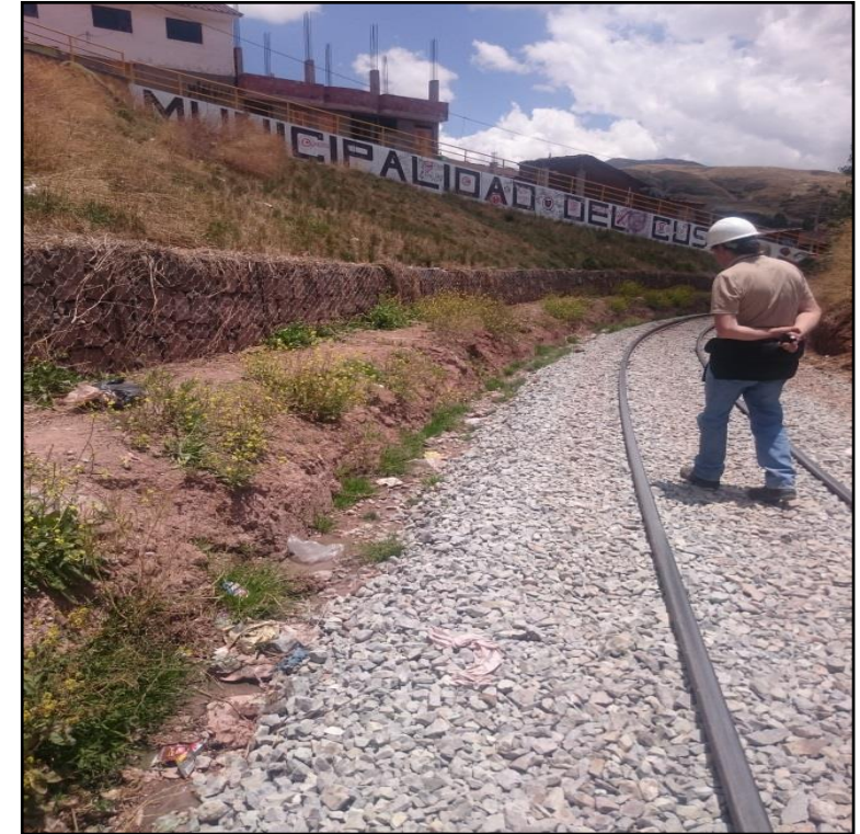
Estado Actual de la vía km 10+434 al km 10+498
