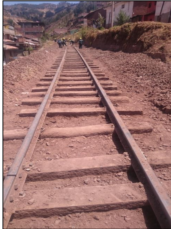
Trabajos de Descajonado y Limpieza de Cunetas del km 02+200 al km 03+000
