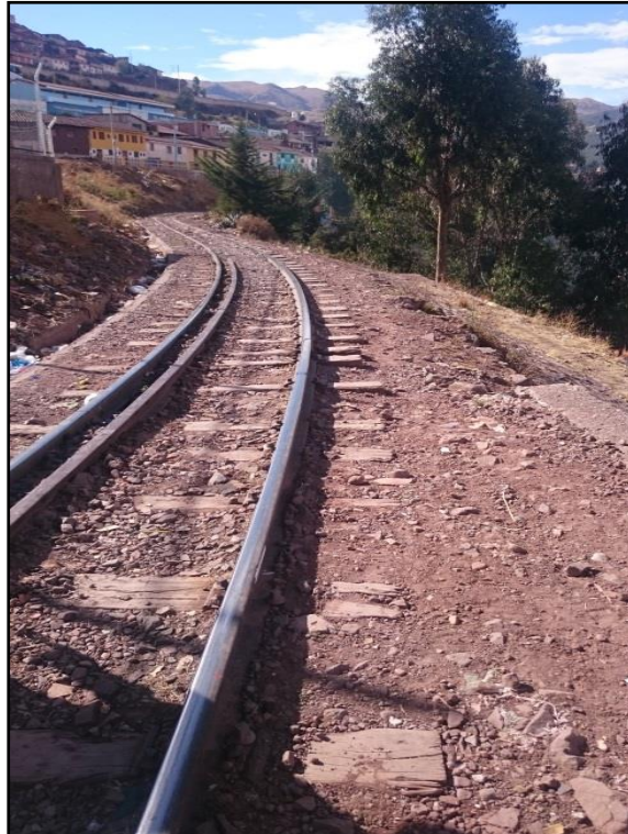
Estado Inicial antes de realizar los trabajos del km 06+340 al km 06+990
