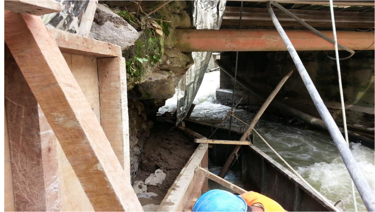
Trabajos de calzadura con concreto ciclópeo.
