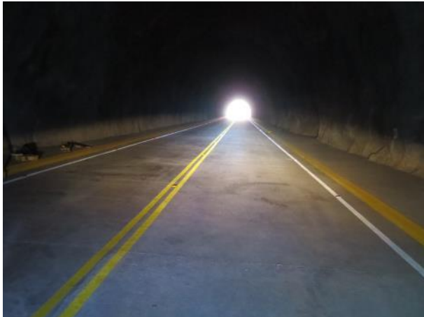
Tunel Chacahuaro II - Km 80 + 000
