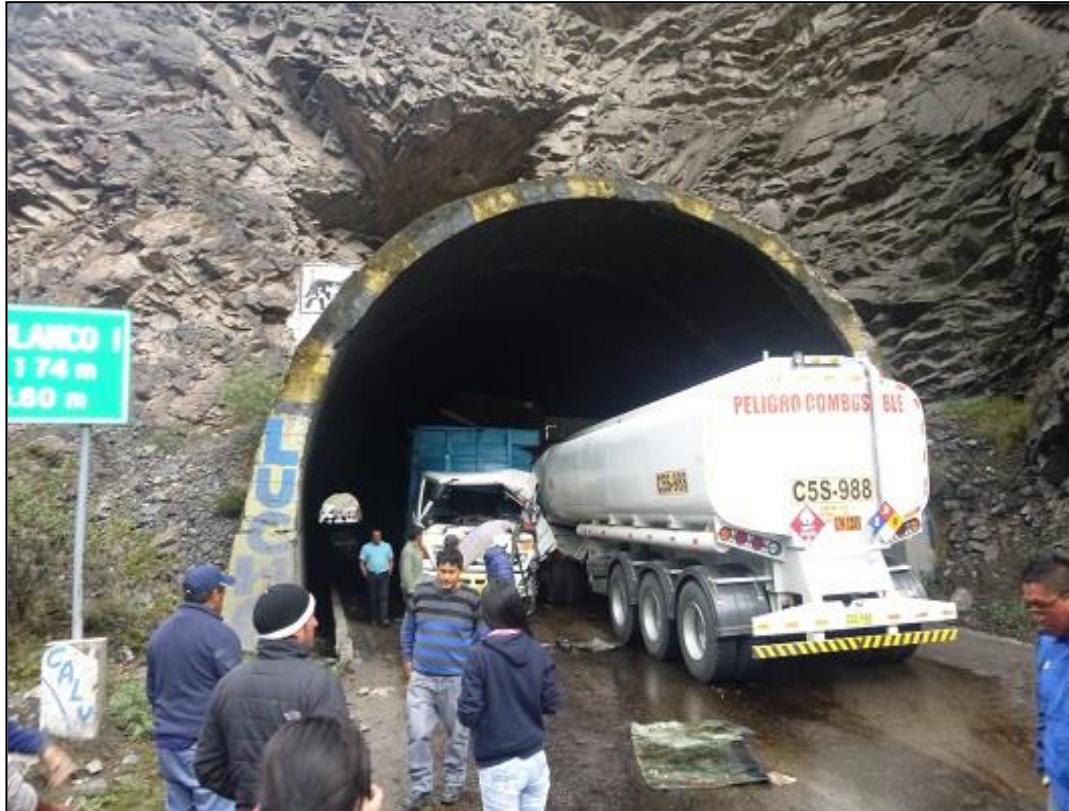
S1 km 102+000 Choque Frontal – Túnel
