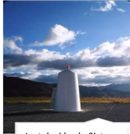
Instalación de Sistema De Radio ayudas
