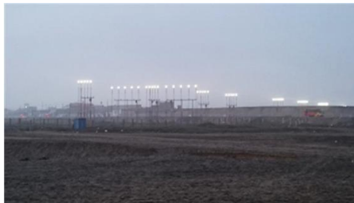
Luces de Aproximación Arpto Trujillo
