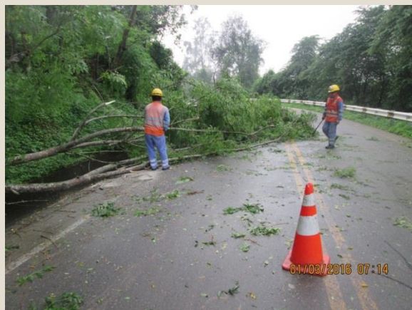
Limpieza de Obstáculos - Antes Sector 3: Loma Larga - Canchaque Progresiva: Km 74+960
