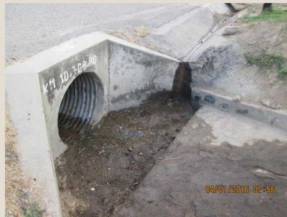
Limpieza de alcantarilla - Después Sector 1: Emp. 1b - Buenos Aires Progresiva: 10+708
