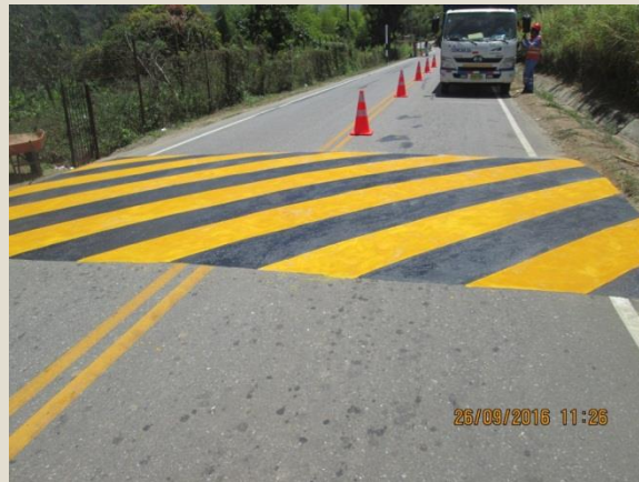
Pintado de resaltos - Después Sector 3: Loma Larga - Canchaque Progresiva: Km 74+250
