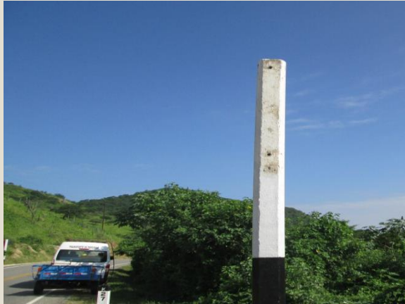
Reposición de señal Preventiva - Antes Sector 2A: Buenos Aires - Malacasi Progresiva: Km 27+009
