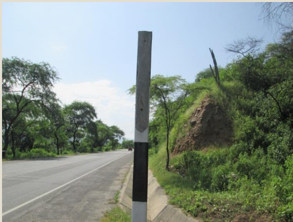
Reposición señal preventiva y reglamentaria - Antes Sector 1: Emp. 1b - Buenos Aires Progresiva: Km 12+032
