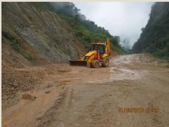
Limpieza de Carpeta sector Chiriguas - Antes Sector 2B: Loma Larga - Canchaque Progresiva: Km 72+200
