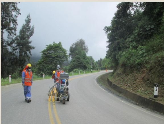
Demarcación de pavimento - Antes Sector 3: Loma Larga - Canchaque Progresiva: Km 74+000
