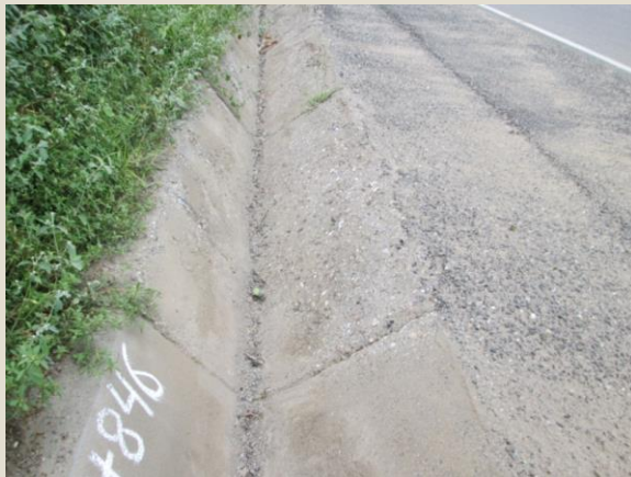
Reparación de concreto en cunetas - Antes Sector 1: Emp 1b - Buenos Aires Progresiva: Km 18+846
