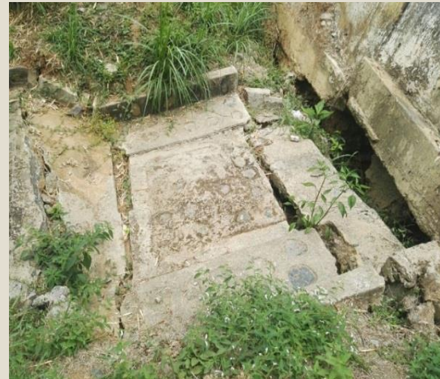
7. Desplazamiento de talud inferior Km 75+650
