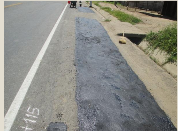
Bacheo en berma - Después Sector 1: Emp. 1b - Buenos Aires Progresiva: Km 7+115
