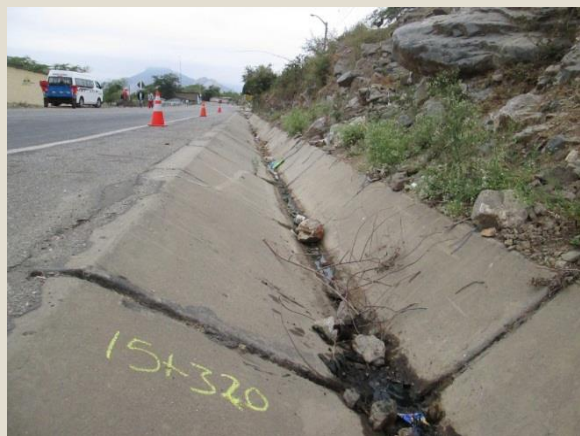
Limpieza de cunetas manual - Antes Sector 1: Emp. 1B - Buenos Aires Progresiva: Km 15+320 al Km 15+600
