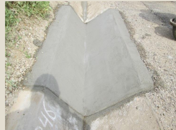
Reparación de concreto en cunetas - Después Sector 1: Emp 1b - Buenos Aires Progresiva: Km 18+846
