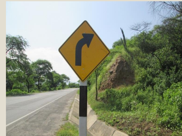
Reposición señal preventiva y reglamentaria - Después Sector 1: Emp. 1b - Buenos Aires Progresiva: Km 12+032
