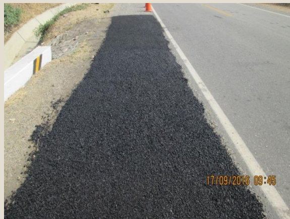
Bacheo en berma - Después Sector 2A: Buenos Aires - Malacasi Progresiva: 22+350
