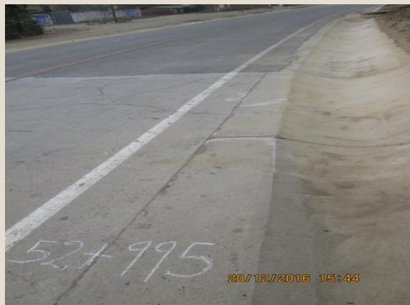
Limpieza de cuneta con equipo - Después Sector 2b: Malacasi - Loma Larga Progresiva: km 52+995
