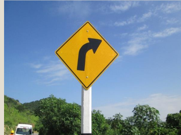
Reposición de señal informativa - Después Sector 2A: Buenos Aires - Malacasi Progresiva: Km 27+009
