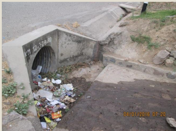
Limpieza de alcantarilla - Antes Sector 1: Emp. 1b - Buenos Aires Progresiva: 10+708
