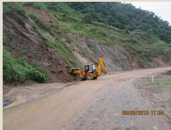
Limpieza de Carpeta sector Chiriguas - Después Sector 2B: Loma Larga - Canchaque Progresiva: Km 72+200
