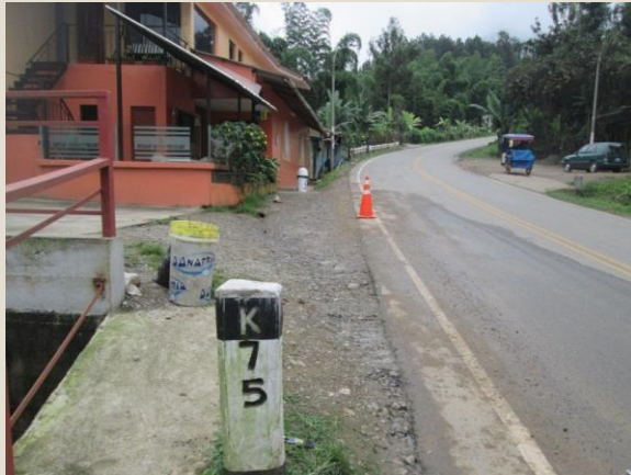
Pintado de Hito Kilométrico - Antes Sector 3: Loma Larga - Canchaque Progresiva: Km 75+000
