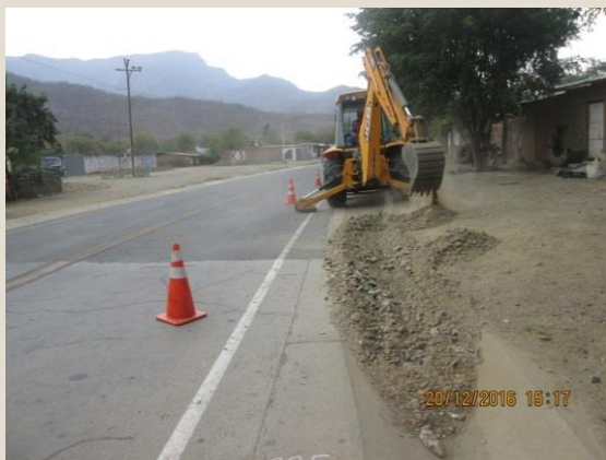
Limpieza de cuneta con equipo - Antes Sector 2b: Malacasi - Loma Larga Progresiva: km 52+995
