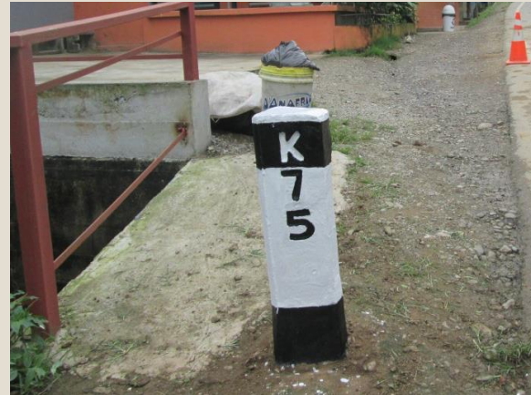
Pintado de Hito Kilométrico - Después Sector 3: Loma Larga - Canchaque Progresiva: Km 75+000
