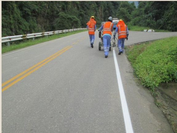
Demarcación de pavimento - Antes Sector 3: Loma Larga - Canchaque Progresiva: Km 71+900
