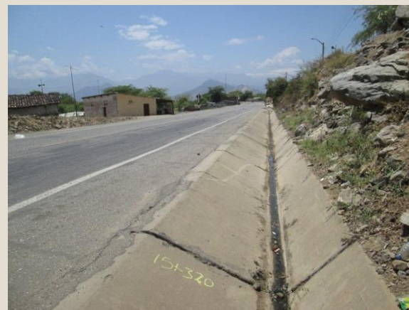
Limpieza de cunetas manual - Después Sector 1: Emp. 1B - Buenos Aires Progresiva: Km 15+320 al Km 15+600
