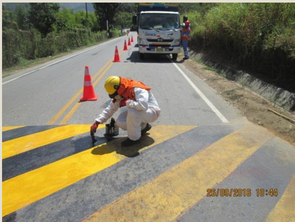
Pintado de resaltos - Antes Sector 3: Loma Larga - Canchaque Progresiva: Km 74+250
