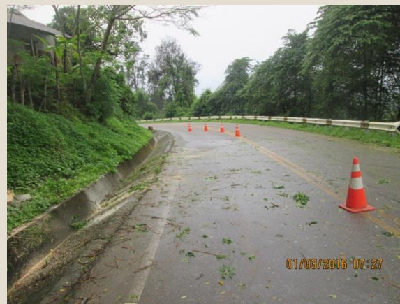
Limpieza de Obstáculos - Después Sector 3: Loma Larga - Canchaque Progresiva: Km 74+960
