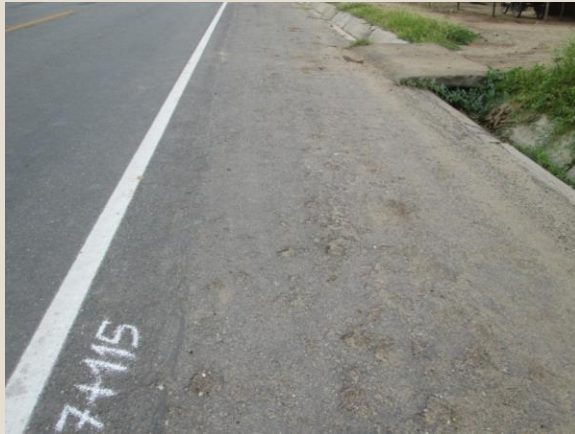
Bacheo en berma - Antes Sector 1: Emp. 1b - Buenos Aires Progresiva: Km 7+115
