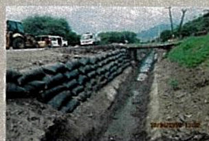
Conformación de talud - Después Sector 2: Buenos Aires - Piedra Azul
