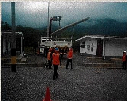
Electrificación de la Estación de Peaje de Loma Larga.
