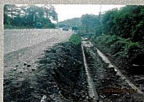
Conformación de talud - Antes Sector 2: Buenos Aires - Piedra Azul
