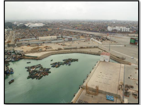
Después de la remediación
