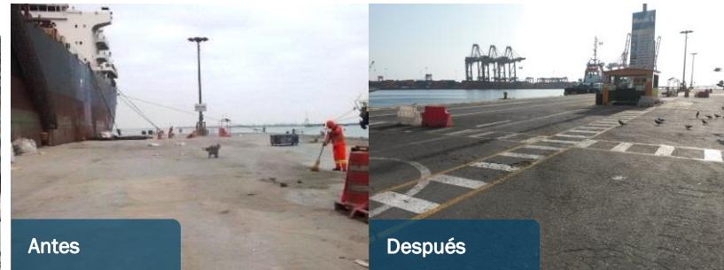
Pintado de señalización de tránsito en vías y muelles
