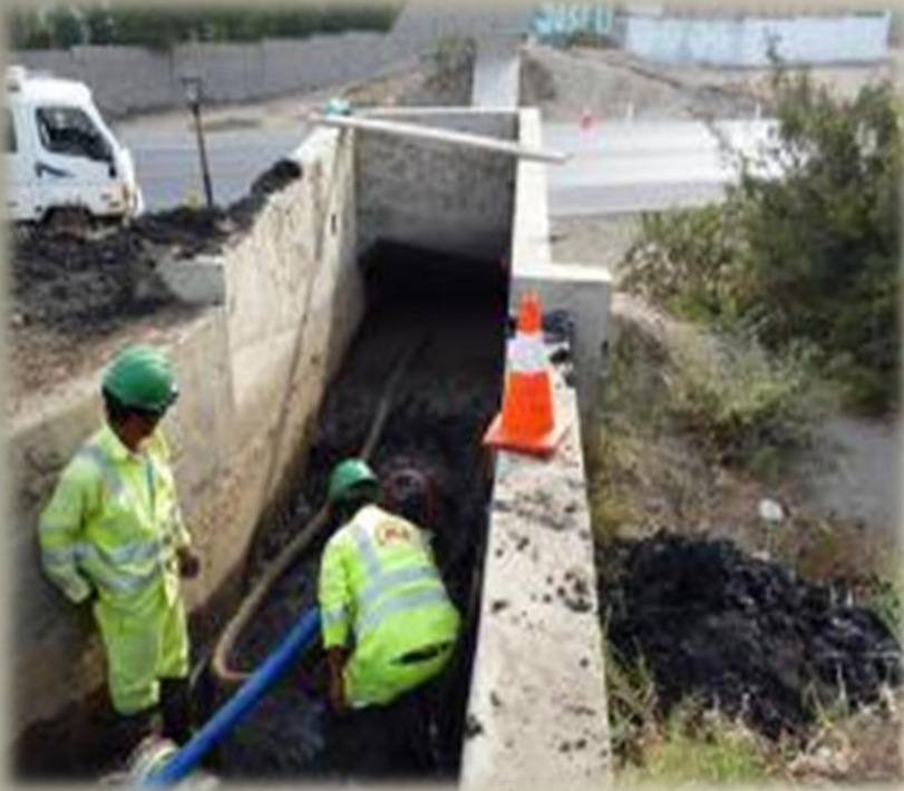
Trabajos de Limpieza de sifones. Tramo: Huacho - Pativilca
