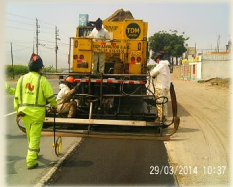
Colocación de Slurry en bermas.
