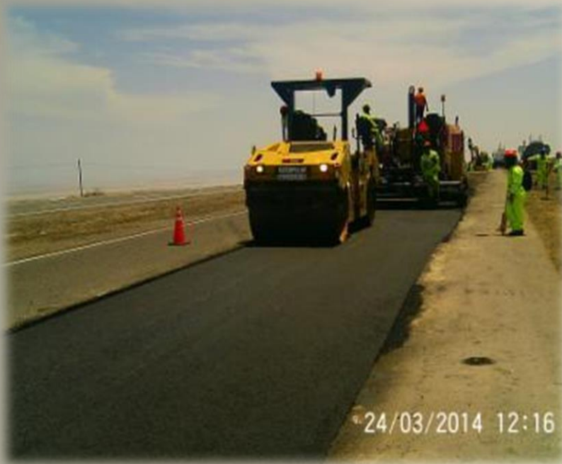
Colocación de MAC en carril derecho de la pista.
