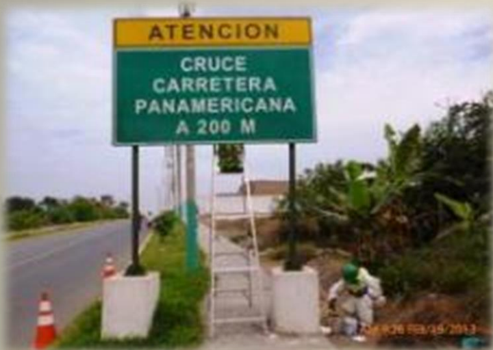
Trabajos de Renovación de Señalización Tramo: Medio Mundo - Pativilca
