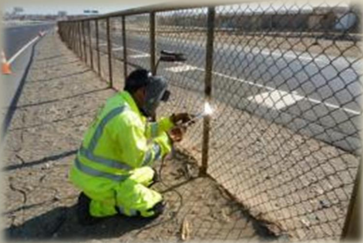
Reparación mallas metálicas. Tramo: Huacho - Pativilca
