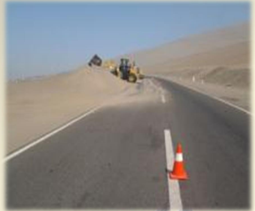
Trabajos de desarenado con máquina
