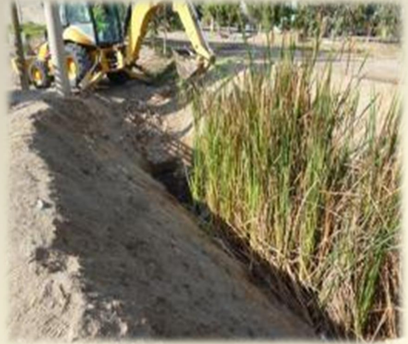
Trabajos de Limpieza de alcantarillas y canales. Tramo: Huacho - Pativilca
