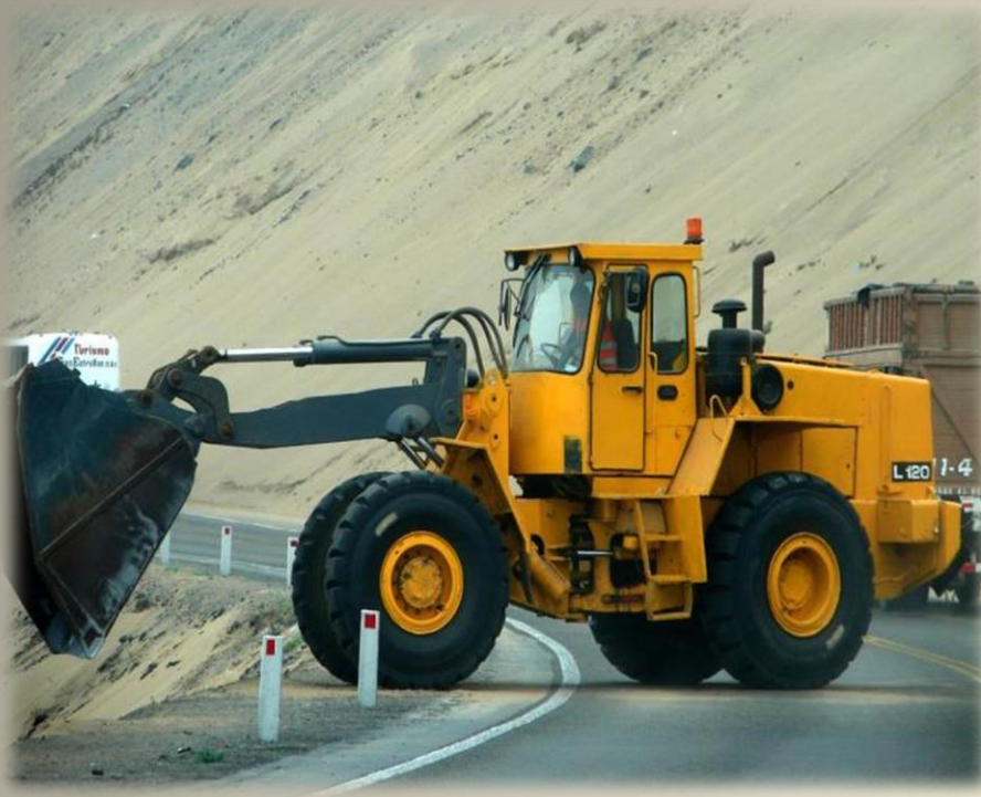
Trabajos de desarenado con máquina
