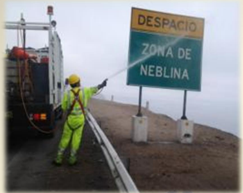
Trabajos de limpieza de señales. Tramo: Serpentín
