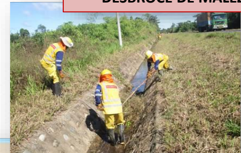
LIMPIEZA DE CUNETAS
