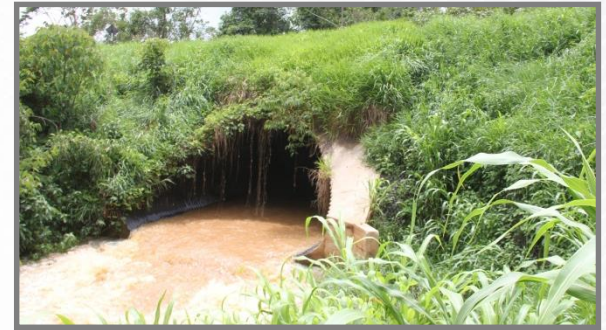
Obra Accesorio: Km 638+518 - 638+550 (H)
