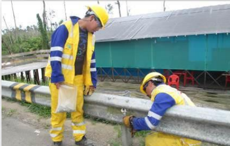
REPOSICIÓN DE GUARDAVÍA
