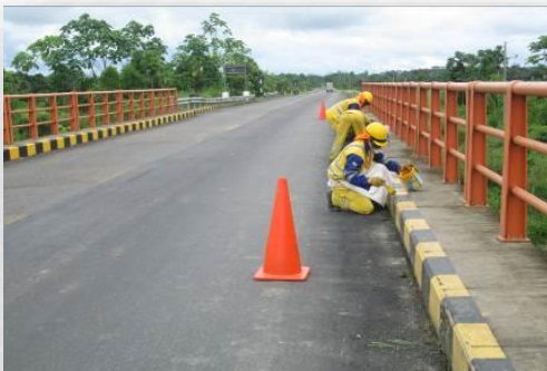
LIMPIEZA Y PINTURA DE VEREDAS PUENTE
