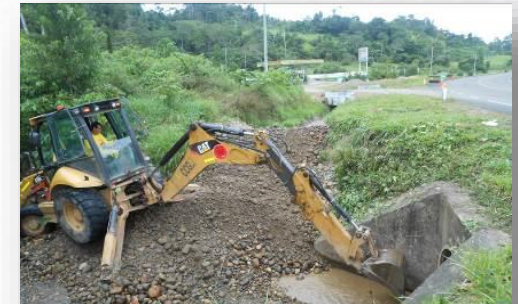
LIMPIEZA DE ALCANTARILLA
