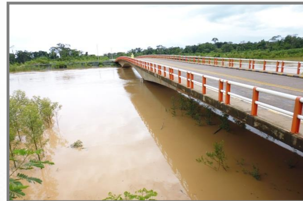
Defensa Ribereña del Puente Tahuamanu
