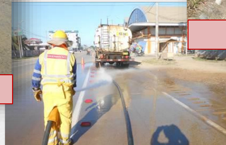
LIMPIEZA DE CALZADA Y BERMA
