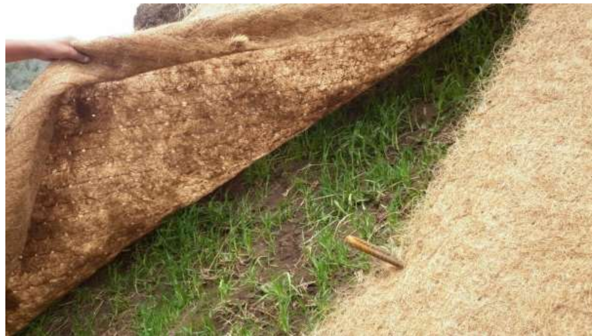
Proceso de vegetación mediante Geoceldas, utilización de geomanto de fibra de coco para favorecer el crecimiento del grass.
