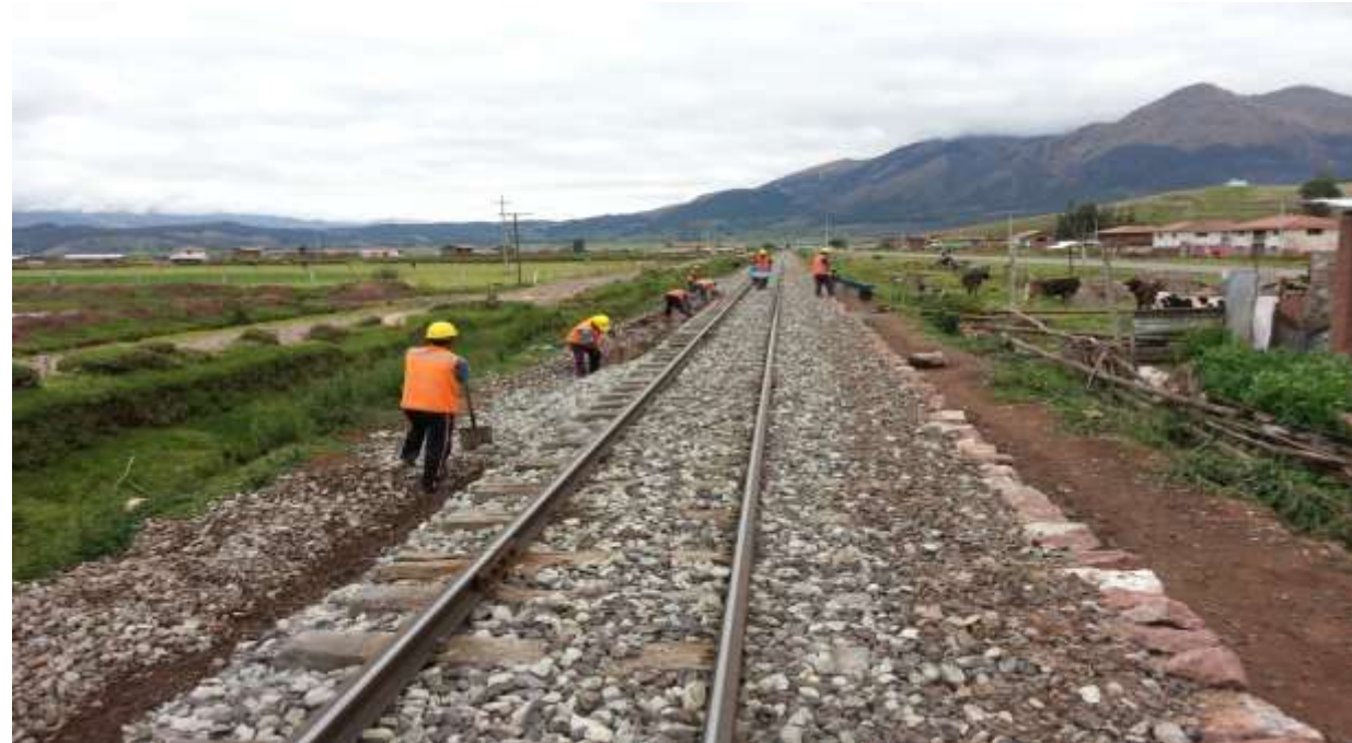
Construcción de los pretilos.
