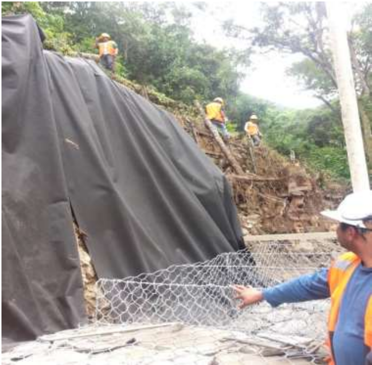
Tendido de geotextil en la parte posterior del muro de gaviones para evitar la pérdida de partículas finas por flujo interno.
