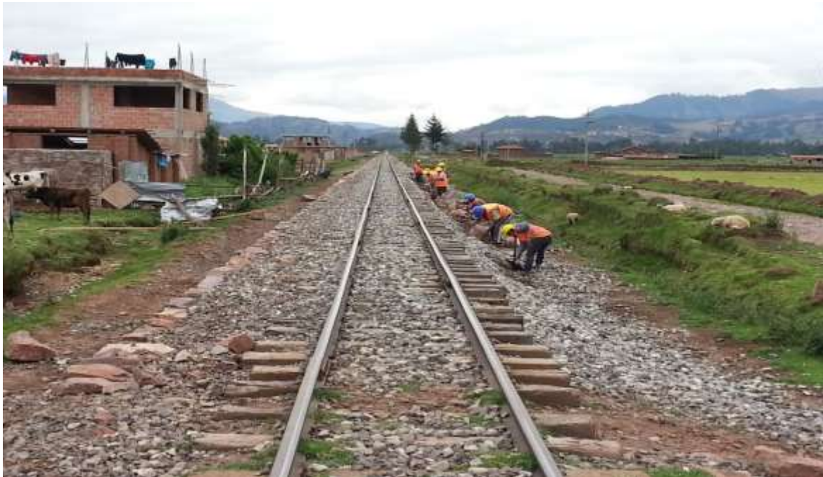
Construcción de los pretilos.
