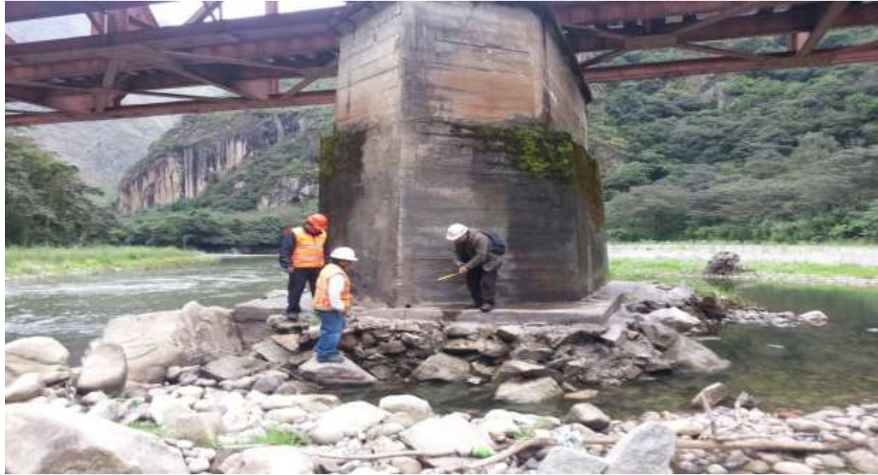
Situación Inicial del Pilar Central.
