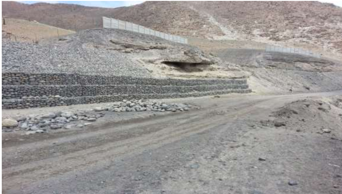
Proceso Constructivo del Muro de Gaviones: 220.50 m 3
