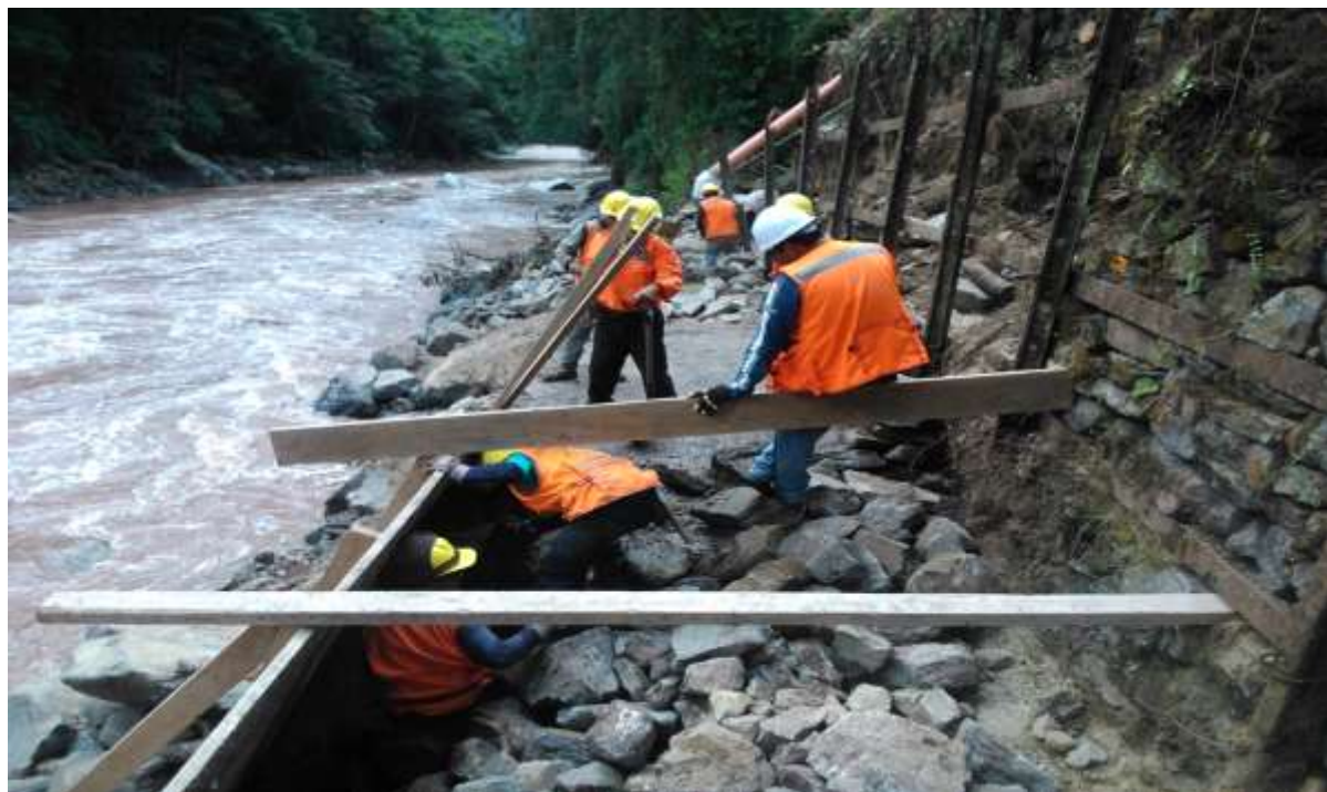
Construcción de cimentación de Concreto Ciclópeo f'c \approx 175 \text{ kg/cm}^2 .
