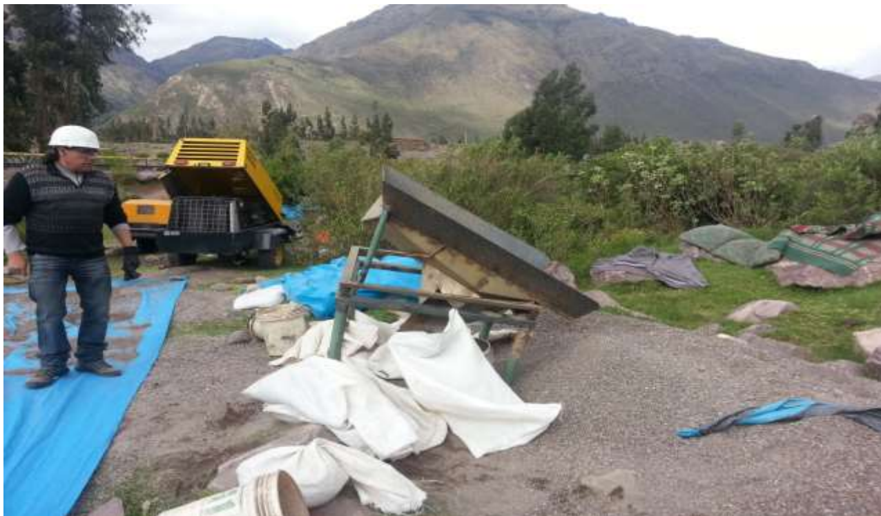
Proceso de selección y secado de material abrasivo (arena con granulometría especial).
