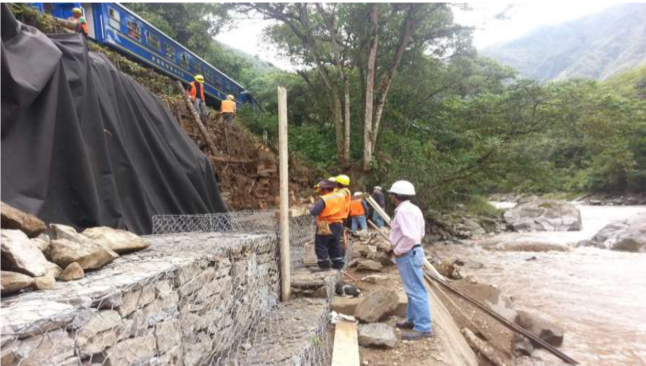
Construcción de muro de gaviones.
