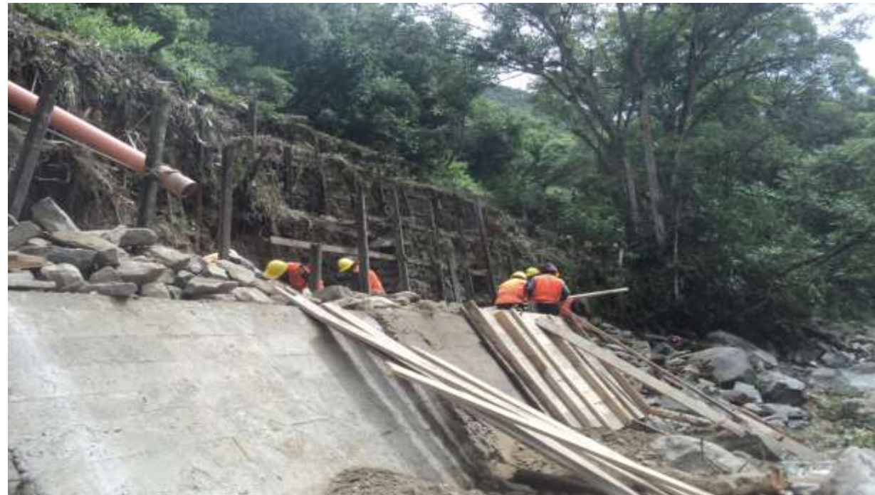
Construcción de cimentación de Concreto Ciclópeo f'c ≅ 175 kg/cm 2 .
