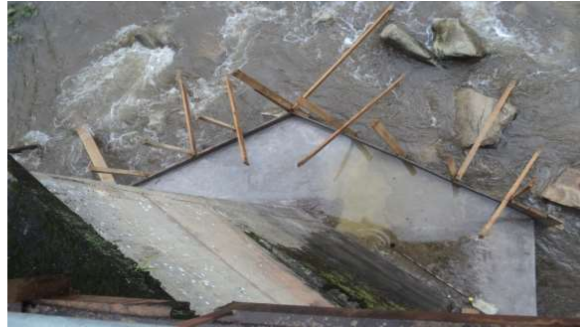
Construcción de la protección del pilar central – Puente San Miguel.
