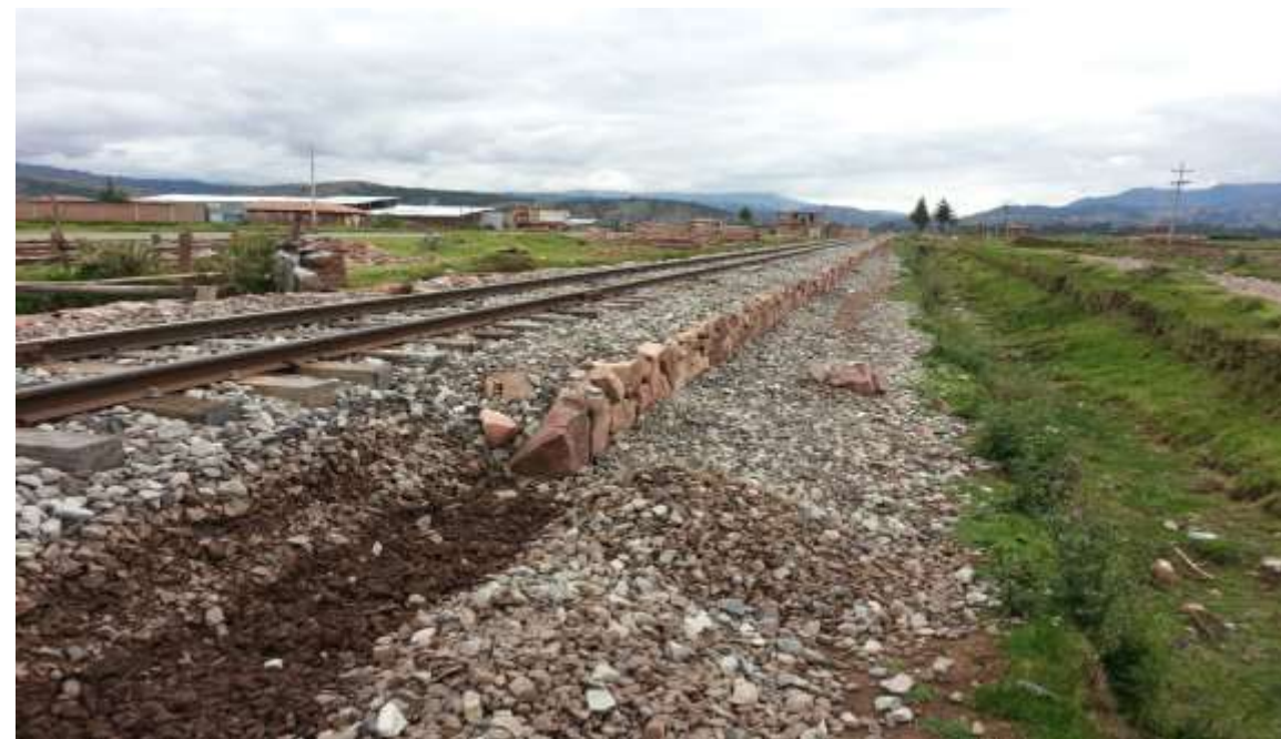
Construcción de los pretiles.
