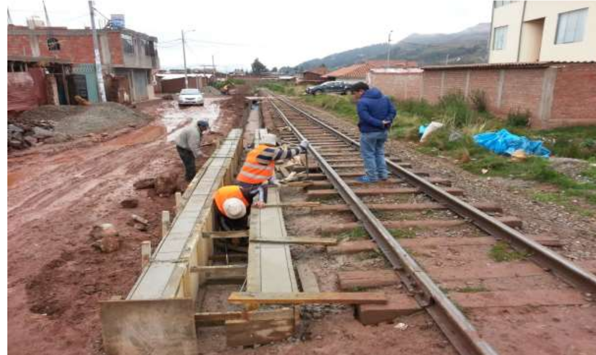
Desencofrado de tramo de canal vaciado.
