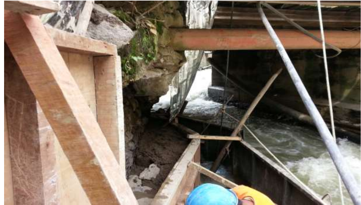
Trabajos de calzadura con concreto ciclópeo.
