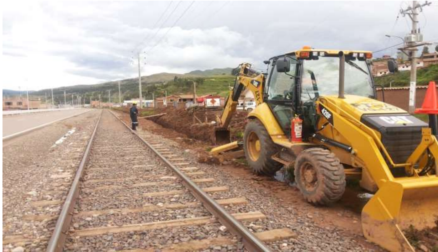
Retroexcavadora operativa, realizando trabajos en vía.
