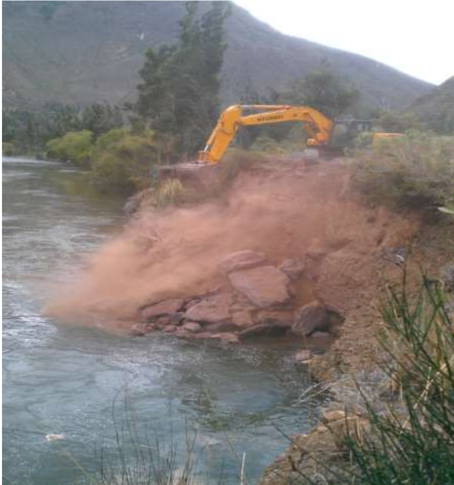
Construcción de rampa de acceso
