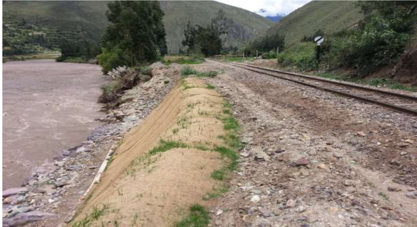
Recuperación del terraplén de la vía férrea, talud inferior estabilizado.
