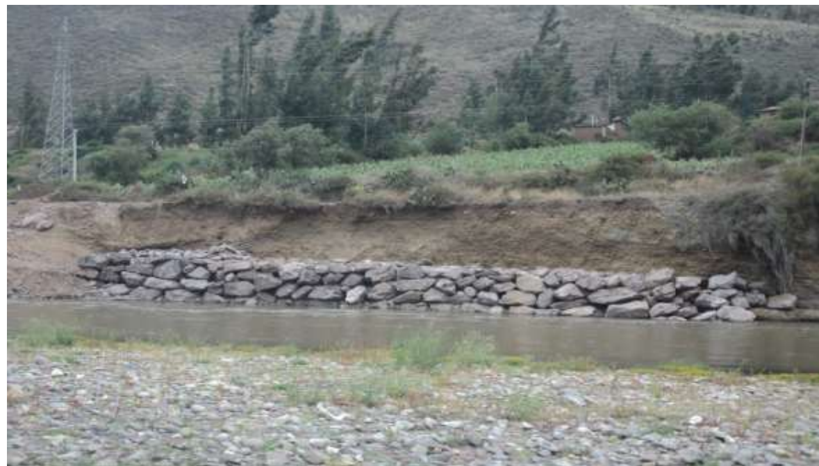
Muro de Enrocado concluido.
