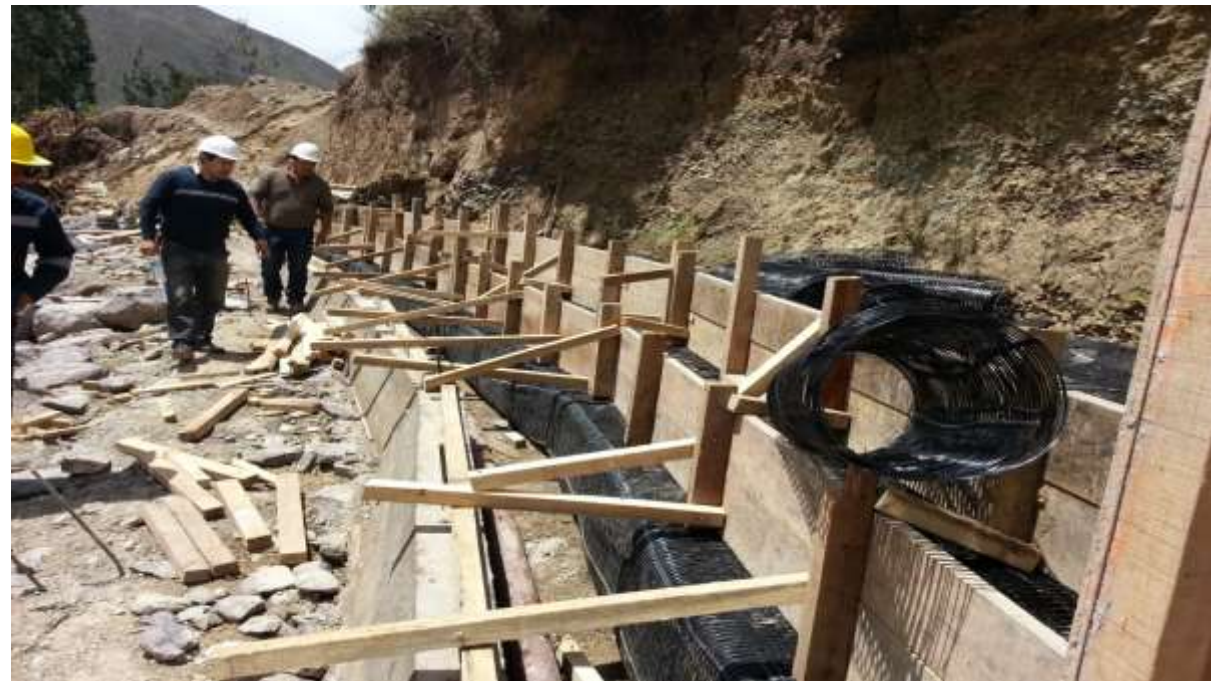
Encofrado para muro de suelo reforzado.
