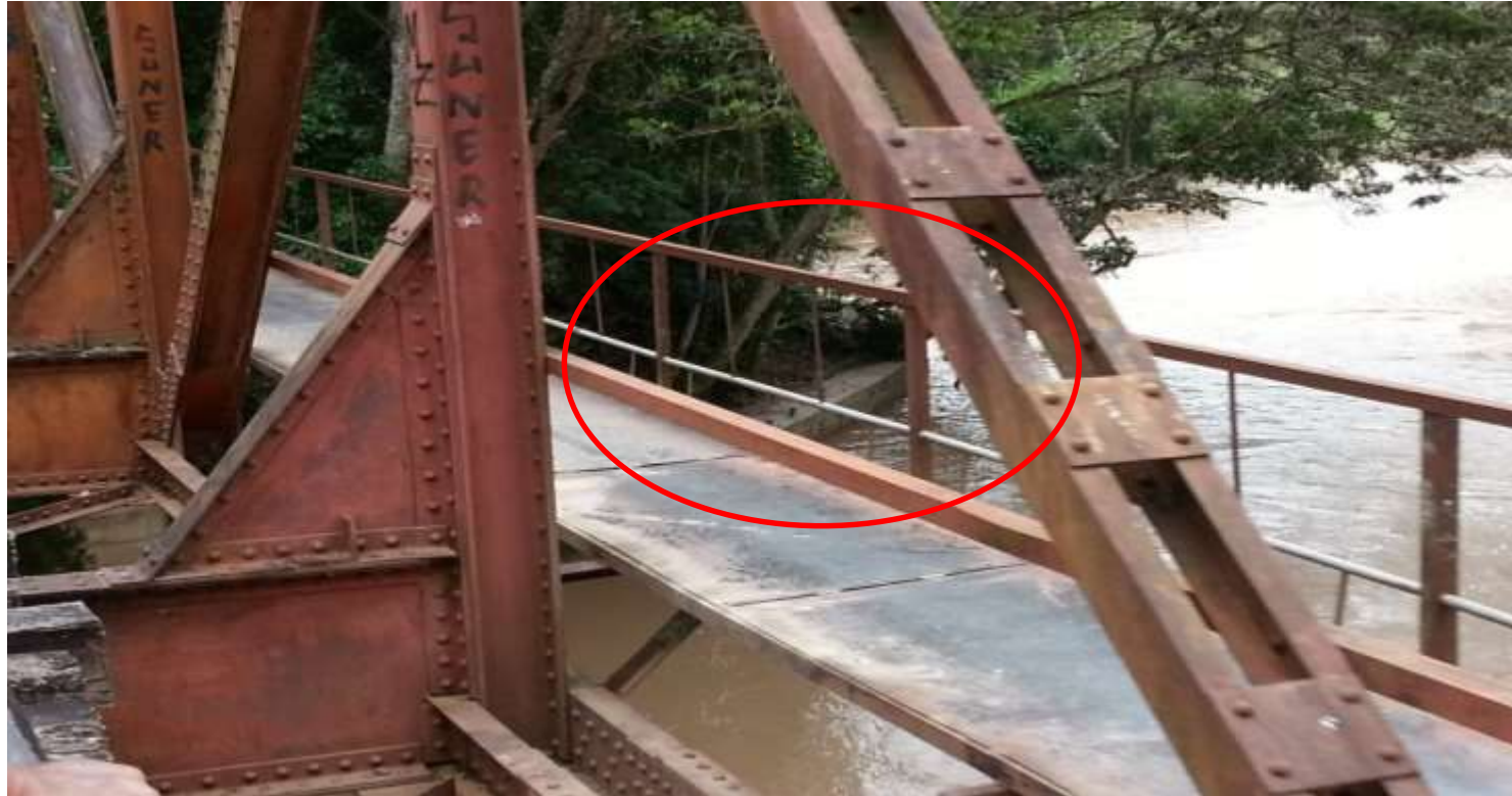
Construcción de la protección del Estribo – Puente San Miguel.
