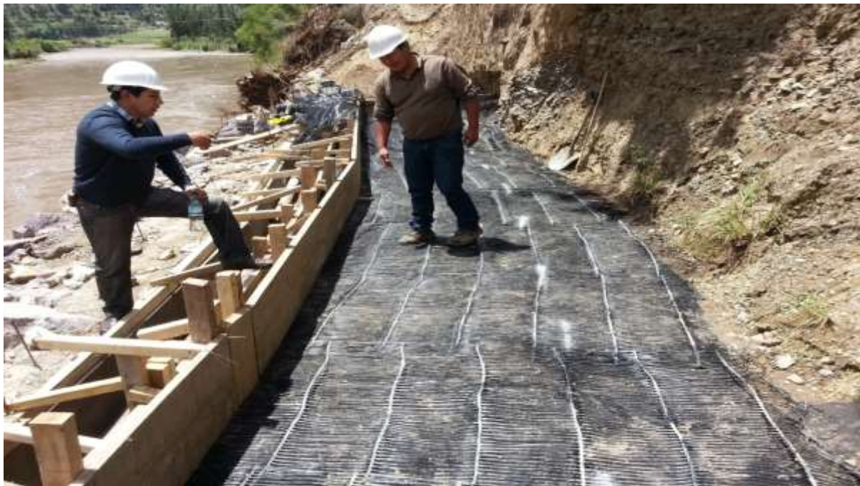
Tendido de geomalla uniaxial para muro du suelo reforzado..
