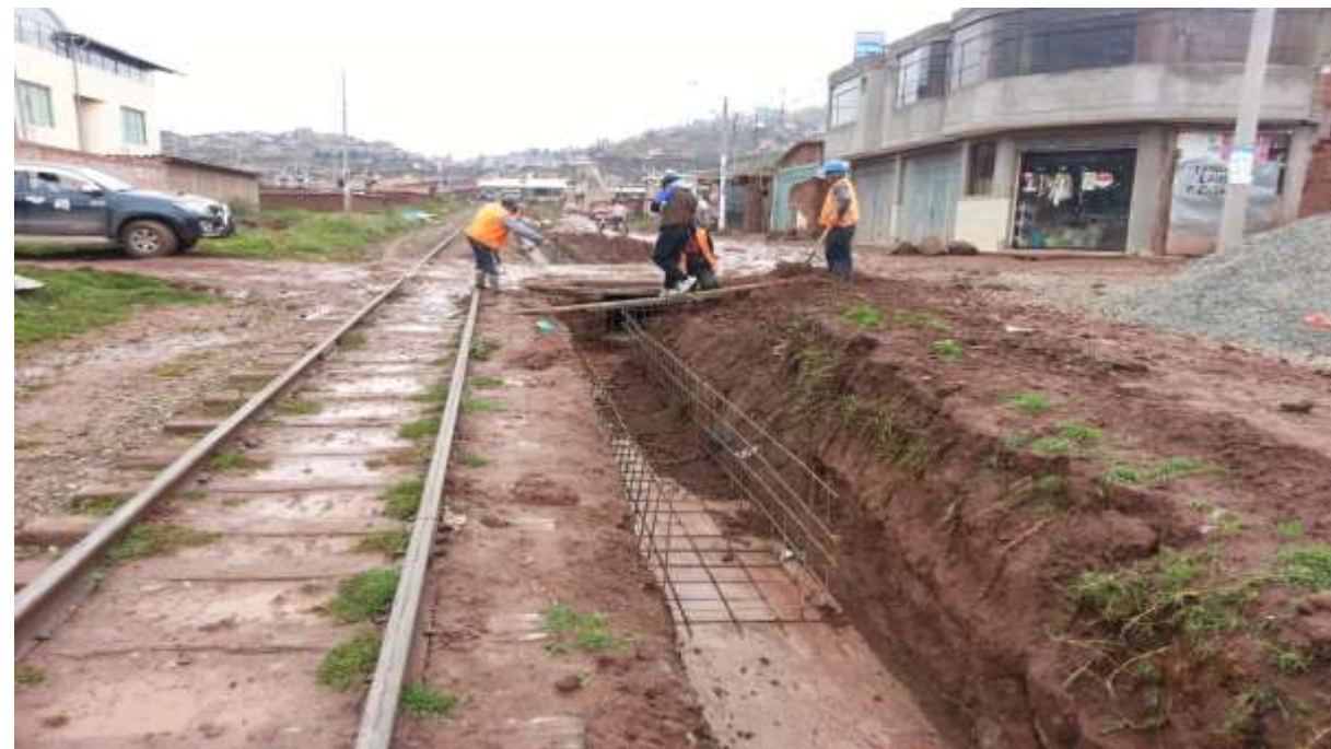
Excavación y Armado de Acero Estructural.
