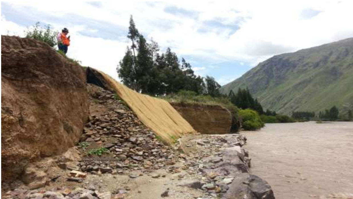
Conformación de talud concluido, proceso de vegetación.
