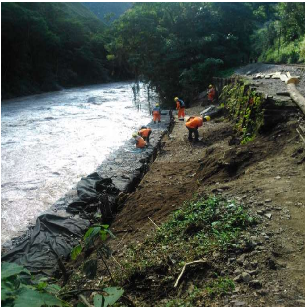
Construcción de la última fila del muro de gaviones.
