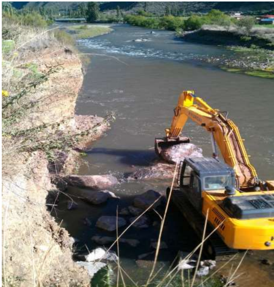
Enrocado, altura 9.00 m.
