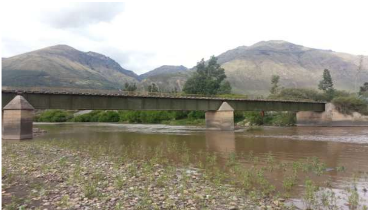
Puente Muyoc con primera capa de pintura.
