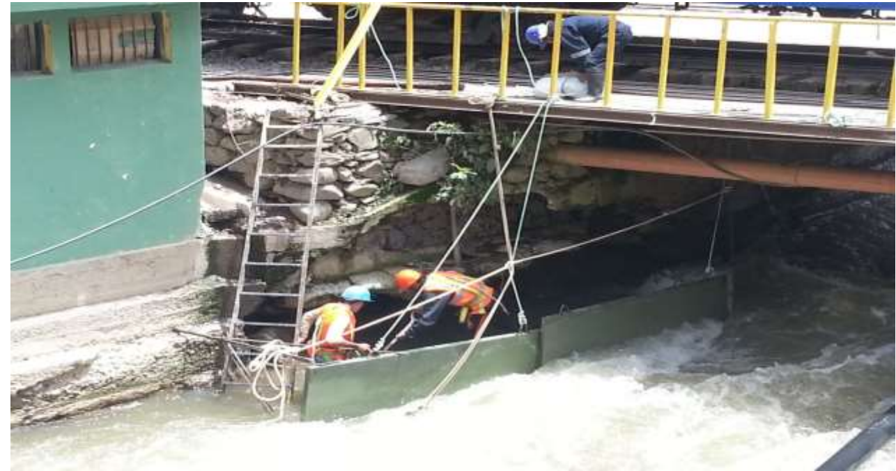
Trabajos de encausamiento del río.
