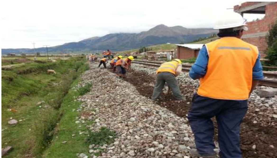
Proceso de excavación para cimiento de los pretiles, el balasto estaba desparramado.
