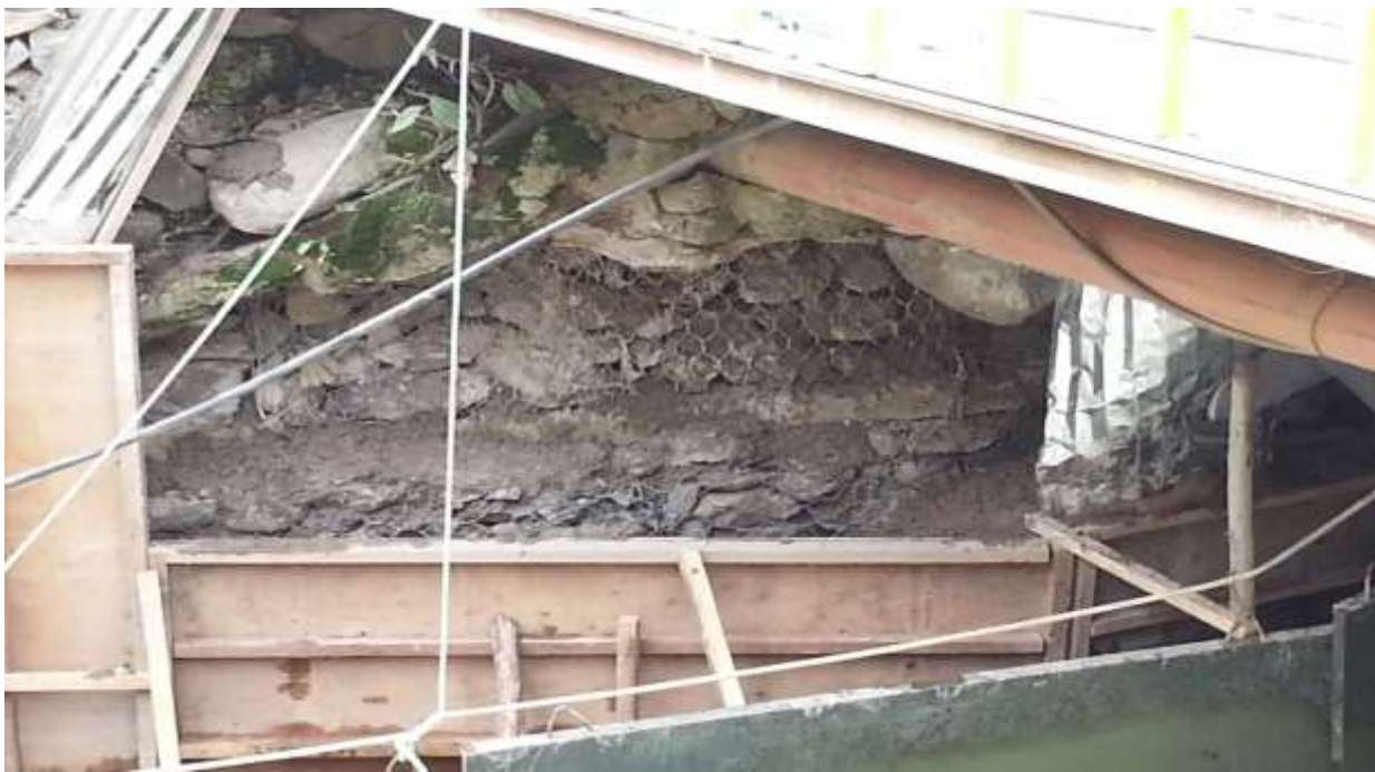
Calzadura de estribo utilizando concreto ciclópeo y gaviones.
