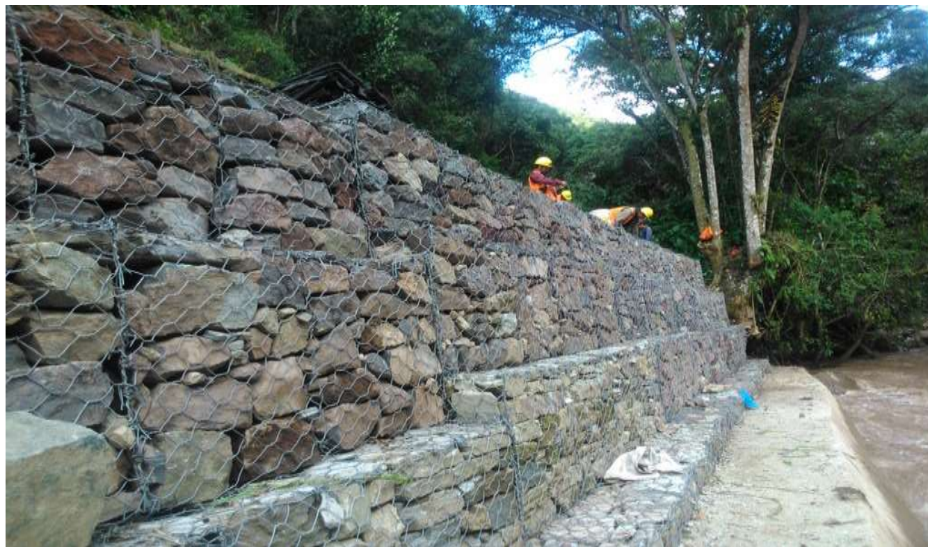
Muro de gaviones concluido..
