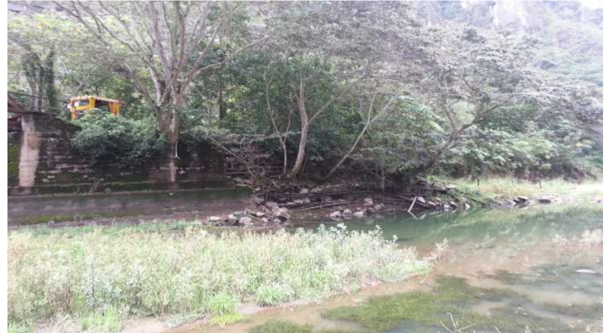
Situación Inicial del Estribo
