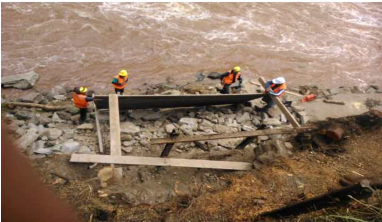
Construcción de cimentación de Concreto Ciclópeo f'c \approx 175 \text{ kg/cm}^2 .
