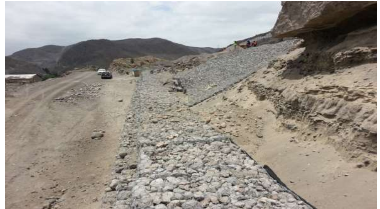
Proceso Constructivo del Muro de Gaviones: 220.50 m 3 Y Colchones de Protección: 104.60 m 3
