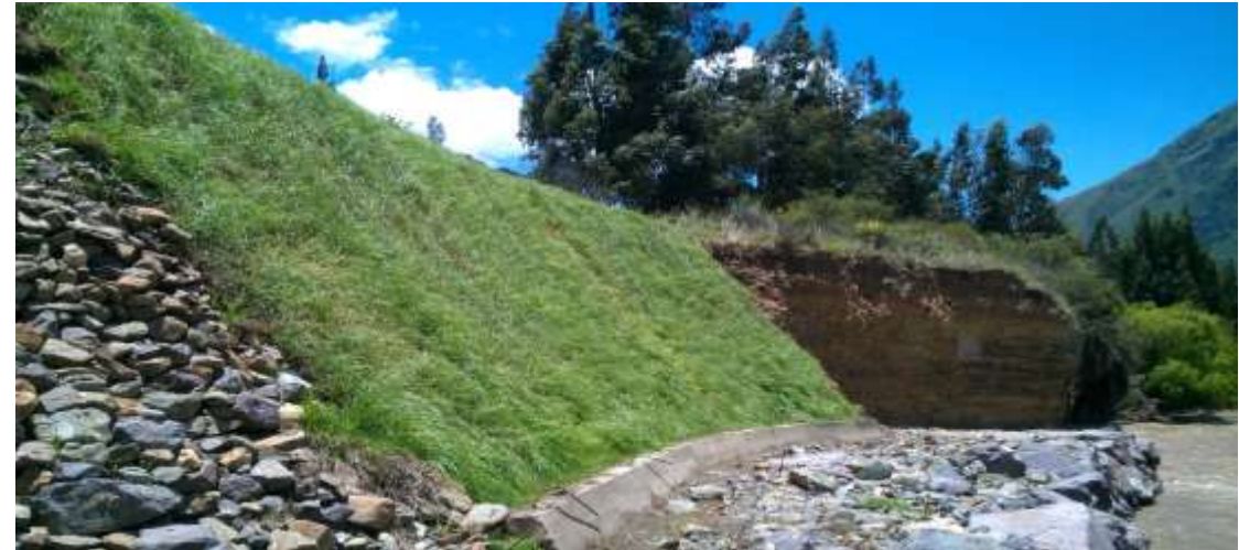
Vegetación de talud concluida..
