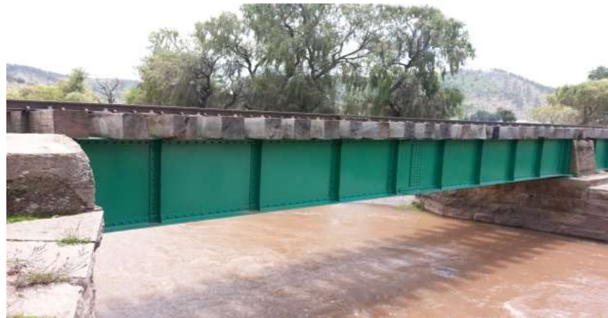
Puente Pichoc con la tercera capa de pintura.
