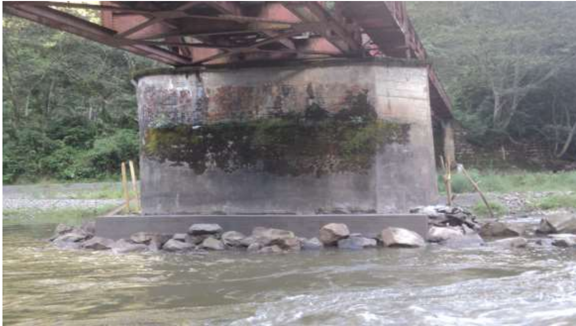
Construcción de la protección del pilar central – Puente San Miguel.
