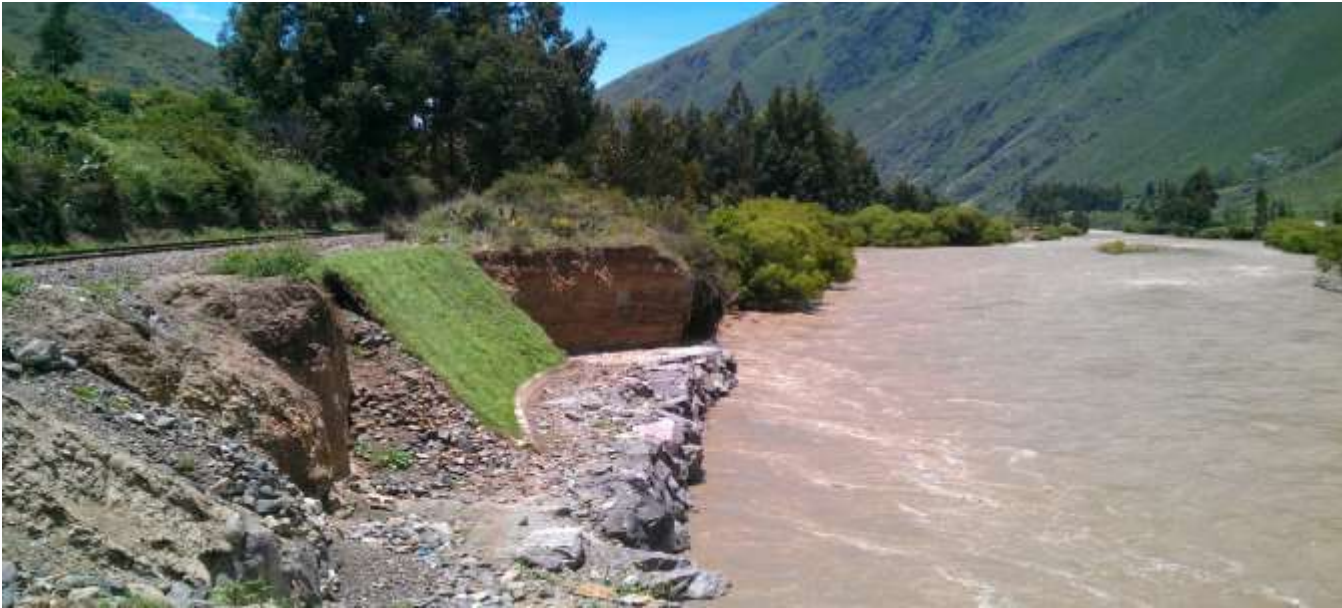
Recuperación de terraplén de la vía férrea concluido.
