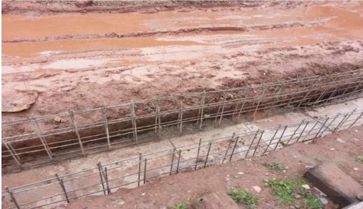
Armado de Acero Estructural.
