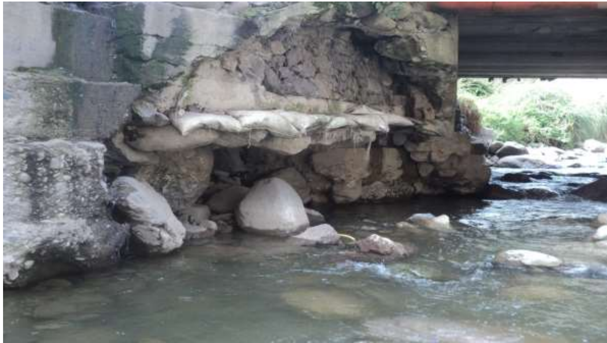
Situación Inicial del Estribo Norte
