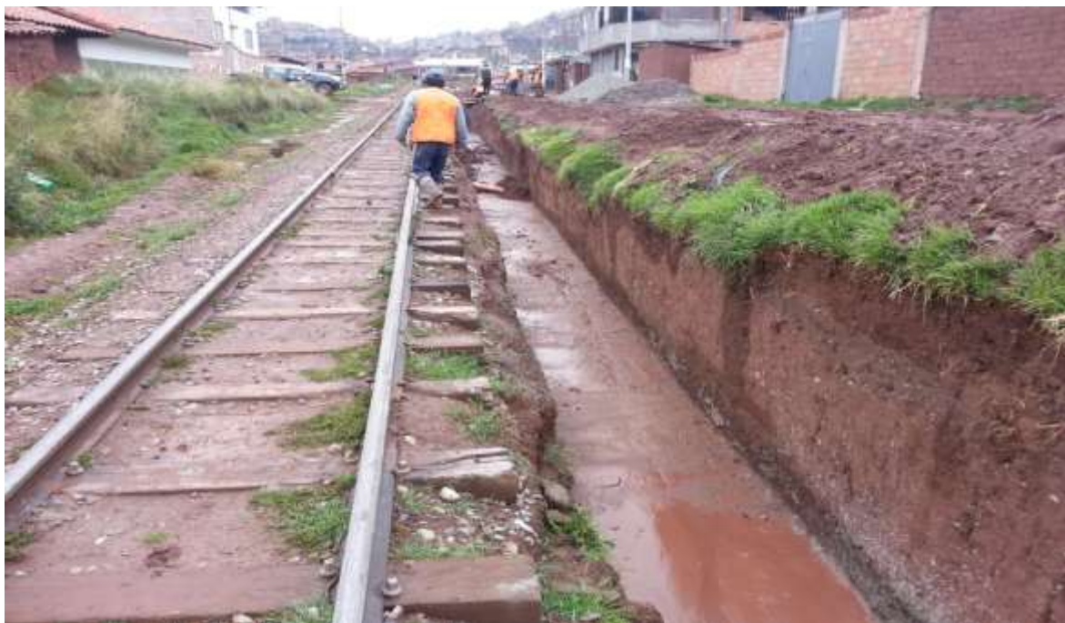
Refine de paredes de zanja existente.
