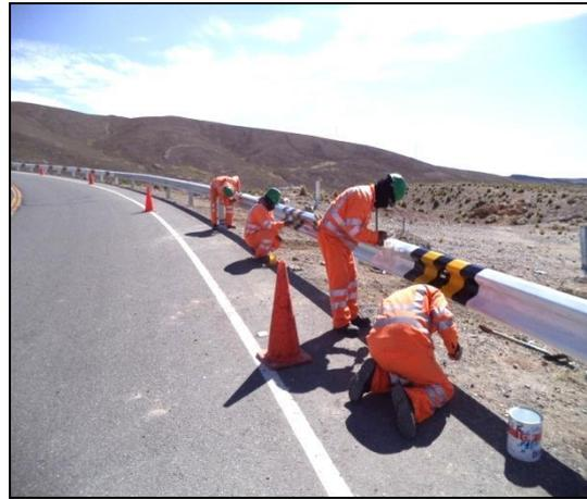
**Trabajos de reposición de captafaros y guardavías metálicos:**
