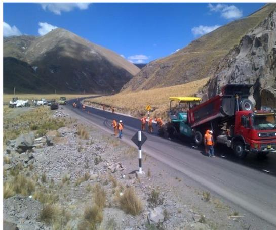
**Colocación de mezcla asfáltica en caliente**
