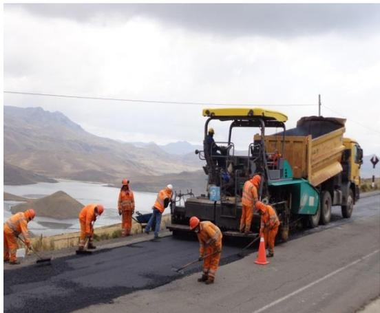
**Colocación de mezcla asfáltica en caliente**
