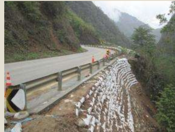
Conformación de talud - Después Sector 3: Loma Larga – Canchaque
