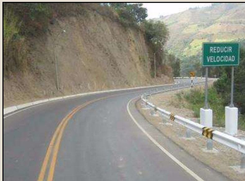
Obras de Rehabilitación del Pavimento en el Tramo 2 y Tramo 3
