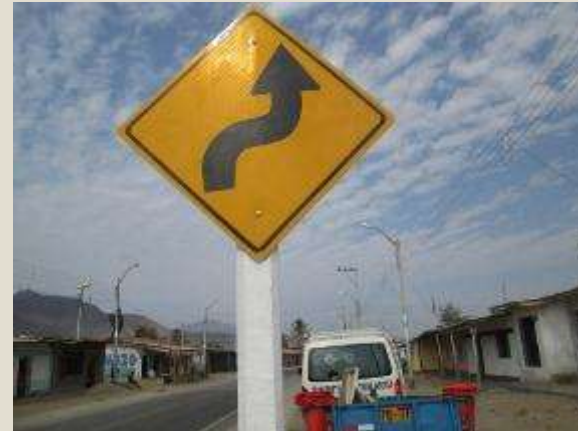
Reposición de señales – Después Sector 3: Piedra Azul – Canchaque
