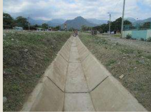
Limpieza de cunetas - Después Sector 2B: Malacasi – Loma Larga
