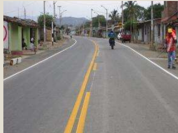
Pintado de señalización horizontal – Después Sector 1: Panamericana Norte Antigua – Buenos Aires
