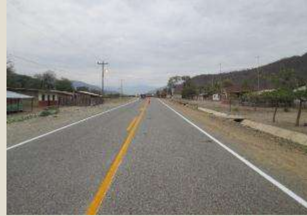
Pintado de señalización horizontal – Después Sector 2B: Malacasi – Loma Larga
