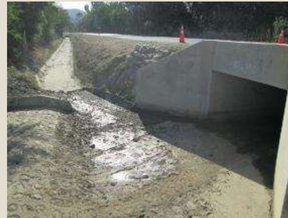
Limpieza de alcantarilla - Después Sector 2A: Buenos Aires - Malacasi
