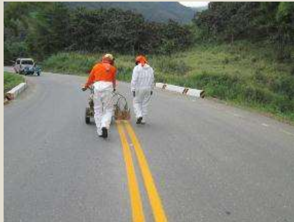
Pintado de señalización horizontal – Antes Sector 3: Loma Larga – Canchaque
