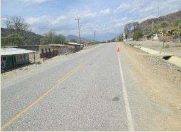
Pintado de señalización horizontal – Antes Sector 2B: Malacasi – Loma Larga
