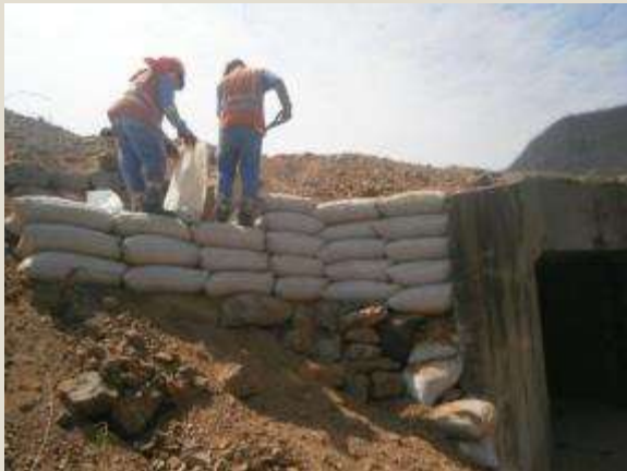
Conformación de talud en alcantarilla - Antes Sector 1: Panamericana Norte Antigua – Buenos Aires
