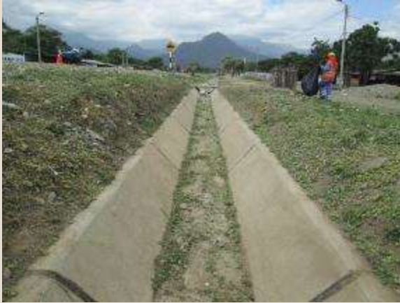
Limpieza de cunetas - Antes Sector 2B: Malacasi – Loma Larga
