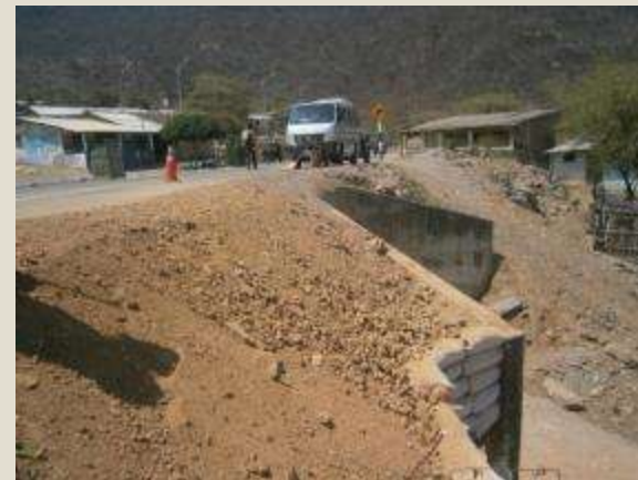
Conformación de talud en alcantarilla - Después Sector 1: Panamericana Norte Antigua – Buenos Aires
