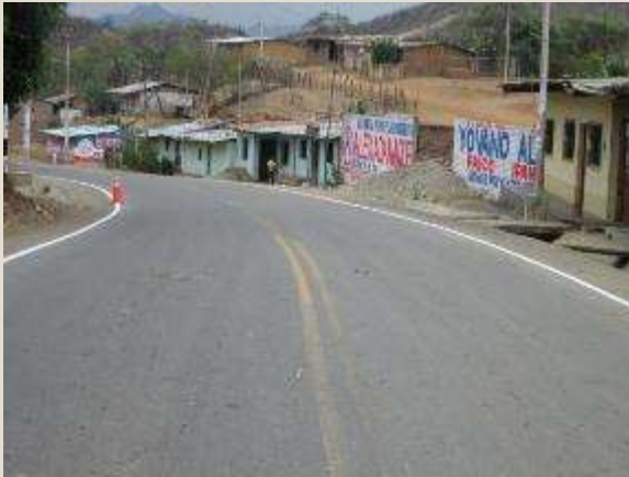
Pintado de señalización horizontal – Antes Sector 1: Panamericana Norte Antigua – Buenos Aires
