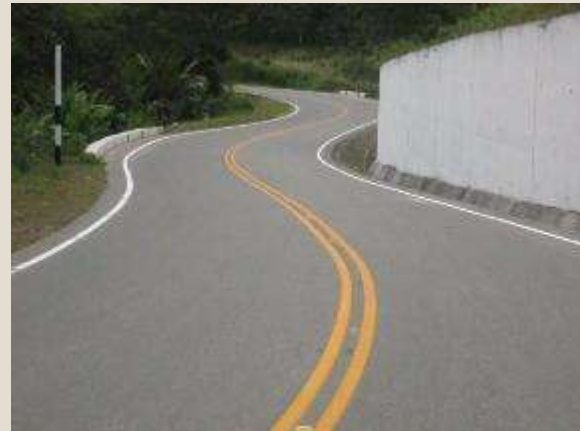
Pintado de señalización horizontal – Después Sector 3: Loma Larga – Canchaque
