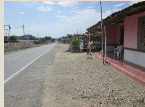
Limpieza de bermas - Después Sector 2A: Buenos Aires - Malacasi
