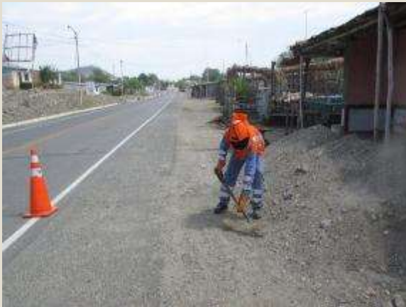
Limpieza de bermas - Antes Sector 2A: Buenos Aires - Malacasi
