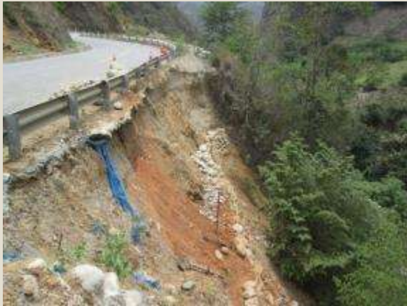
Conformación de talud - Antes Sector 3: Loma Larga – Canchaque
