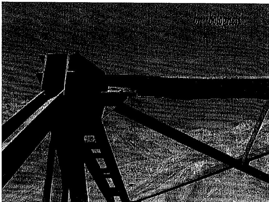
Arcos metálicos del puente corroídos y rotos
