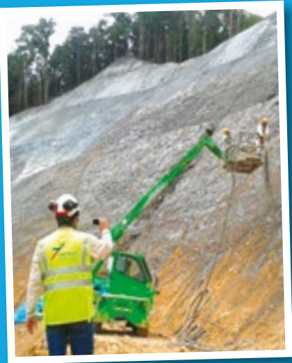
Leyenda: Estabilización de taludes km 434
