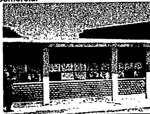
Edificios adyacentes a la plataforma comercial, cuya demolición debería efectuarse
