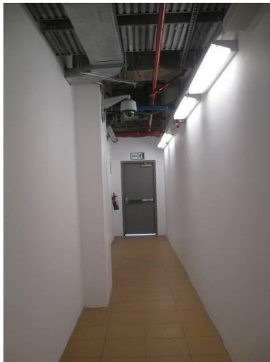
Corredor de evacuación
