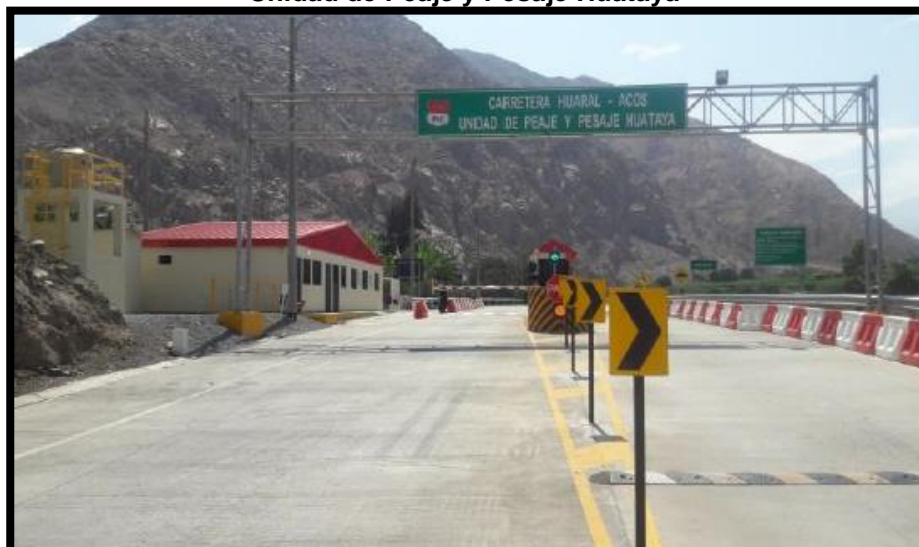
Figura N° 2 Unidad de Peaje y Pesaje Huataya
