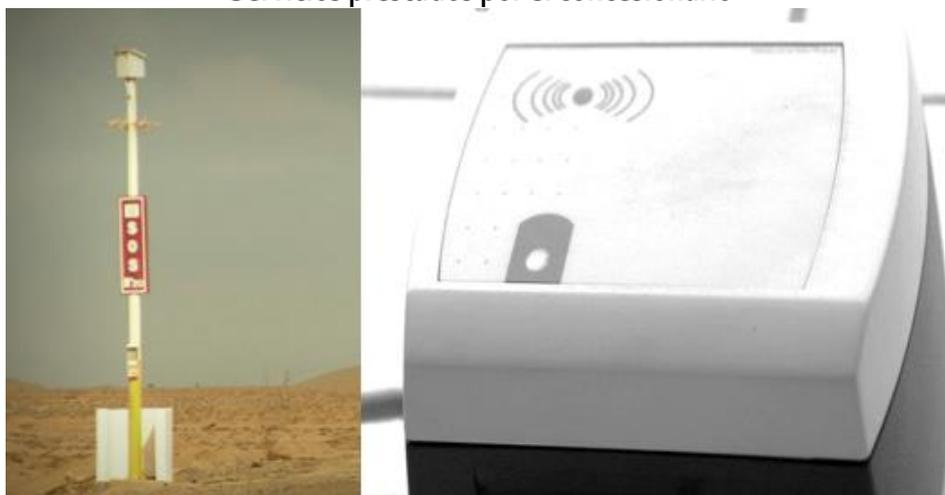
25. La Figura N° 2 muestra un Poste SOS con tecnología de señal en tiempo real que permite comunicarse con la Central de Emergencia del tal modo que puedan acudir en su auxilio. En el otro lado se encuentra la máquina controladora de Tarjetas de Prepago que sirve como medio de pago del Peaje.
