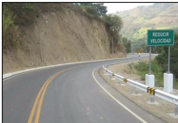
Figura N° 2 Rehabilitación- Pavimento Tramo II
