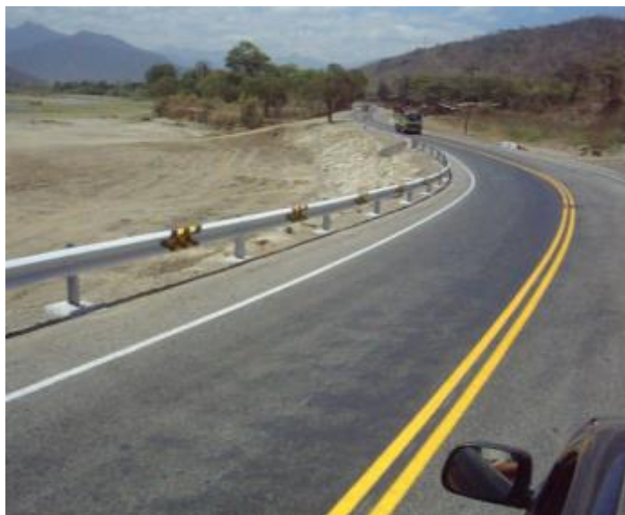
Figura N° 2: REHABILITACIÓN – PAVIMENTO TRAMO II
